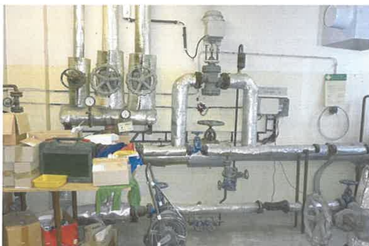
Havarijní ventil, horkovodní rozdělovač
