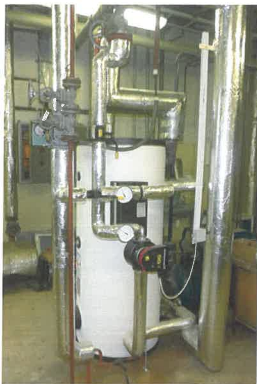
Deskový výměník se zásobníkem pro ohřev TV
