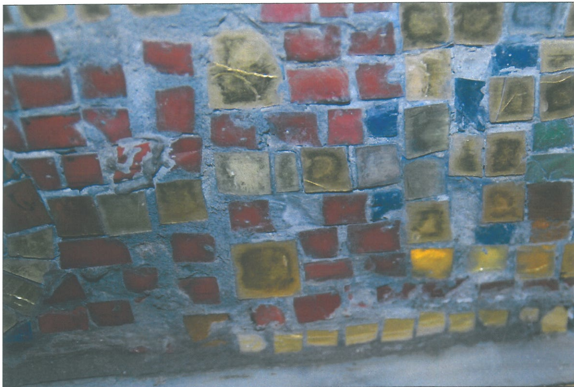
Znečištění povrchu skel a optické změny zlatých skel
