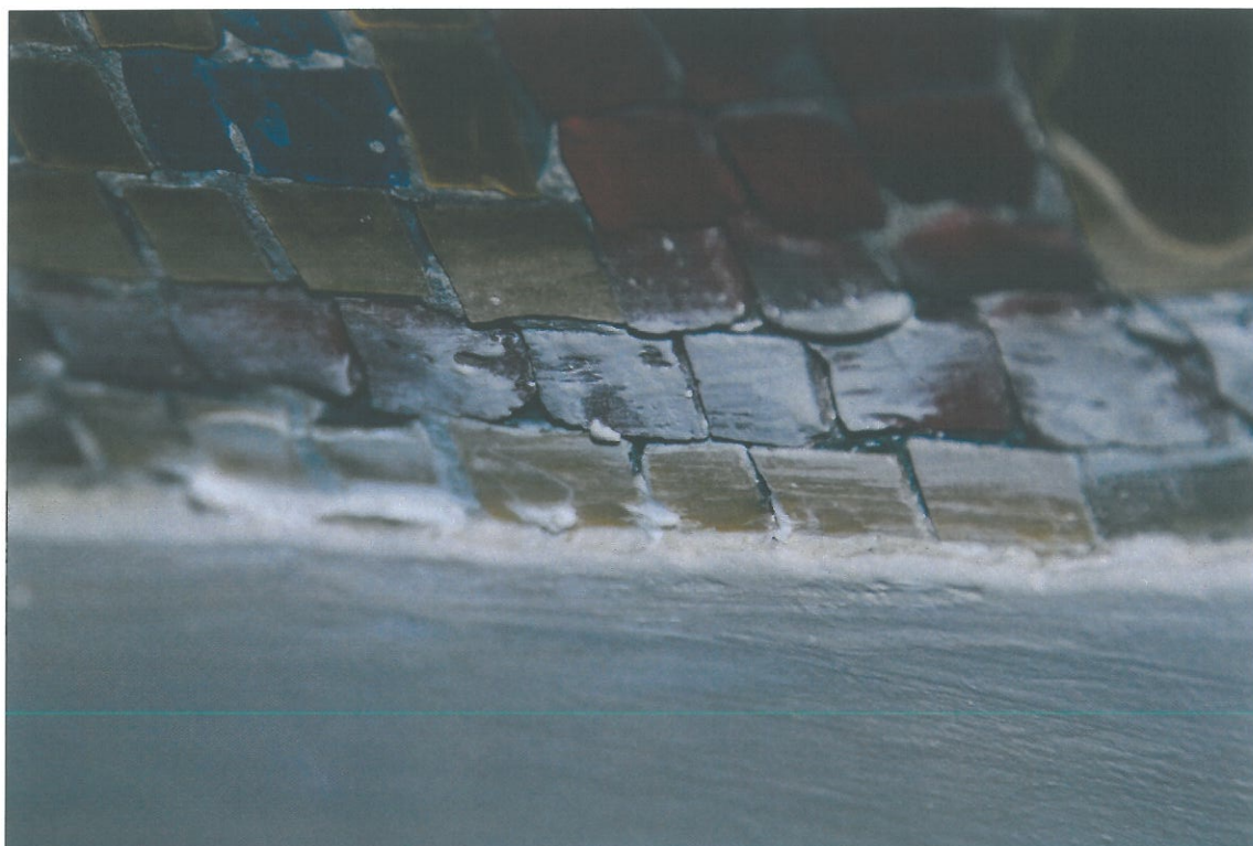
Znečištění povrchu nátěrem, lokálně vypadané spárování
