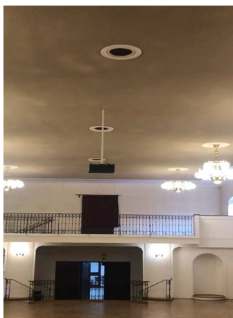
Odvodní stropní výústky
