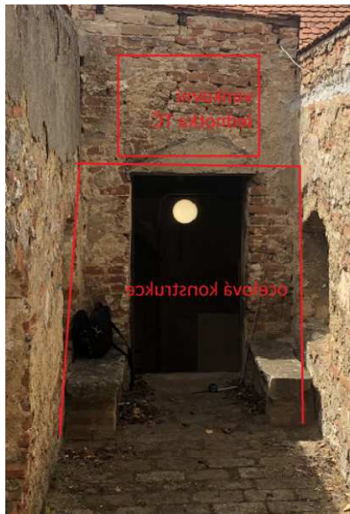
Umístění venkovních jednotek
