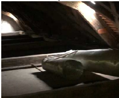
Demontované potrubí sání
