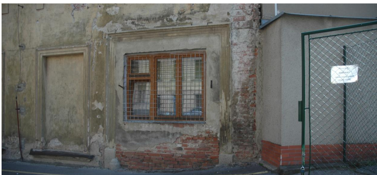
Východní fasáda východního křídla (školní dvůr). V levé krajní ose nalezeno kamenné ostění zaniklého vstupu, respektive vjezdu. Viz obrázek níže.
