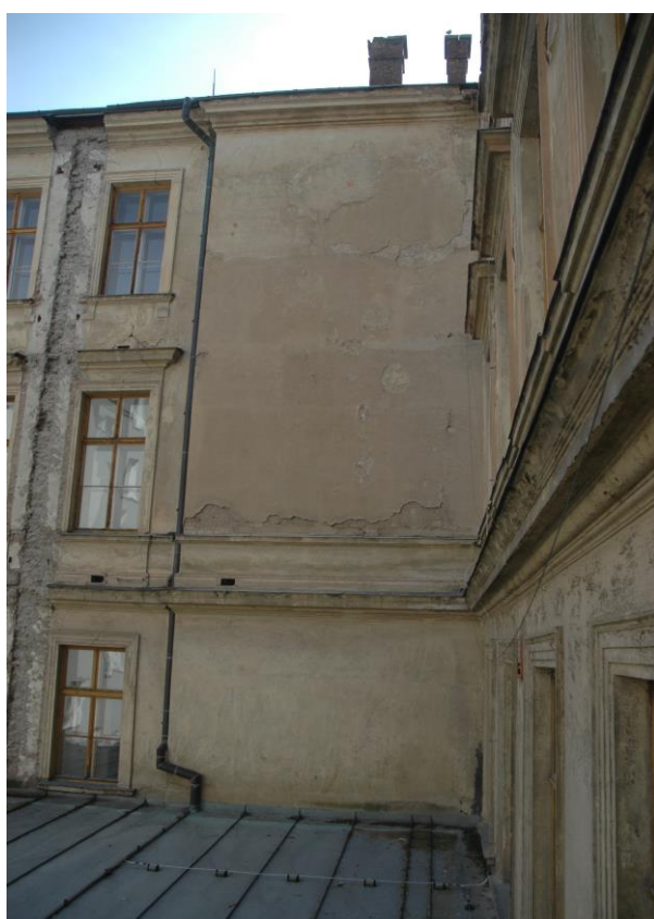
Krajní okenní osa východní fasády západního křídla. Statická porucha (?) - prasklina probíhající přes profilaci korunní římsy, okenního překlady a parapetu okna ve IV. NP, zasahující přes hmotu nadokenní římsy a okenního překlady ve III. NP.
