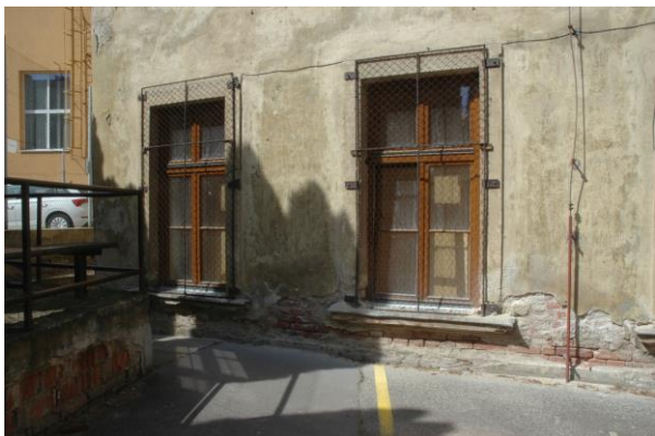
Detaily dochovaných profilací parapetních říms oken přízemí, které byly při obnově tvarově zjednodušeny.
