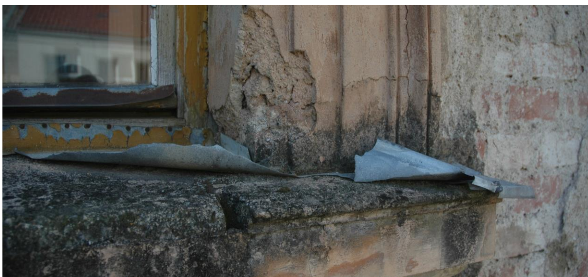
Na fotografii je patrné charakteristické rozpraskání pevné omítkové vrstvy na bázi hydraulického vápna zejména na namáhaných profilacích. Rychlejší degradace částí nad klempířskými prvky jistě
