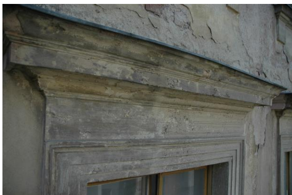
Detailní pohled na stav omítkových souvrství fasády severního průčelí přístavby. Omítky pasivních ploch jsou zcela dožilé. Profilované šambrány zhotovené z románského cementu jsou i přes dílčí poruchy stále soudržné a je možno je na rozdíl od sekundárních omítek pasivních ploch odborně opravit, stejně jako nadokenní římsy a suprafenestry na obrázcích níže.
