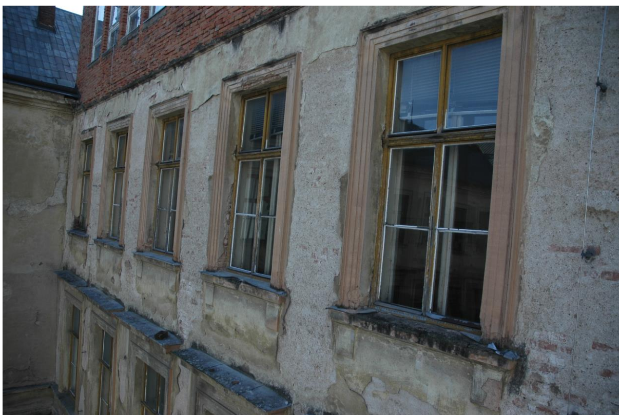
Detailní pohled na stav omítkových souvrství fasády severního průčelí přístavby. Omítky pasivních ploch jsou zcela dožilé. Profilované šambrány zhotovené z románského cementu jsou i přes dílčí poruchy stále soudržné a je možno je na rozdíl od sekundárních omítek pasivních ploch odborně opravit, stejně jako nadokenní římsy a suprafenestry na obrázcích níže.
