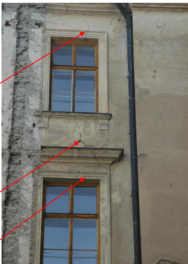
Krajní okenní osa východní fasády západního křídla. Statická porucha (?) - prasklina probíhající přes profilaci korunní římsy, okenního překlady a parapetu okna ve IV. NP, zasahující přes hmotu nadokenní římsy a okenního překlady ve III. NP.
