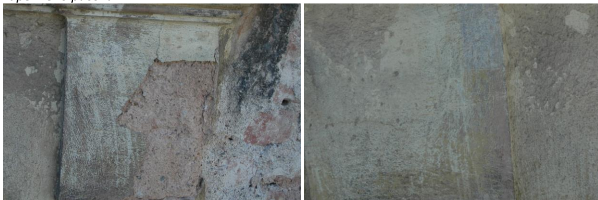
Celkový pohled a detail fragmentů sekundárních úprav na tektonickém prvku – konzola parapetní římsy okna
