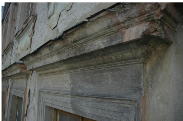
Detailní pohled na stav omítkových souvrství fasády severního průčelí přístavby. Omítky pasivních ploch jsou zcela dožilé. Profilované šambrány zhotovené z románského cementu jsou i přes dílčí poruchy stále soudržné a je možno je na rozdíl od sekundárních omítek pasivních ploch odborně opravit, stejně jako nadokenní římsy a suprafenestry na obrázcích níže.
