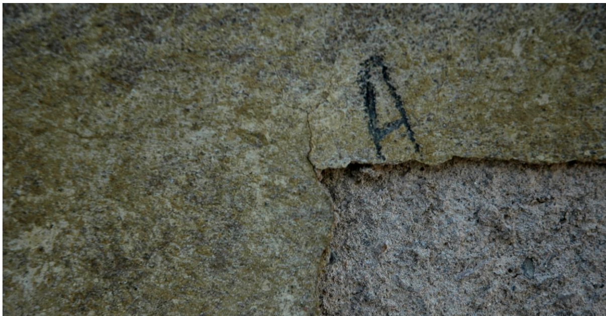
Místo odběru vzorku A. Na povrchu omítky patrné fragmenty světle okrového nátěru naneseného na podkladovou vrstvu bílého vápenného pačoku.
