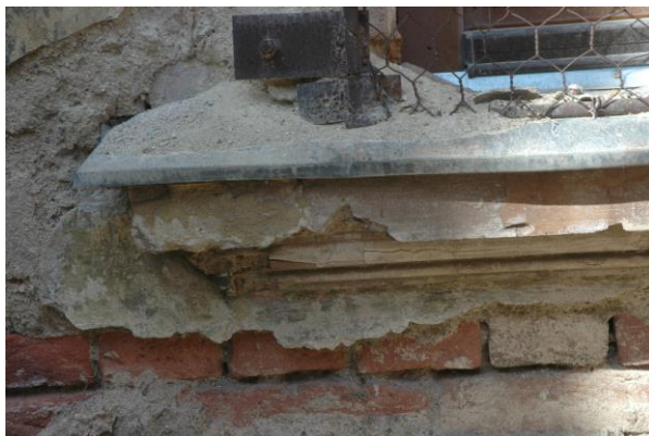
Detaily dochovaných profilací parapetních říms oken přízemí, které byly při obnově tvarově zjednodušeny.
