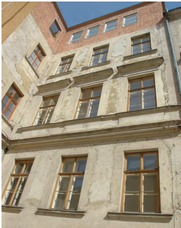
Kolem oken jsou patrné stopy po zaniklých šambránách
