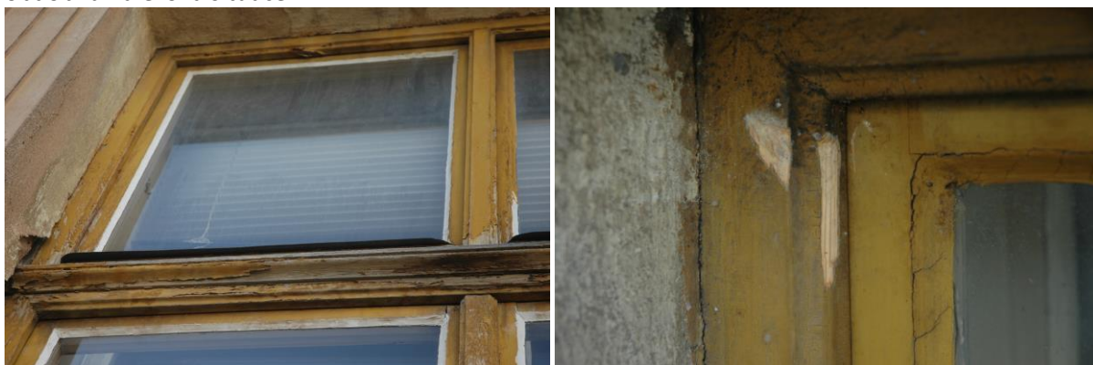
Místa odběrů vzorku D okenní rám exteriérová strana. Celkový pohled a detail místa odběru.
