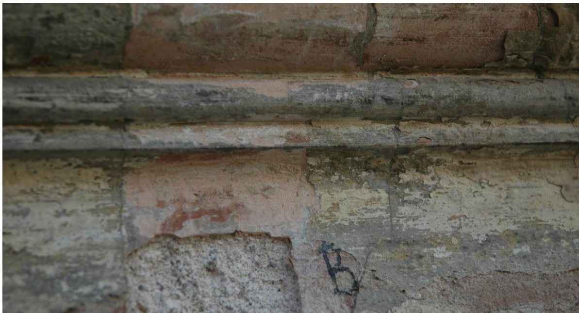
Místo odběru vzorku B – fragment původních omítek pasivní plochy dochovaný pod parapetní římsou okna.
