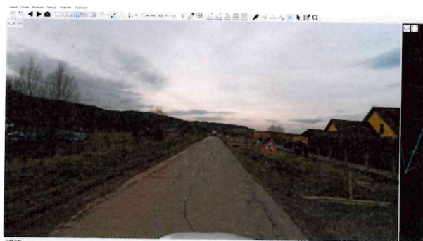
Začátek úseku, síťové trhliny
