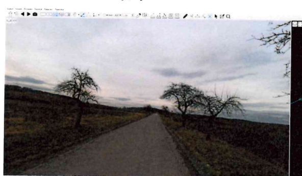
Síťové trhliny, podélné rozv. trhliny
