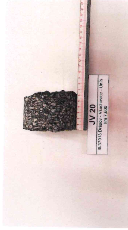
Foto č. 22 – Detail vývrtnu č. 20
