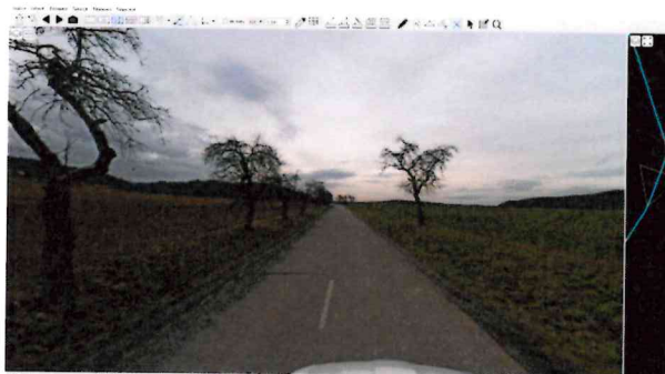
Mozaikové trhliny, pod. a příč. trhliny, vysprávký
