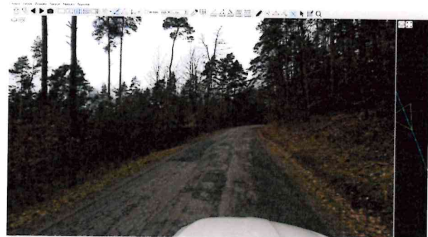
Síťové trhliny, výtluky, vysprávký
