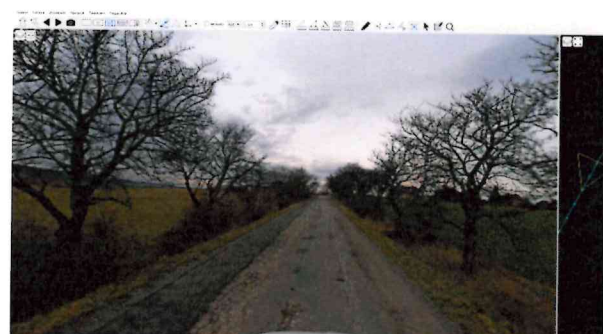
Síťové trhliny, výtluky, vysprávký
