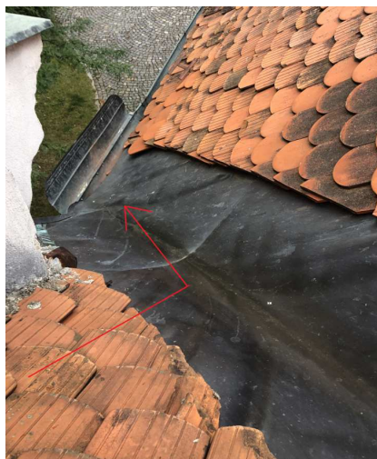
Odvod kondenzátu od vnitřních jednotek – západní fasáda
