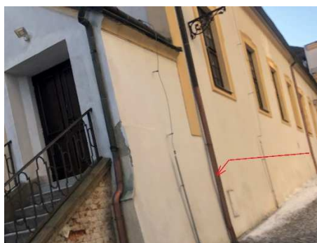
Odvod kondenzátu od vnitřních jednotek – západní fasáda
