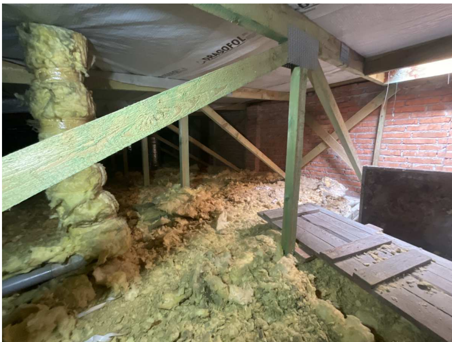
provedení spádu střešní konstrukce, stávající tepelná izolace stropu
