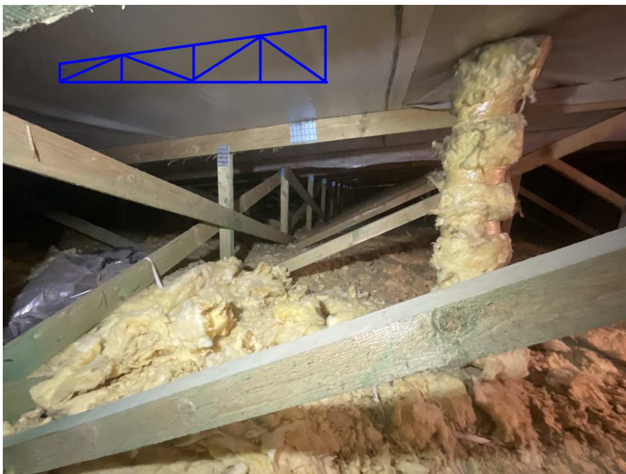
tvarové řešení vazníků v levé části (nad jídelnou)
