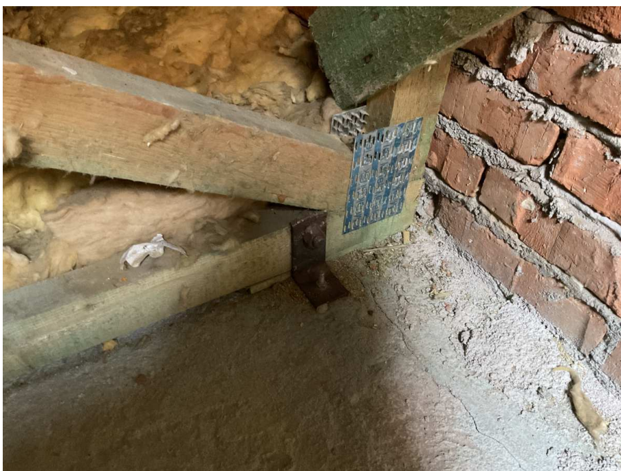
uložení střešních vazníků na obvodové ztužidlo a strop, přikotvení proti sání větru
