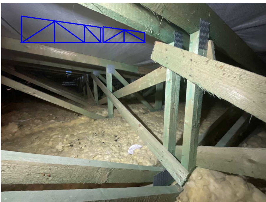
tvarové řešení vazníků v pravé části (směr k tělocvičně)
