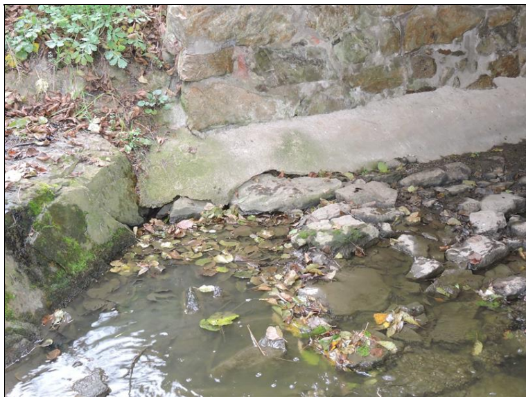
Rozpad ochranného betonového prahu pata OP1
