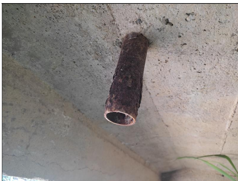
Odvodňovací trubička v pravém krajním poli
