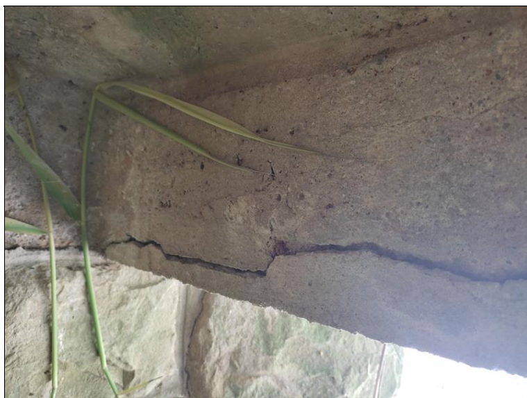
Trhlina na spodním líci levého krajního trámu
