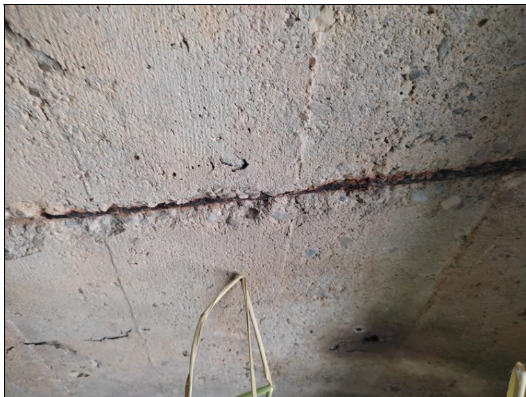
Nedostatečně krytí výztuže na podhledu NK
