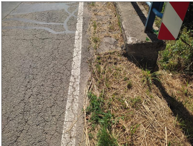
Propad vozovky na levé straně v předpolí OP2
