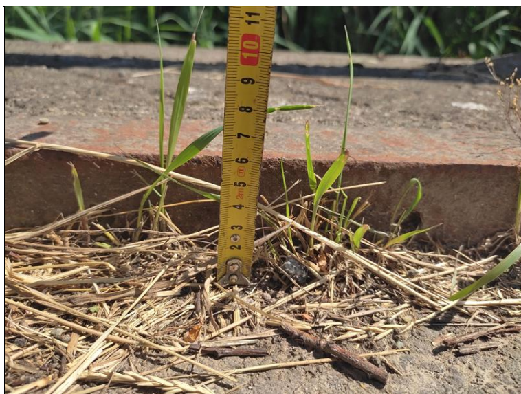
Nedostatečná výška řimsy nad vozovkou
