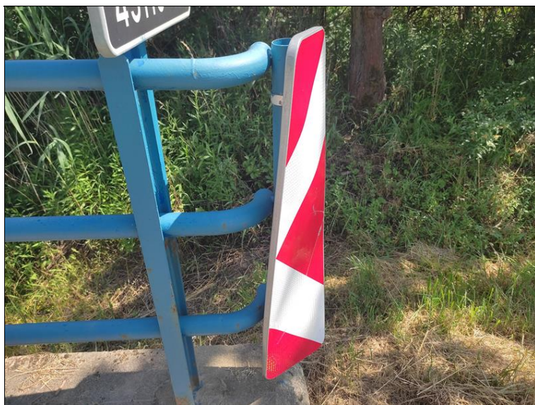
Deformace směrové desky na levé straně OP1
