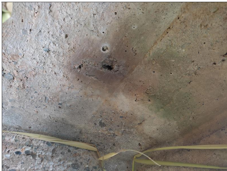
Stopy po zatékání v levém krajním poli u OP1
