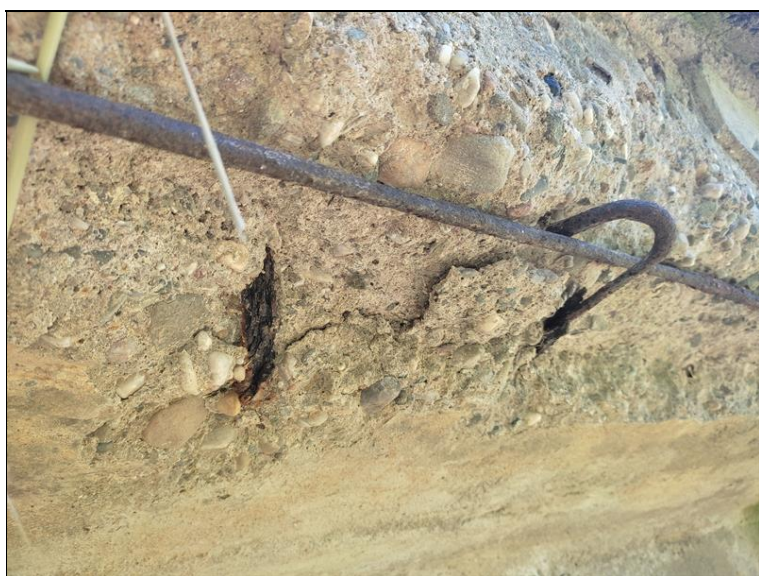
Koroze výztuže boku pravé římsy
