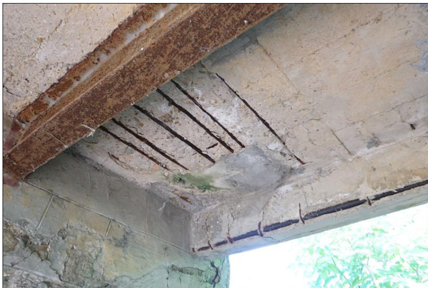
Detail pohledu NK, odpadávající vrstvy betonu až na nosnou výztuž, která koroduje. Koroze ocelových nosníků.
