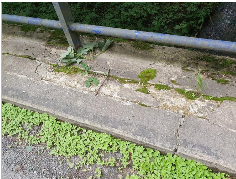
Rozpad povrchu říms
