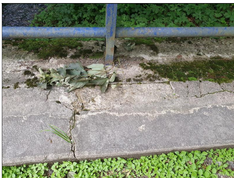
Rozpad povrchu říms
