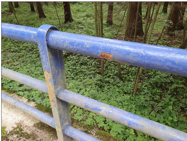
Koroze zábradlí
