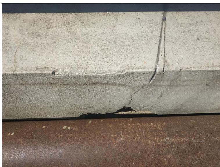
Lokální degradace betonu levé řimsy.jpg
