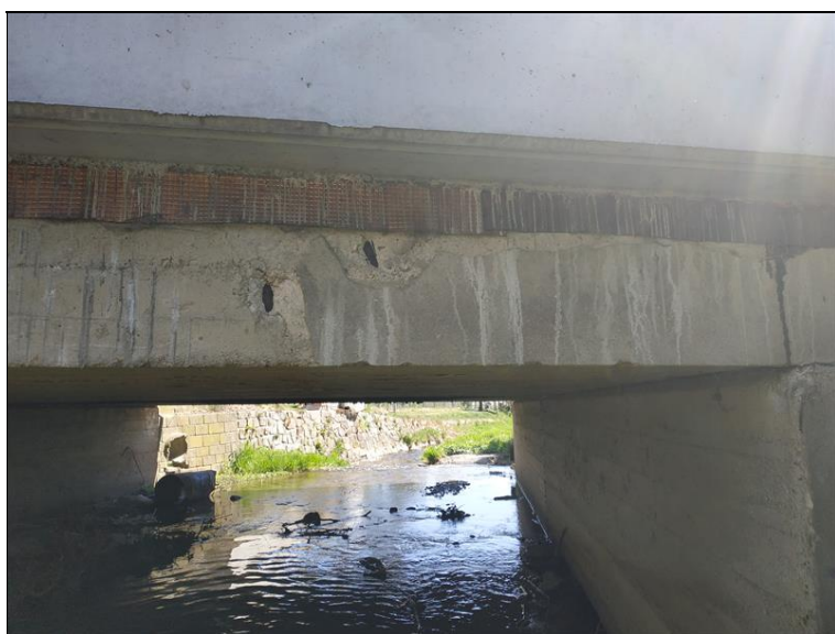
Zatékání na pravý bok NK a lokální odhalení výztuže.jpg
