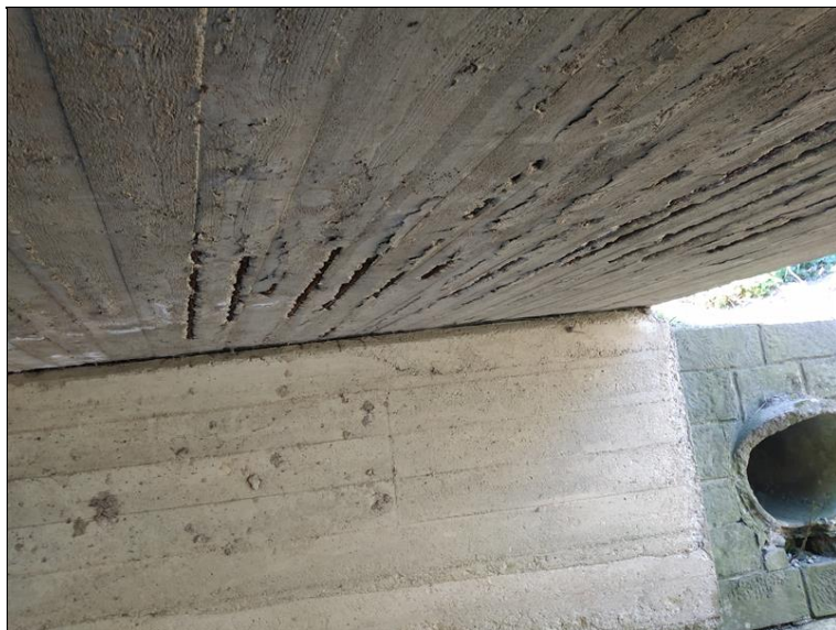
Nedostatečná krycí vrstva u podélné výztuže a její koroze 2.jpg
