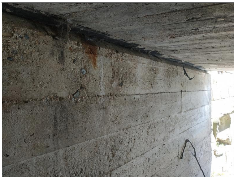
Lokální průsak vody pod úložným prahem na OP2.jpg
