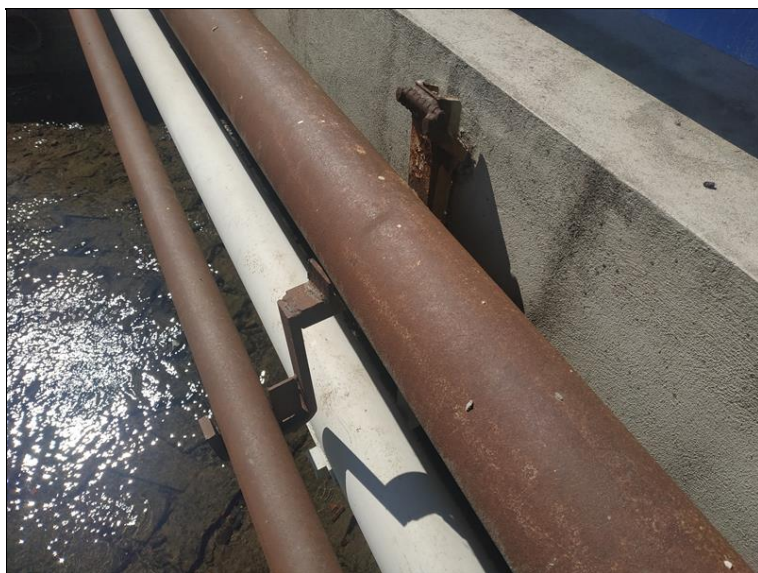
Koroze konzol vynášejících chráničky.jpg
