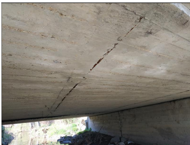
Nedostatečná krycí vrstva u příčné výztuže.jpg
