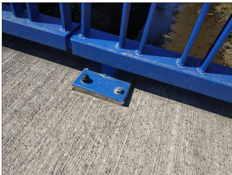
Chybějící krytka šroubu uchycení pravého zábradlí.jpg
