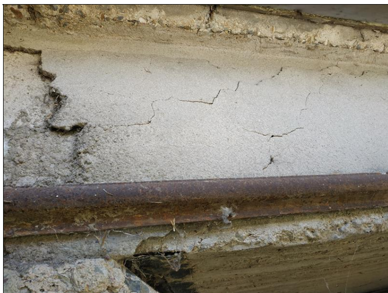
Trhliny v omítce na levém lici NK u OP2.jpg
