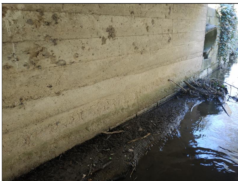
Zatékání na OP2 a degradace betonu.jpg
