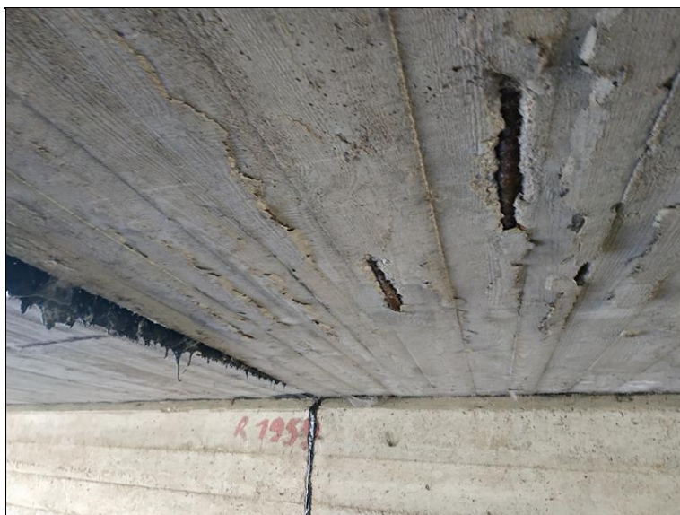
Nedostatečná krycí vrstva u podélné výztuže a její koroze.jpg
