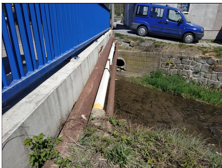
Koroze kovových chrániček vlevo.jpg
