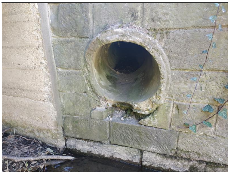
Zatékání na nábrežní zídce u OP2 vpravo a vydrolení spár kamenného zdiva.jpg
