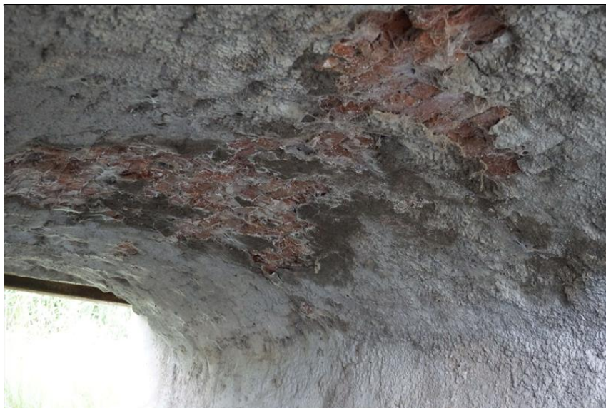
Detail pohledu nosné konstrukce, odpadaný torkret.
