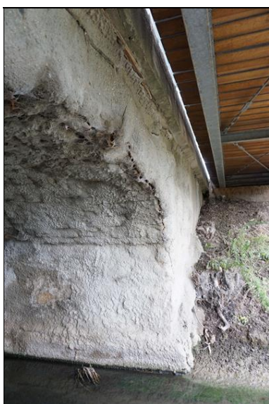
Detail levého čela klenby, podélná trhlina na celou délku čela.
