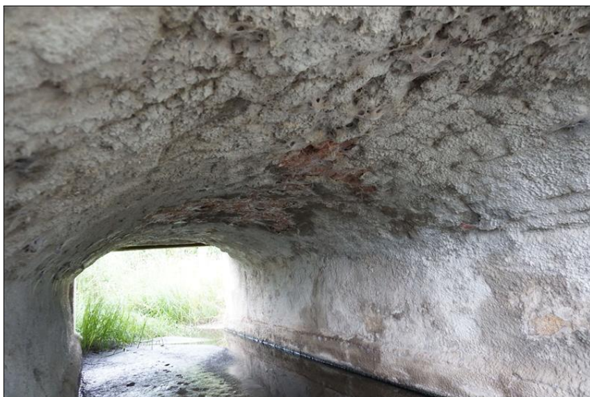
Detail levého čela klenby, podélná trhlina na celou délku čela.
