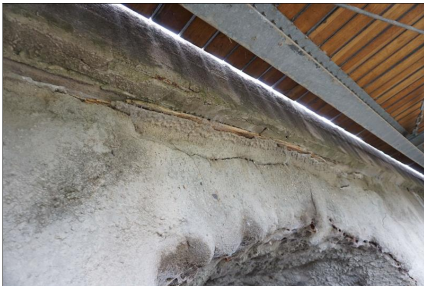
Detail levého čela klenby, mnohačetné trhliny v torkretu.
