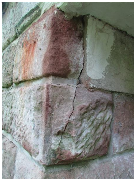
Trhlina v Op2 vlevo
