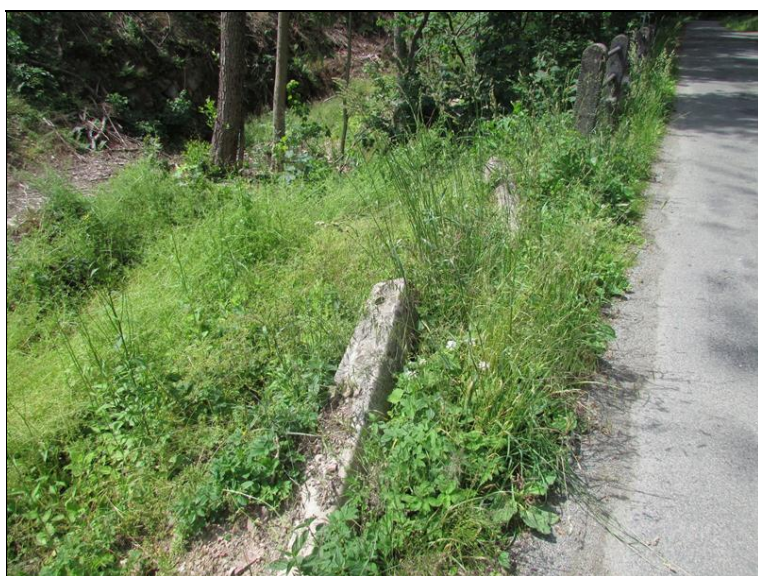
Sloupky lanového svodidla za mostem vpravo vyvrácené zřejmě dřevaři
