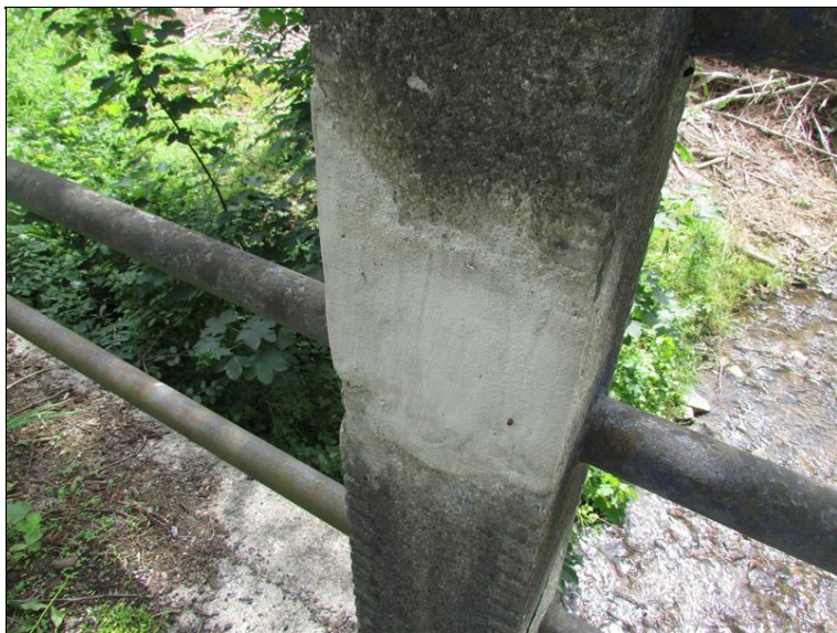
Sanované sloupky zábradlí
