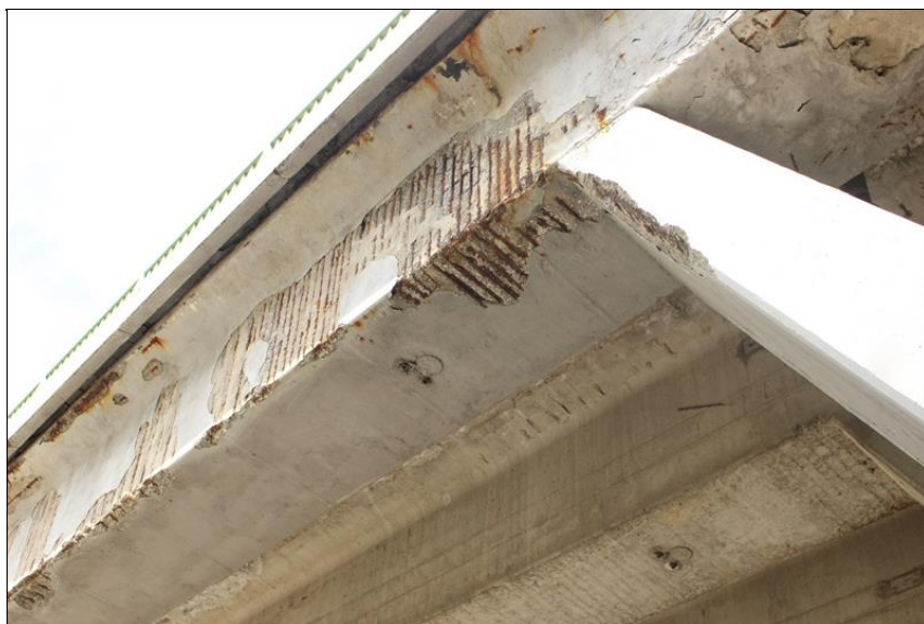
16-krajní nosník koroze výztuže.JPG
