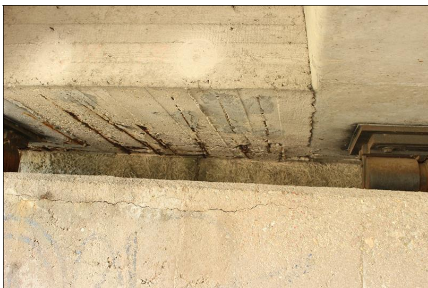
14-koroze výztuže na koncovém příčniku opěry 1.JPG
