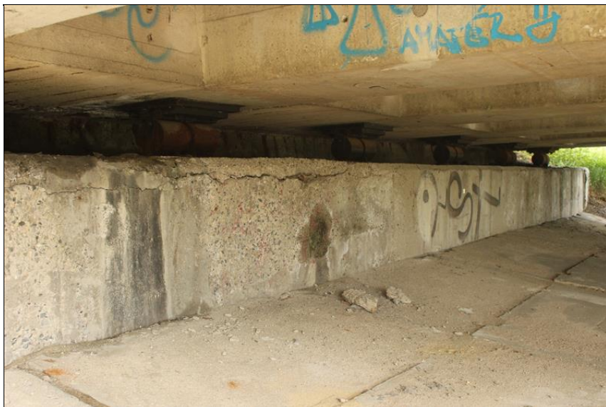
19-pohled na opěru 4 - vodorovná trhlina v úložném prahu.JPG
