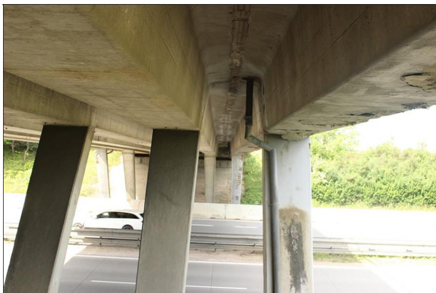
13-výluhy ve spáře mezi krajními nosníky.JPG
