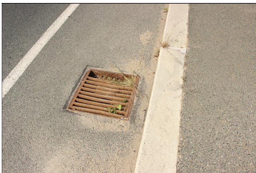
06-poškozená mříž odvodňovače.JPG
