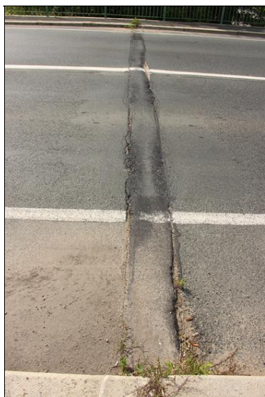
05-netěsnící mostní závěr nad opěrou 1.JPG
