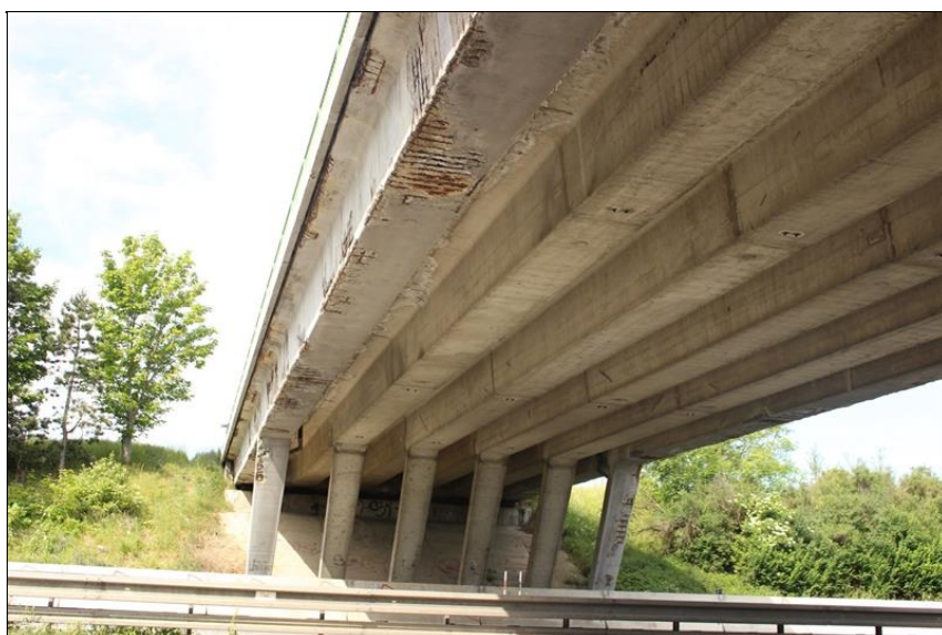
17-celkový pohled na střední pole - krajní nosník koroze výztuže.JPG
