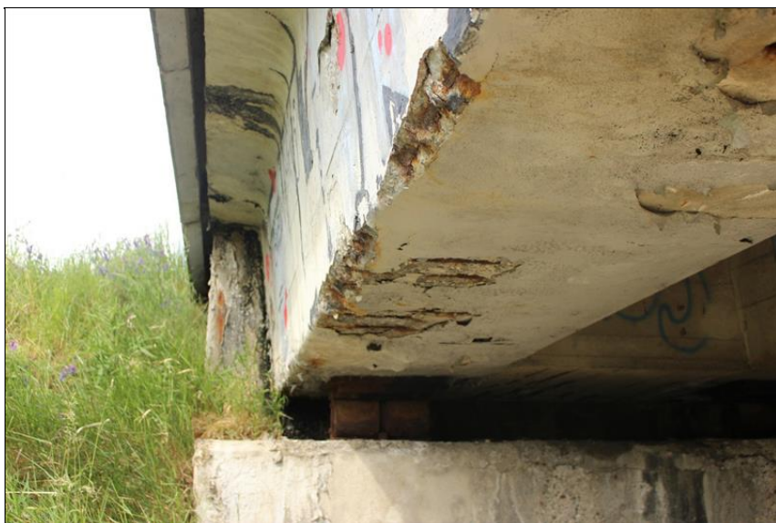
20-krajní nosník u opěry 4-odpadaná vrtva betonu - koroze výztuže.JPG
