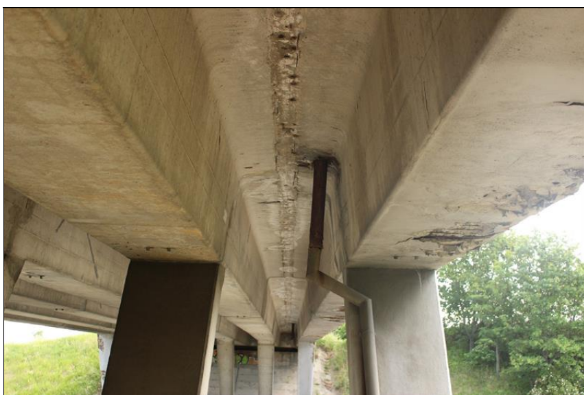
21-vápenné výluhy mezi nosníky v oblasti pilíře 3.JPG
