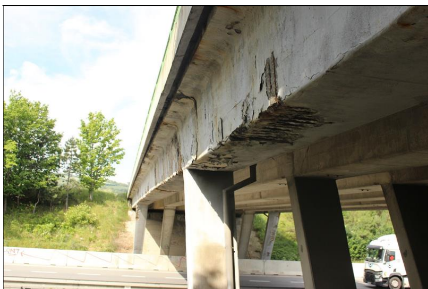
15-krajní nosník vlevo - odpadlá krycí vrstva výztuže - korodující výztuž.JPG
