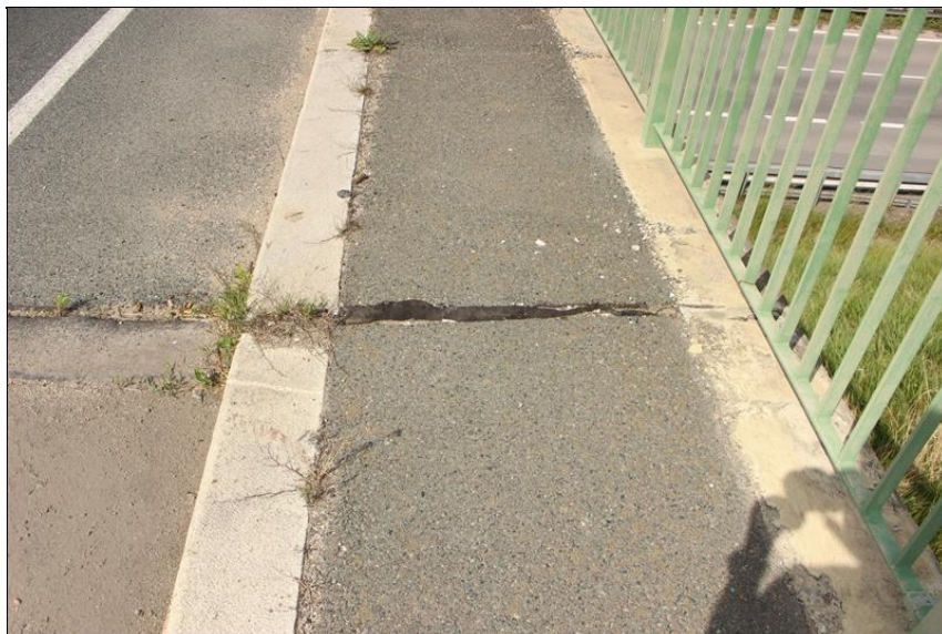
05-netěsnící mostní závěr nad opěrou 1.JPG
