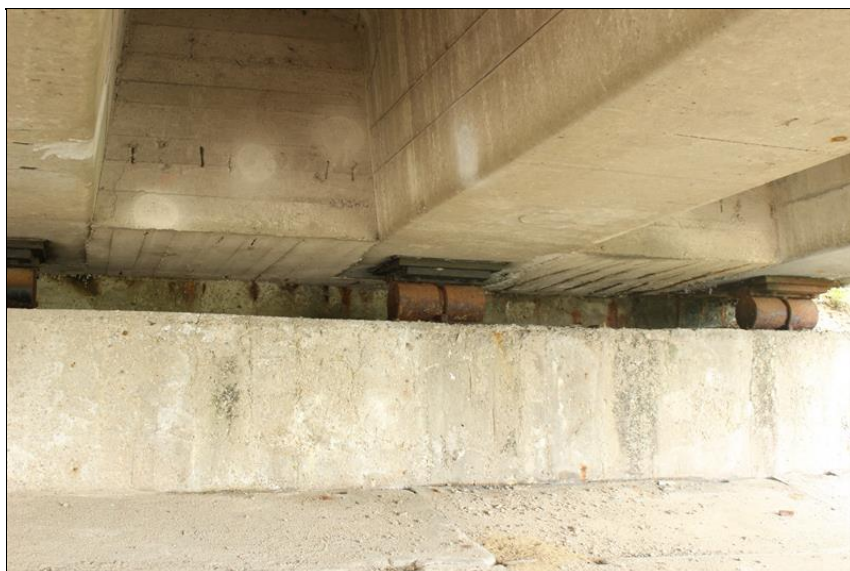
23-pohled na opěru 4 - zespoda koroze výztuže konc. příčnicku - koroze ložisek.JPG
