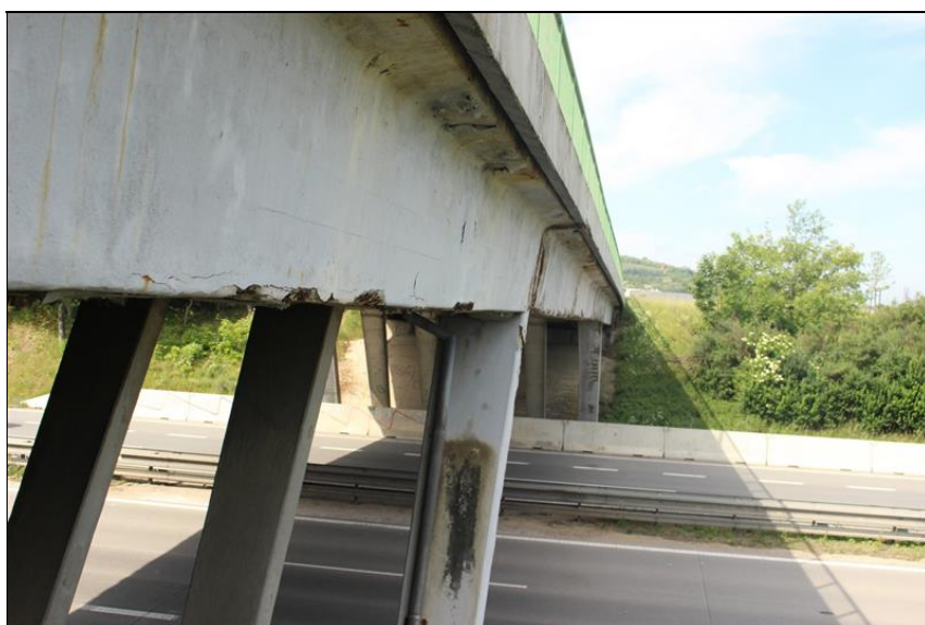
12-podélný pohled na krajní nosník vpravo - odpadané rohy nosníku.JPG
