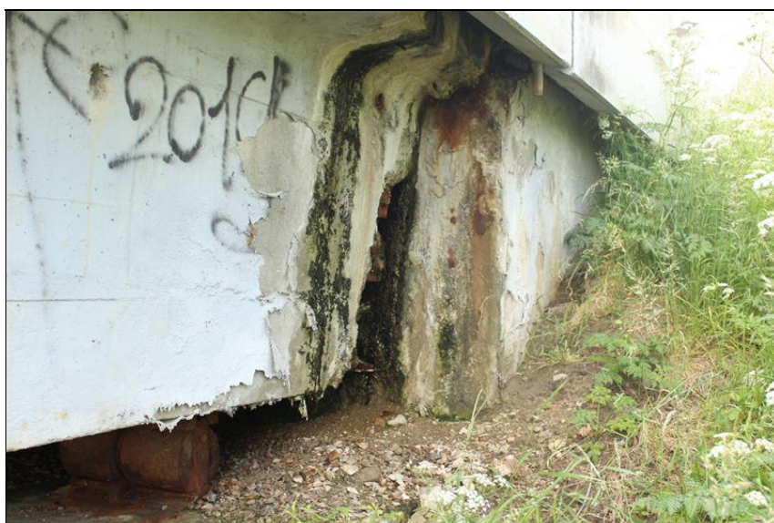
24-konec krajního nosníku u opěry 4 - obnažené kotvy předpínací výztuže.JPG
