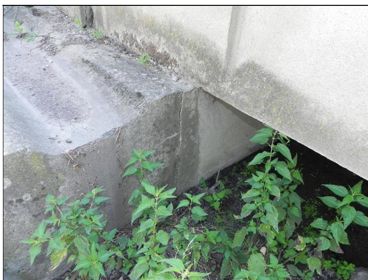
OP1 - podélná trhlina na odvodňovacím žlebu
