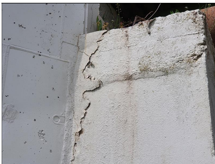
Trhlina v sanaci opěry
