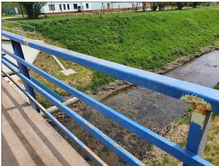
Koroze zábradlí
