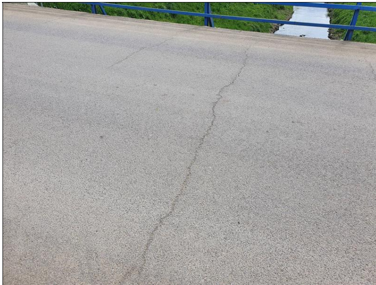
Trhliny ve vozovce na mostě
