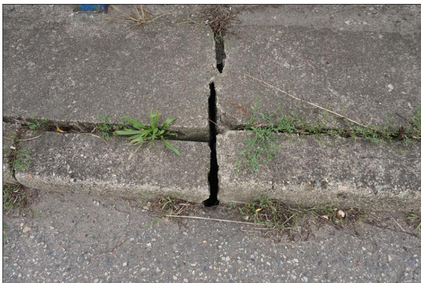
Detail dutiny na pravém chodníku u opěry OP1 vpravo.
