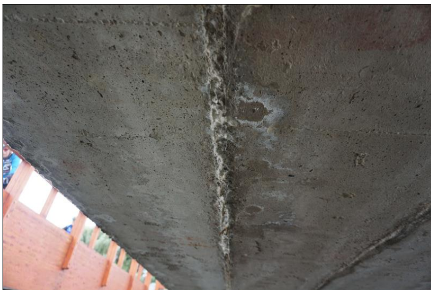
Detail spáry u krajního levého nosníku - zřetelné prosakování vlhkosti, výluhy, tvorba inkrustů.
