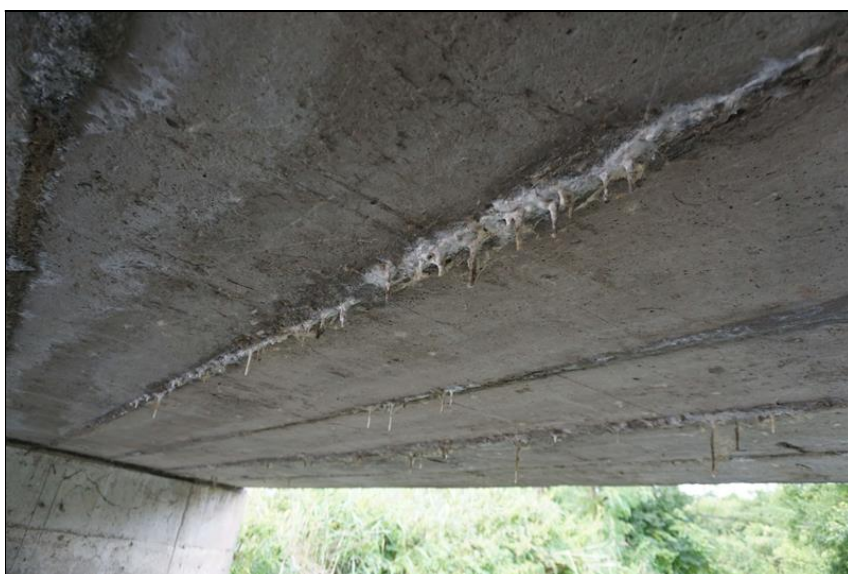
Detail spár u krajních pravých nosníků - zřetelné prosakování vlhkosti, výluhy, tvorba inkrustů.
