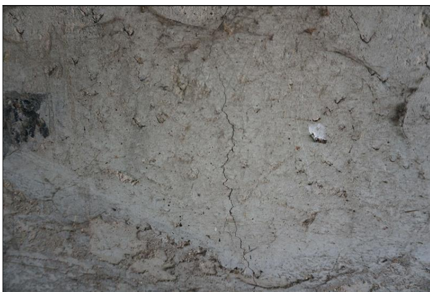
Detail opěry OP1 vpravo - lokální trhliny.
