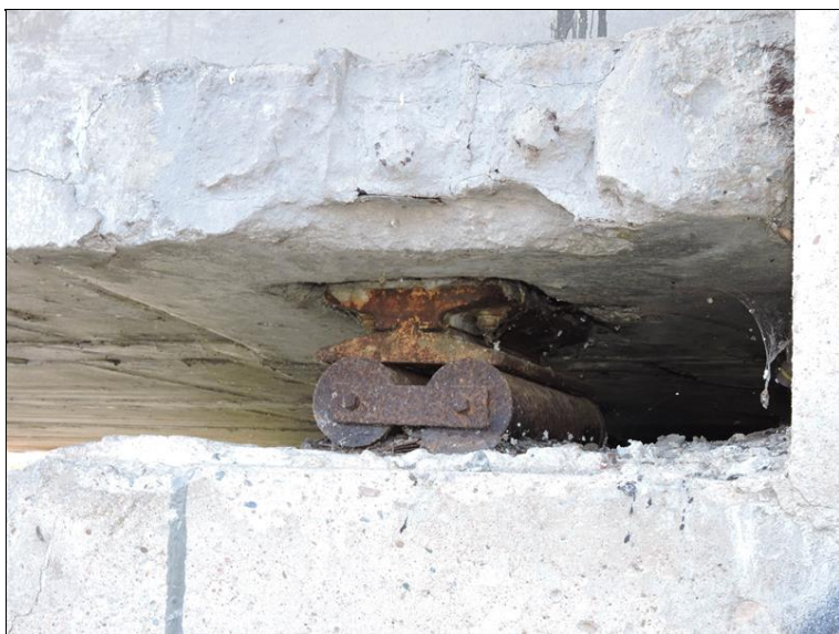
Ložisko - nad OP2 vpravo
