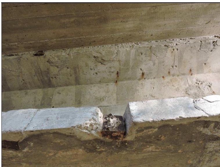
Kotva příčného předpětí v NK u OP2 vlevo
