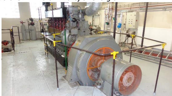
Obrázek 21 Záložní zdroj el. energie
