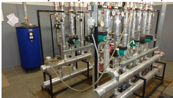
Obrázek 11 Objektové výměňkové stanice (OPS9) v C2
