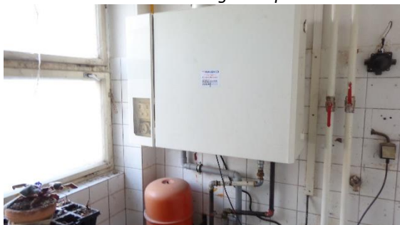
Obrázek 14 Kotel Buderus Logamax plus GB 112 – 43 v objektu E
