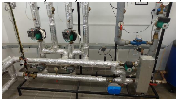
Obrázek 5 Objektové výměňkové stanice (OPS2) v A5
