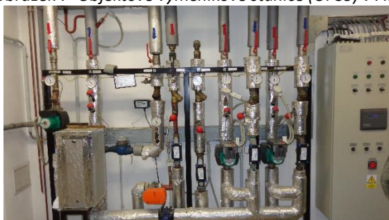
Obrázek 8 Objektové výměňkové stanice (OPS6) v A7
