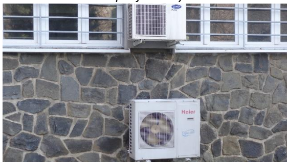
Obrázek 17 Chladicí split jednotky
