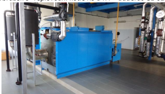
Obrázek 3 Teplovodní kotle K3 a K4 – Buderus GE 615
