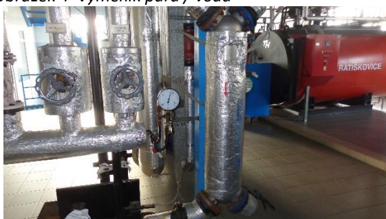
Obrázek 4 Výměník pára / voda
