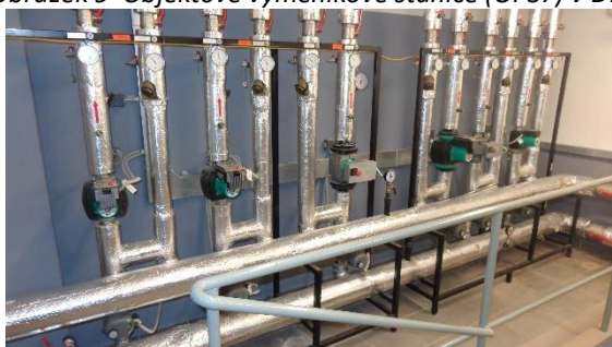
Obrázek 10 Objektové výměňkové stanice (OPS8 a OPS 8.1) v B2
