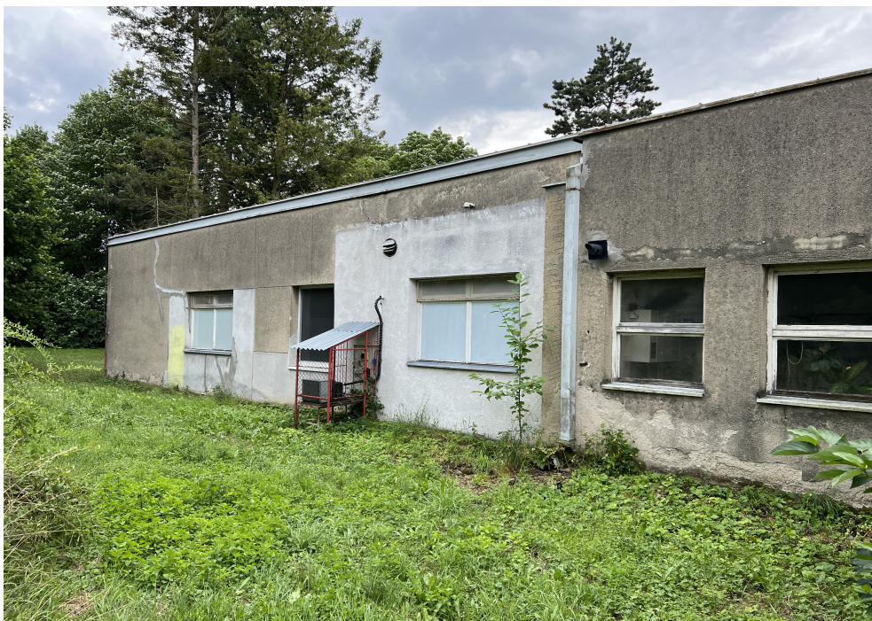
trhliny na fasádě objektu + nezaústěný svod
