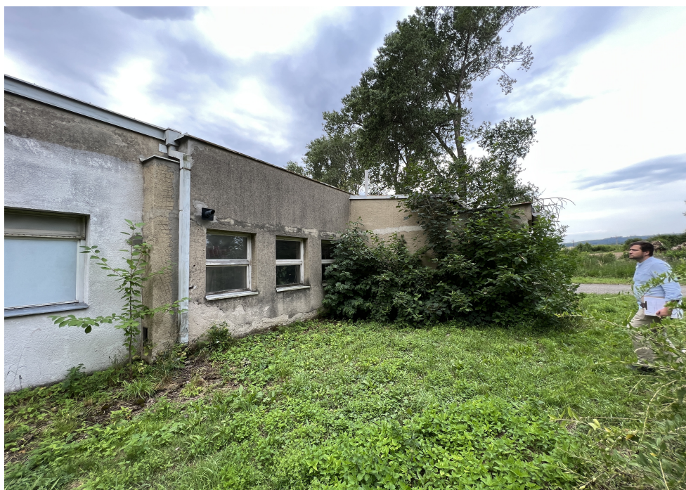
nezaústěný dešťový svod
