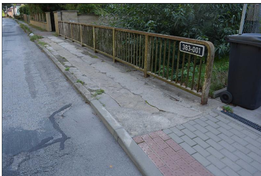
Levá mostní římsa se zábradlím a chodníkem od OP2.
