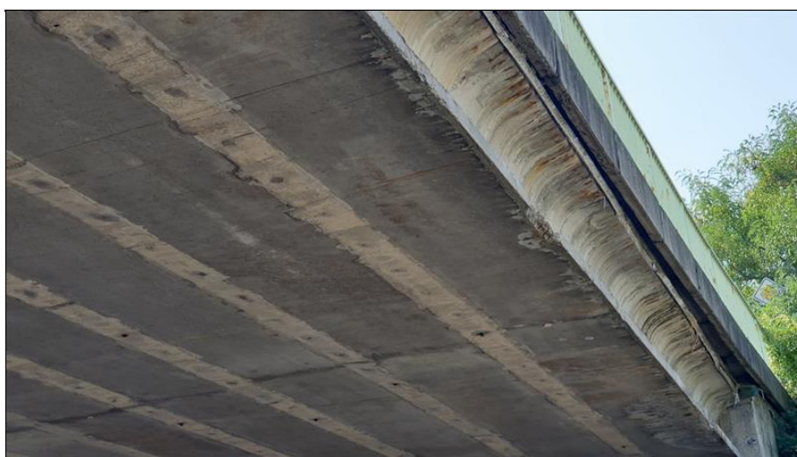
17-Zatékání na krajní nosník NK.jpg
