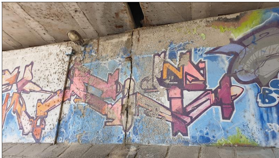
10-Zatékání mezi NK mostů na opěru OP2.jpg
