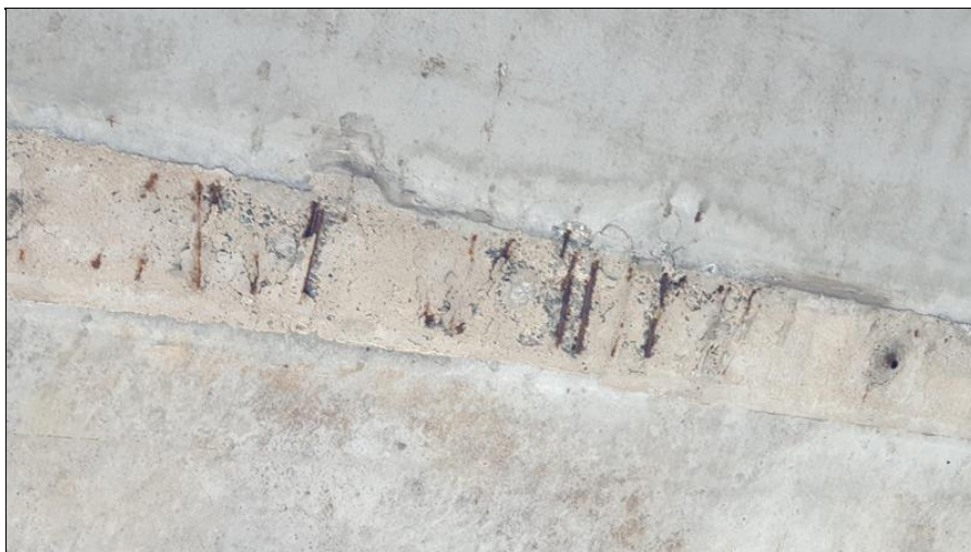
31-Koroze výztuže v dobetonávce mezi nosníky.jpg
