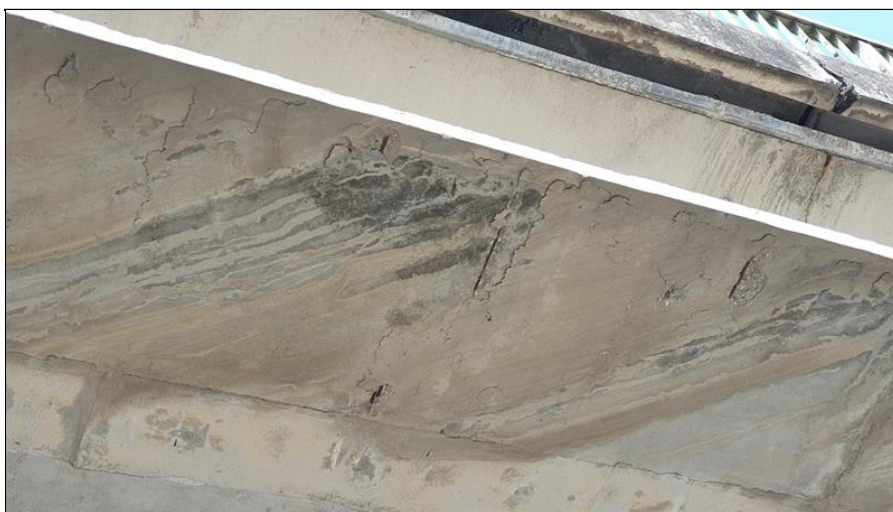
30-Podhled NK stopy po zatékání na krajní nosník.jpg
