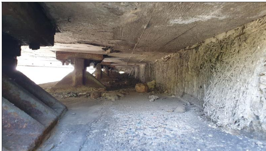
34-Pevná ložiska u OP2 nečistoty na UP.jpg
