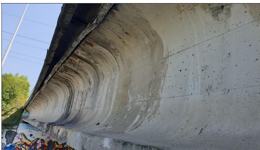
38-Stopy po zatékání na krajní nosník.jpg
