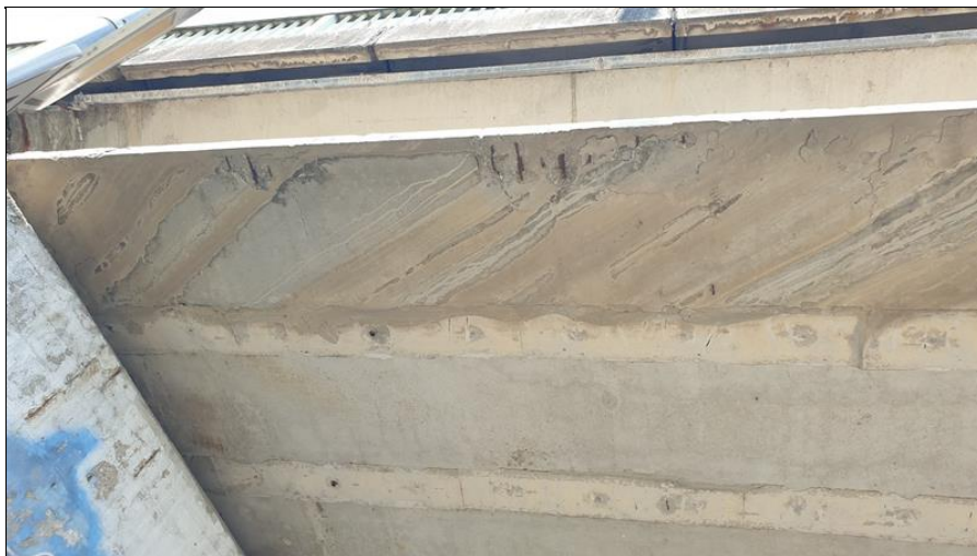
29-Podhled NK stopy po zatékání na krajní nosník.jpg
