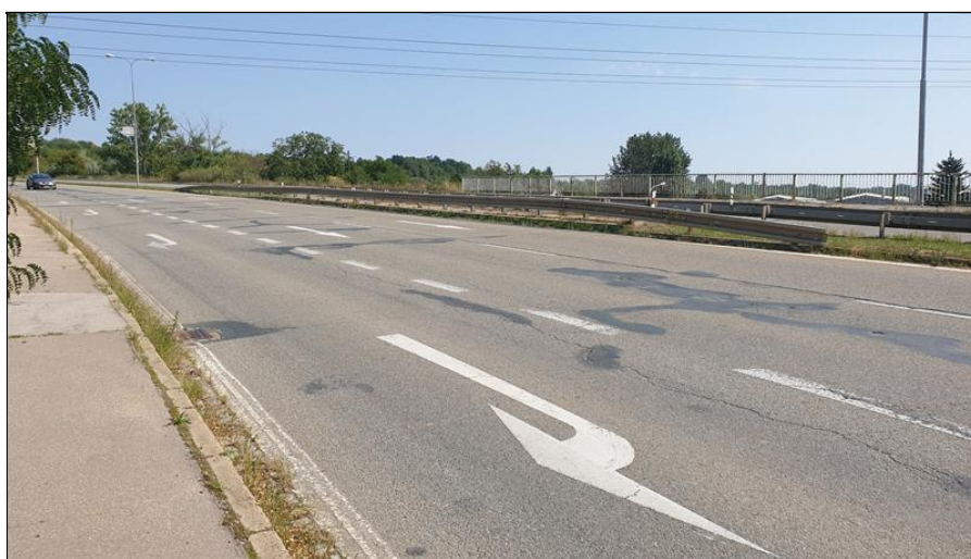
47-Trhliny opravy vozovky.jpg
