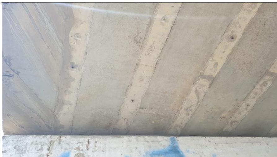
28-Podhled NK stopy po zatékání.jpg
