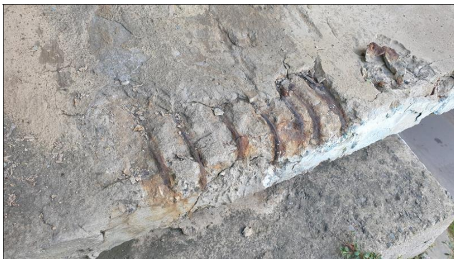
19-Zatékání na krajní nosník- koroze a rozpad betonu u OP1.jpg
