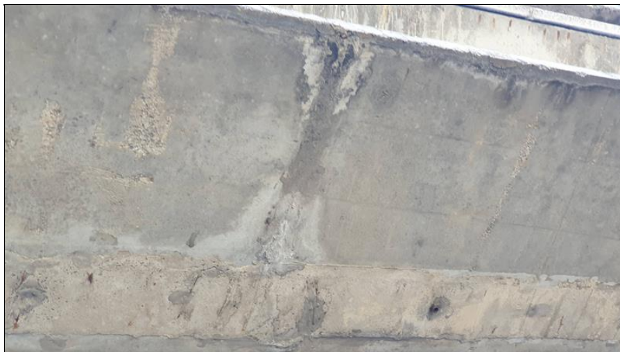
32-Zatékání na podhled NK.jpg
