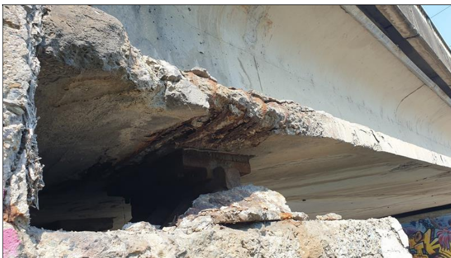
19-Zatékání rozpad nosníku u OP2.jpg
