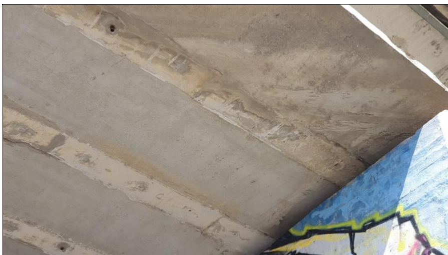
22-Podhled NK-stpoy po zatékání.jpg
