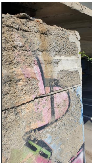
20-Degradace spodní stavby OP2 pod koncem nosníku.jpg
