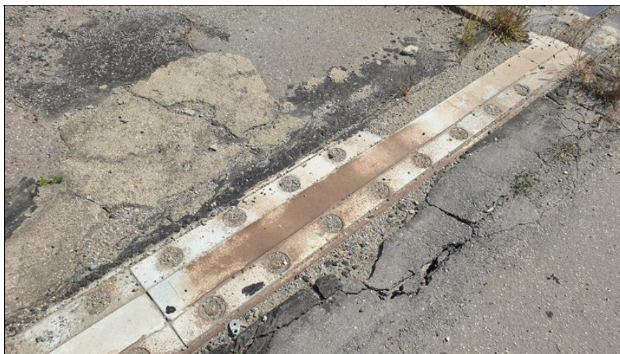
54-MZ v římse rozpad betonu a LA okolo profilů.jpg
