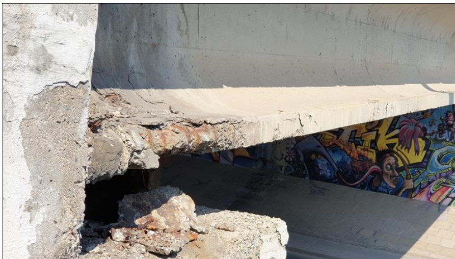
17-Zatékání rozpad nosníku u OP2.jpg
