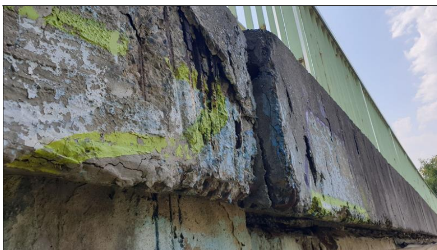
23-Rozpadlá řimsa u MZ OP1 koroze výztuže.jpg
