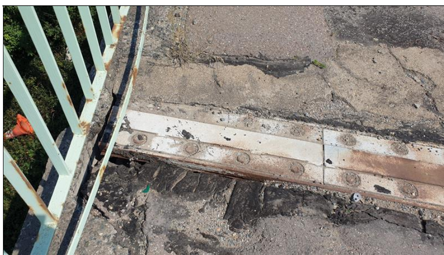
53-MZ v římse rozpad betonu okolo profilů.jpg
