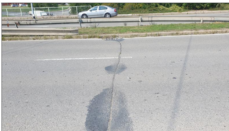
36-Trhlina ve vozovce před mostem.jpg
