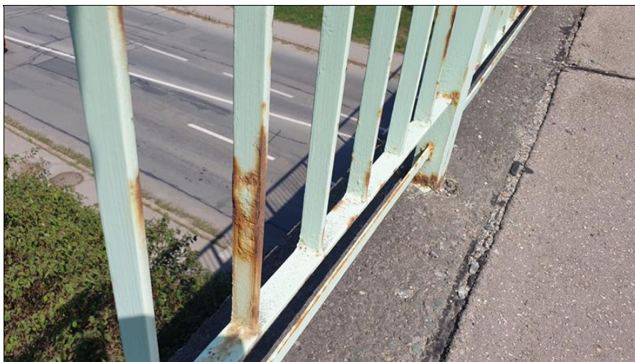
42-Koroze zábradlí.jpg
