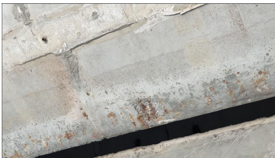
27-Podhled NK koroze výztuže nosníku u zrcadla.jpg
