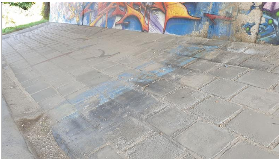
07-Splavení materiálu na odláždění mezi mosty.jpg
