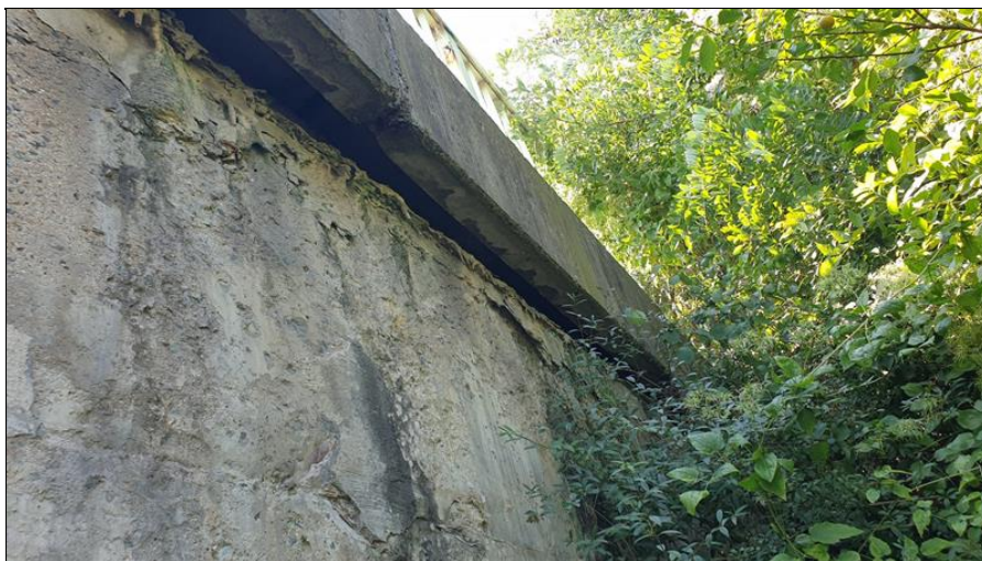
39-Zatékání na spodní stavbu rozpad povrchových vrstev.jpg
