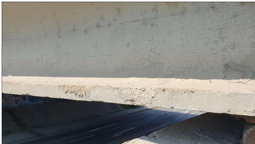
10-Drobné poruchy povrchu nosníku u OP1.jpg
