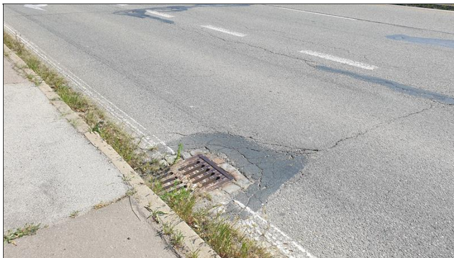
48-Rozpad vozovky u odvodňovače před mostem.jpg
