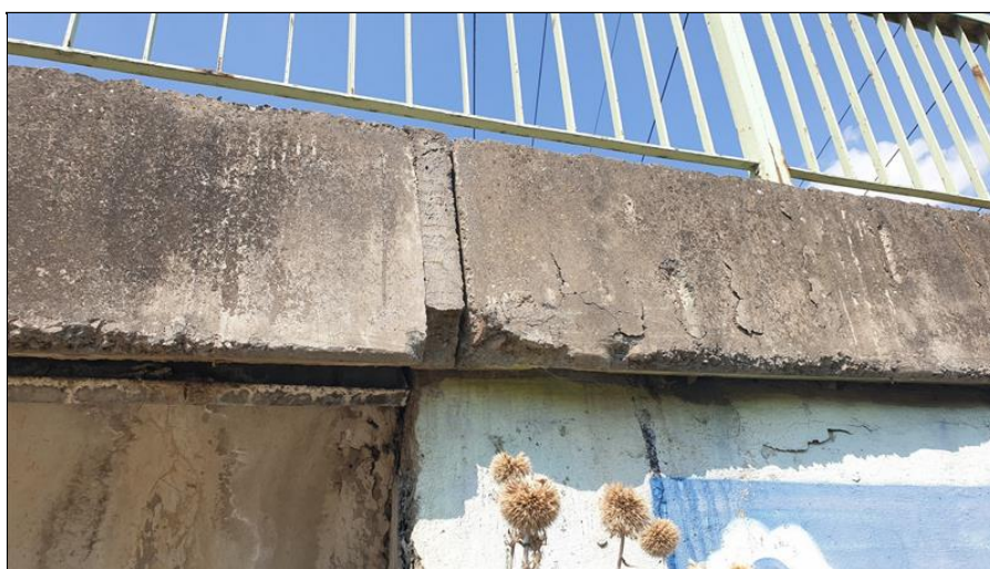
12-Protékající spára římsy.jpg
