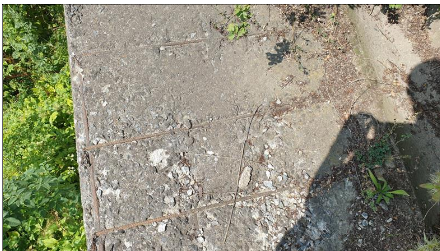
27-Pohled na vnější římsu koroze degradace betonu.jpg
