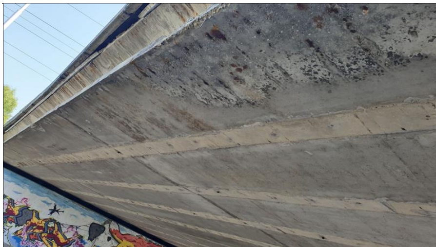
13-Stopy po zatékání na krajní nosník NK.jpg
