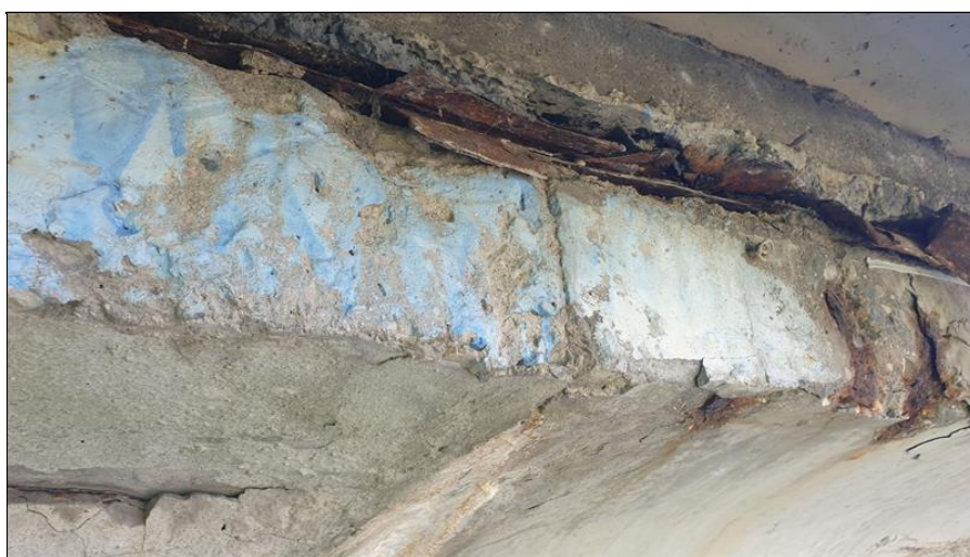
20-Rozpadlý okapový plech na nosníku.jpg
