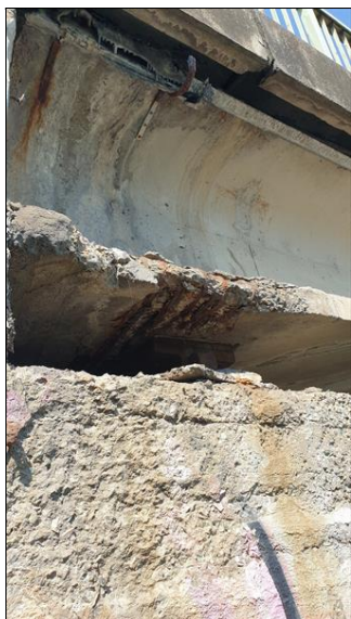
19-Zatékání rozpad nosníku u OP2.jpg
