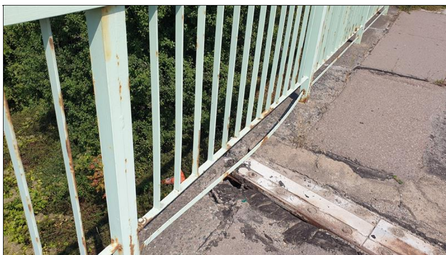
45-Vybočený profil zábradlí.jpg
