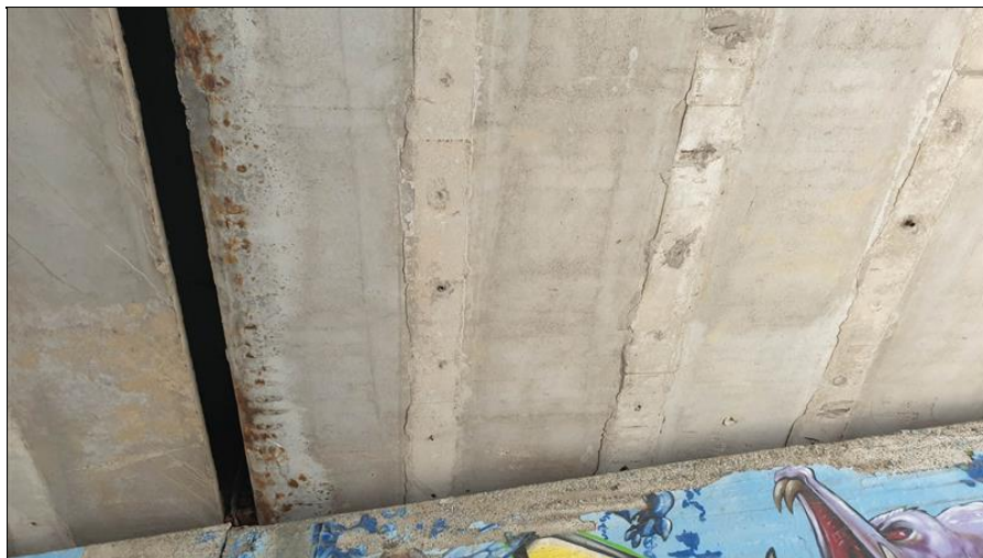
26-Podhled NK koroze výztuže nosníku u zrcadla.jpg
