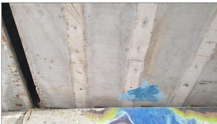
14-Stopy po lehkém zatékání mezi mosty.jpg
