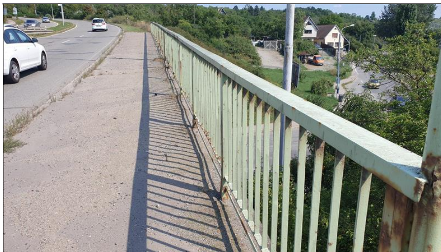
43-Koroze zábradlí.jpg
