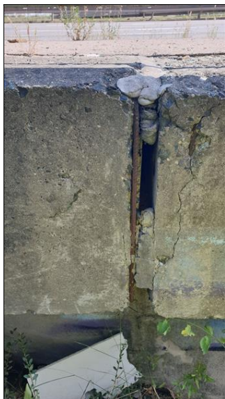
25-Zatěsnění spáry v římse.jpg
