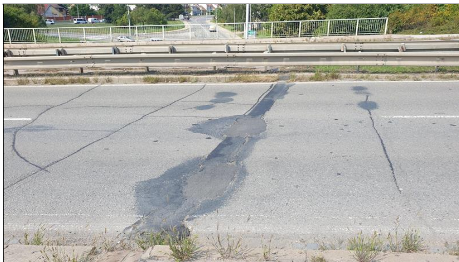
37-EMZ u OP1 jako náhrada původního GHH trhliny vytlačená hmota.jpg
