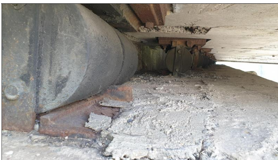
08-Posuvná ložiska na OP1.jpg
