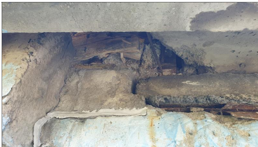
21-Dobetonávka NK u OP1 zbytky bednění zatékání.jpg
