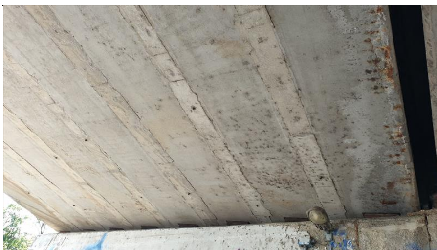
25-Podhled NK koroze výztuže nosníku u zrcadla.jpg
