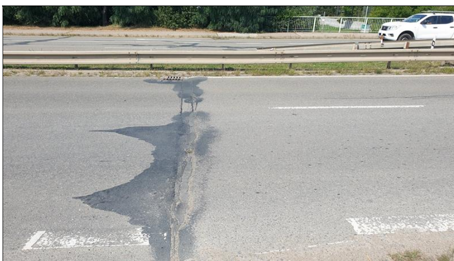
39-MZ u OP2 trhliny rozpad vozovky.jpg
