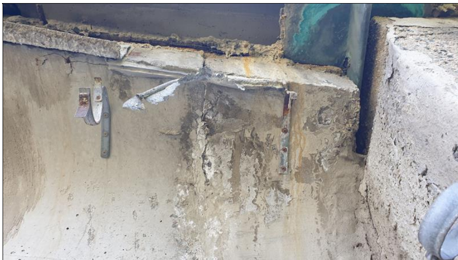
37-Zatékání na konec nosníku u OP2.jpg
