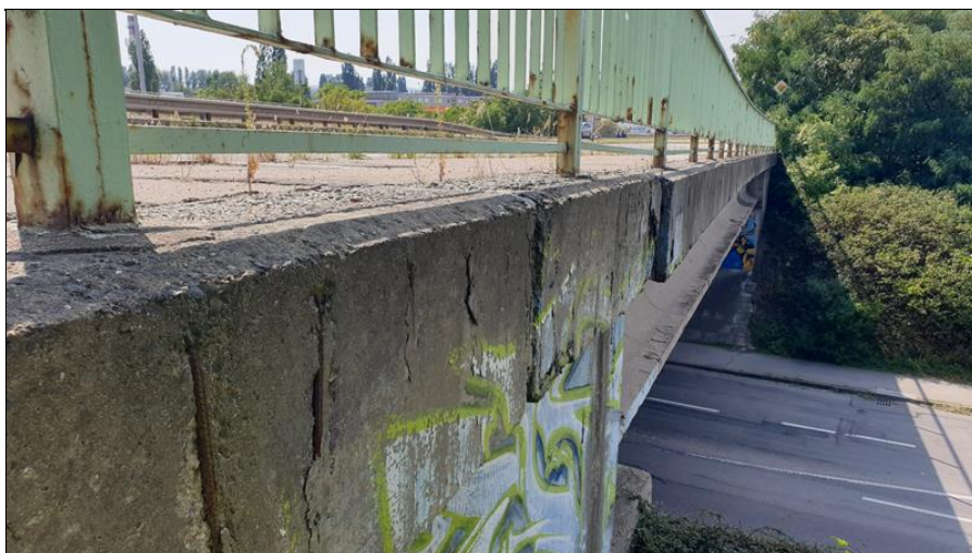
26-Pohled na vnější římsu koroze degradace betonu.jpg
