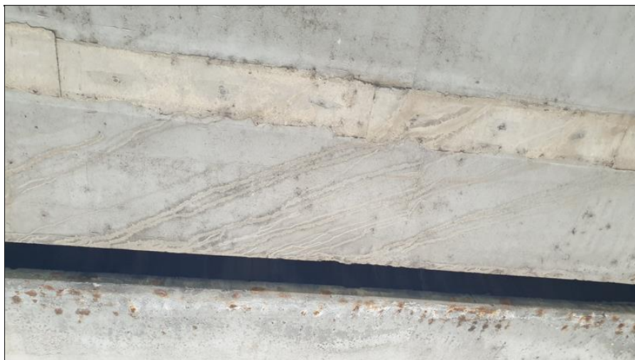
15-Stopy po zatékající vodě u zrcadla mezi mosty.jpg
