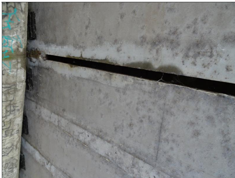
16.JPG Podhled středové spáry mezi krajními nosníky obou mostů v pohledu směrem k Op2. Na podhledu patrné podtékání stoků netěsnou střed. spárou. Nad Op2 krátké zmonolitnění střed. spáry s průsakem vlhkosti. Smáčený povrch opěry v místě střed. spáry.
