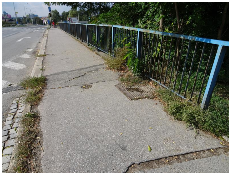
22.JPG Začátek chodníku na pravé straně mostu - trhliny, pokles na předpolích, u obrubníku vegetace.
