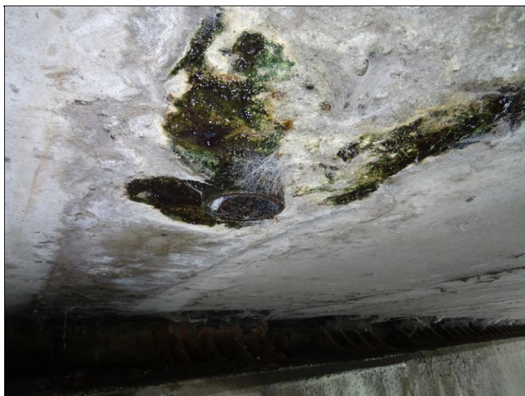
8.JPG Odvodňovací trubička dutiny v dobetonávce spáry mezi 1. a 2. nosníkem zprava před Op1. Oblast betonu kolem trubičky silně promočená s usazenými řasami.
