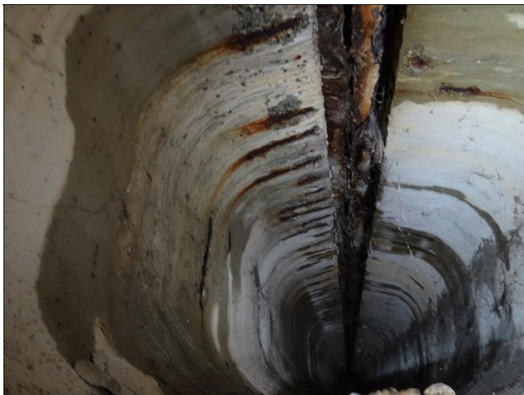
13.JPG Podhled středové spáry krajních nosníků obou mostů. Fasády krajních nosníků smáčené zátoky netěsnou středovou spárou.
