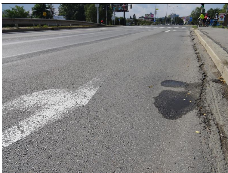
24.JPG Vozovka - vyjeté koleje, kryt vozovky podél zvýšené obruby vyjetou stopou vytlačený a olámaný.
