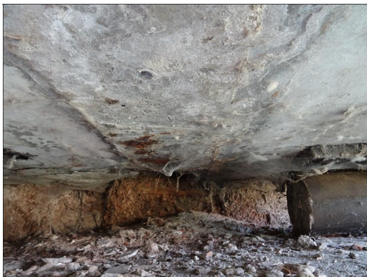
20.JPG Horní plocha ÚP Op2 mezi 1. a 2. nosníkem zprava. ÚP zanesený spadem degradovaného betonu, v dobetonávce mezi nosníky a na ZZ výluhy korozní zplodin výztuže,
