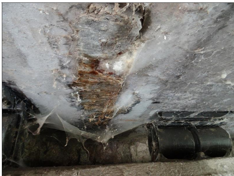
17.JPG Podhled krátkého (nad Op2) zmonolitnění středové spáry mezi krajními nosníky obou mostů. Na podhledu dobetonávky výrazné stopy průsaků s výkvětem korozních zplodin a zabetonovanými nečistotami. ÚP Op2 je smáčen.
