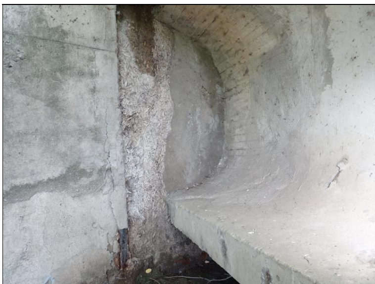
6.JPG Styl závěrné zídky (ZZ) s křídlem - zatékání, degradace betonu, v patě obnažená silně zkorodovaná výztuž.
