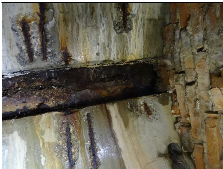
12.JPG Podhled středové spáry mezi krajními nosníky obou mostů v místě nad Op1 v pohledu k její ZZ. Zátoky středovou spárou. Koroze krycího plechu spáry a obnažených třmínek v horní přírubě nosníků.
