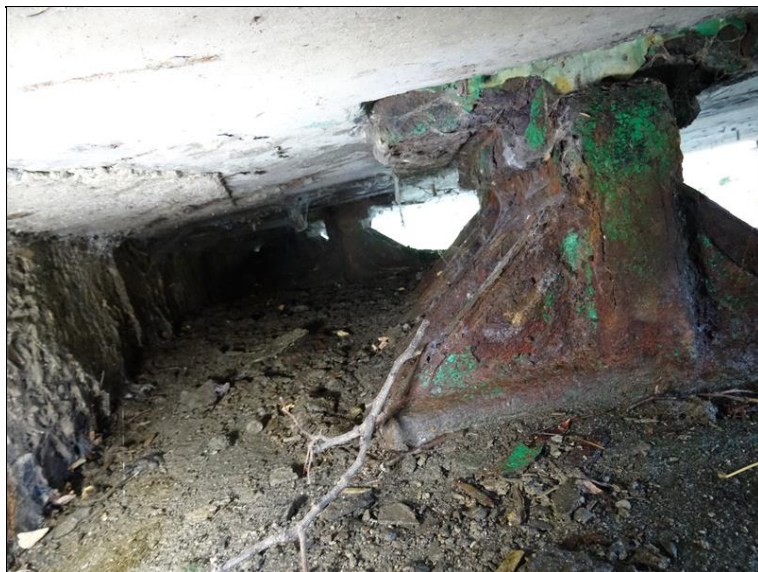
10.JPG Úložný práh Op1 v místě 1. ložiska zprava v pohledu k levé straně mostu. Koroze ložiska, úl. práh je vlhký a zanesený odpadem degr. materiálu.
