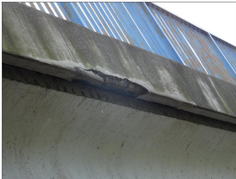
28.JPG Fasáda pravé římsy cca v 1/3 rozpětí mostu. Lokální odpad sanovaného betonu.
