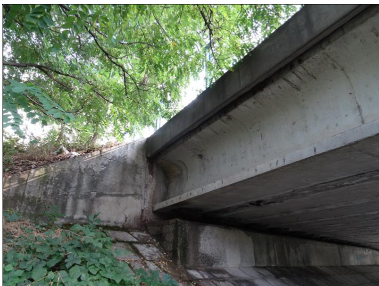
5.JPG Pravá strana Op1. Masivní zátok shora, degradace betonu kraje Op1 i křídla.
