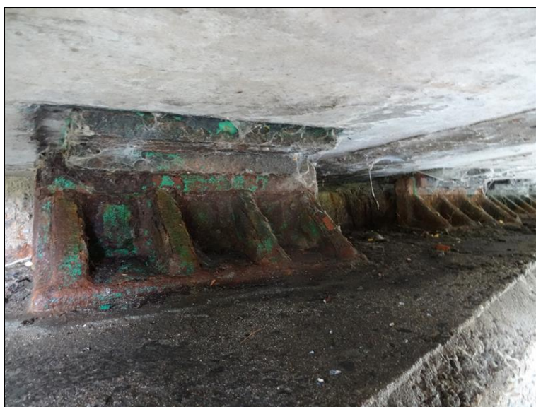
9.JPG Čelní pohled na frontu pevných ložisek na Op1 v pohledu zprava.
