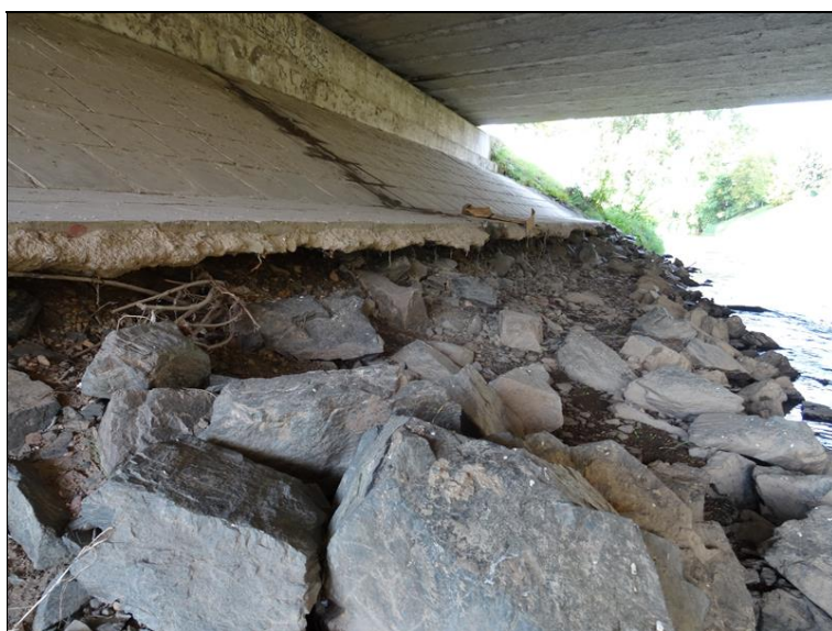
30.JPG Podemletý betonový práh zpevněného svahu dlažbou a odplavený kamenný zához.
