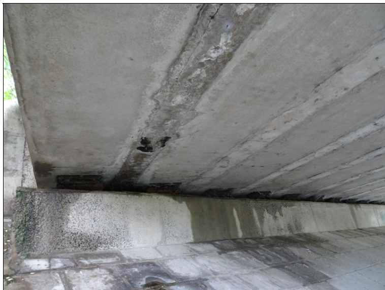
7.JPG Čelní strana Op1 zprava v bližším pohledu. Výrazná degradace masivně smáčeného betonu kraje opěry. Na podhledu NK patrné průsaky zátoků dobetonávkou mezi krajními nosníky. Degradace povrchu dlažby pod vyústěním odvodňovače.
