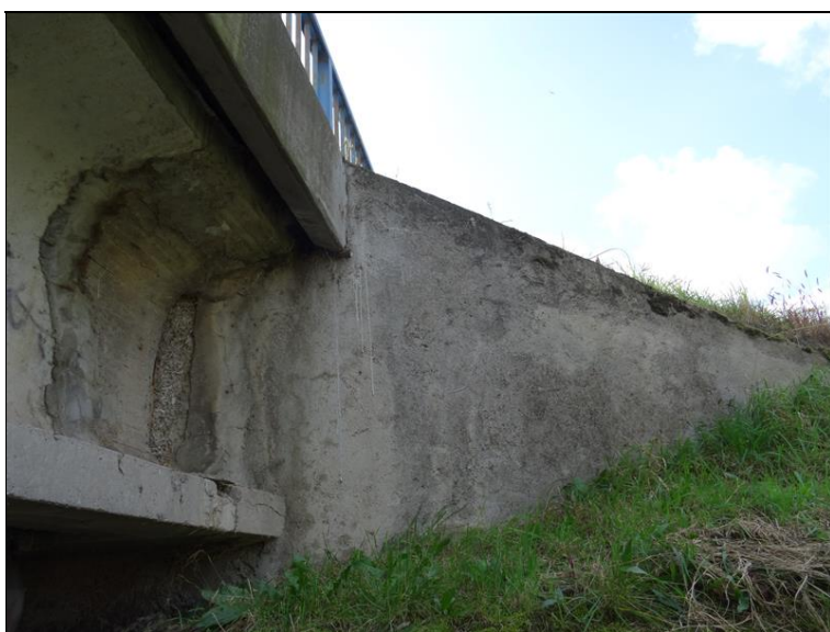
15.JPG Pravé křídlo Op2 - povrchová degradace betonu, horní plocha s uchycenými mechy. Na snímku vlevo patrný průsak vlhkosti v místě dobetonávky konce krajního nosníku.
