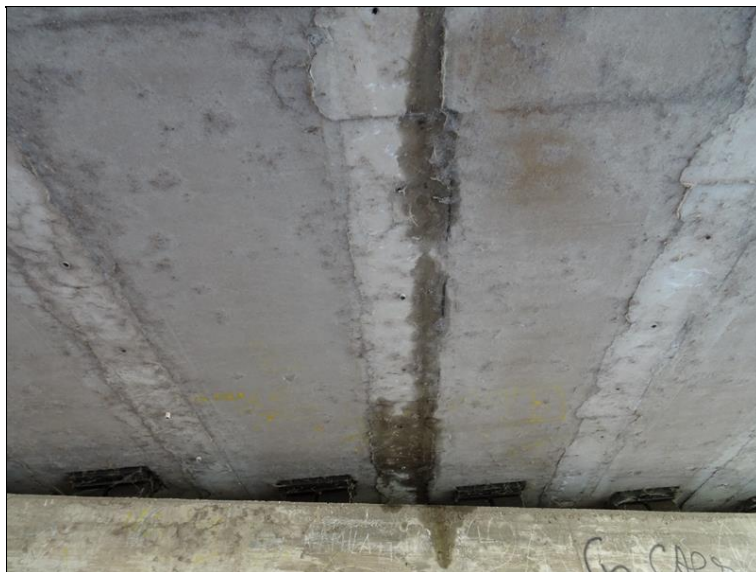
19.JPG Podhled nosné konstrukce (NK) ve směru k Op2 v místě zatékání mezi 5. a 6. nosníkem.
