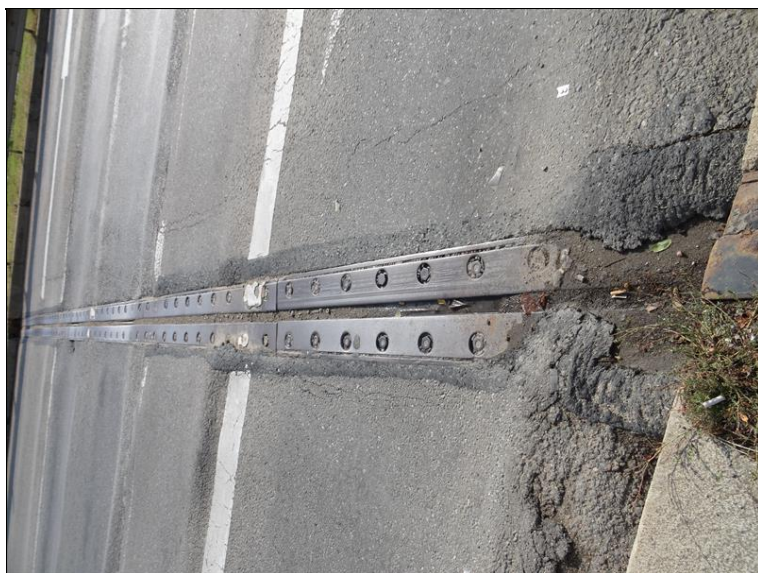
26.JPG MZ nad Op2 - příčná deformace vozovky, vysprávký, menší výtuk ve středním pruhu, bez zálivek podélných.
