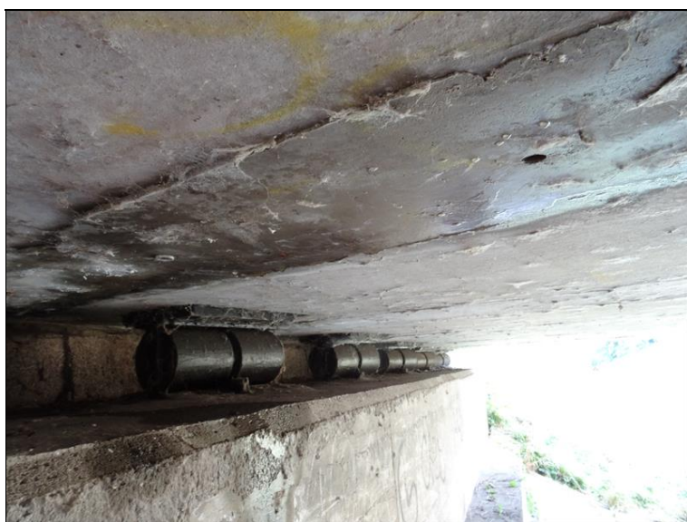
18.JPG Válcová ocelová ložiska na Op2 - pohled směrem k pravé straně mostu, silné průsaky dobetonávkou mezi 5. a 6. nosníkem zprava, zatékání na úložný práh.
