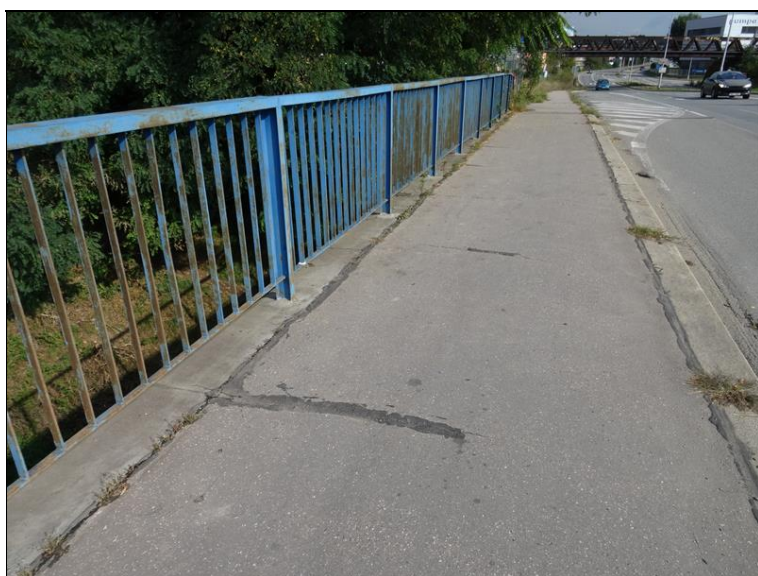
27.JPG Pravý chodník - koroze zábradlí, v místech spár mezi lícními prefabrikáty příčné trhliny s nefunkční zálivkou, ve spárách místy uchycená vegetace.
