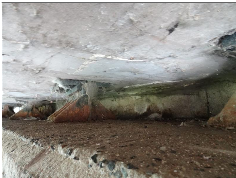
11.JPG Koroze stolic pevných ložisek na Op1, zanesený úložný práh a stopy zatékání.
