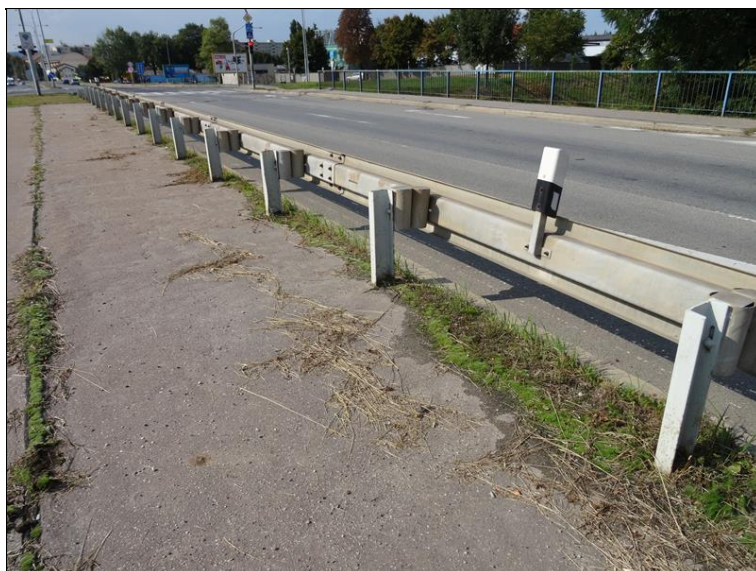
29.JPG Levá (vnitřní) římsa - bujně uchycená vegetace ve spáře podél zvýšených obrub. Uchycená vegetace též ve středové spáře mezi mosty. .
