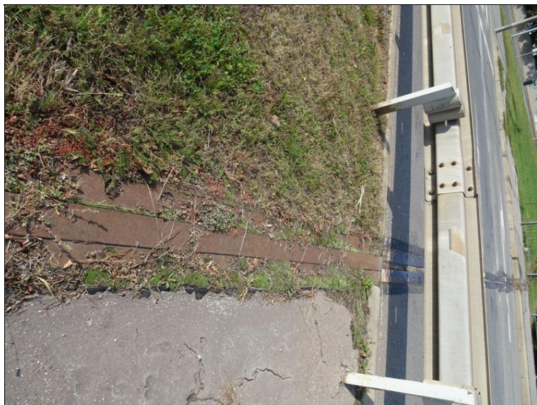
25.JPG MZ nad Op2 v místě středového pásu (lod vozovky levá strana) - povrchová koroze, uchycená vegetace.
