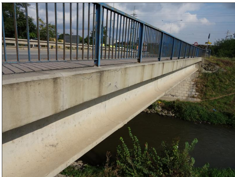
29.JPG Fasáda mostu před Op2. Zboulení a trhliny v sanaci povrchu lícních prefabrikátů s bodovými průniky korozních zplodin zasažené výztuže.
