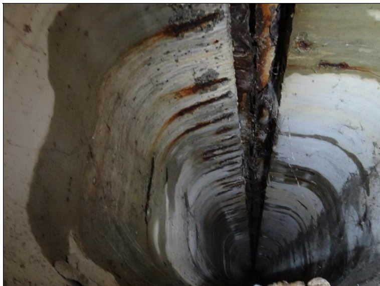
12.JPG Podhled středové spáry krajních nosníků obou mostů. Fasády krajních nosníků smáčené zátoky netěsnou středovou spárkou, silná koroze lokálně obnažené výztuže. .
