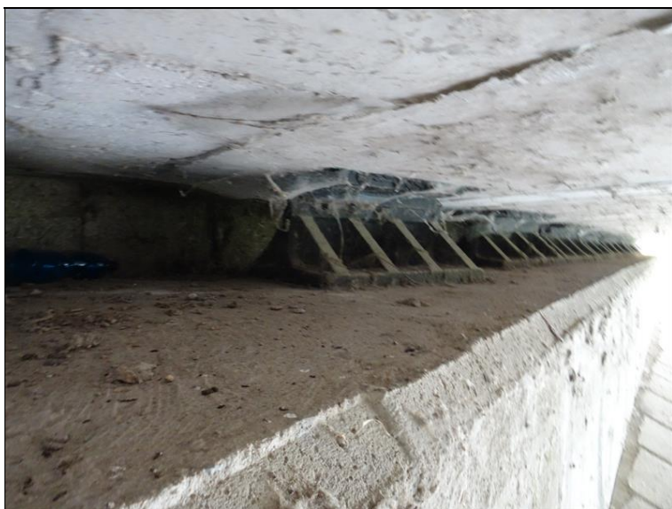
9.JPG Pohled na 6. ložisko - za ložiskem patrná průsak závěrnou zídkou.
