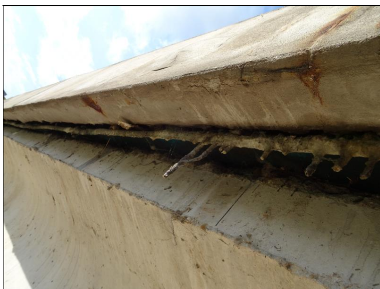
27.JPG Podhled římsového prefabrikátu nad Op1. Zboulená sanace čela prefabrikátu, zvýšený odkap izolace v místě levostranného konce NK.
