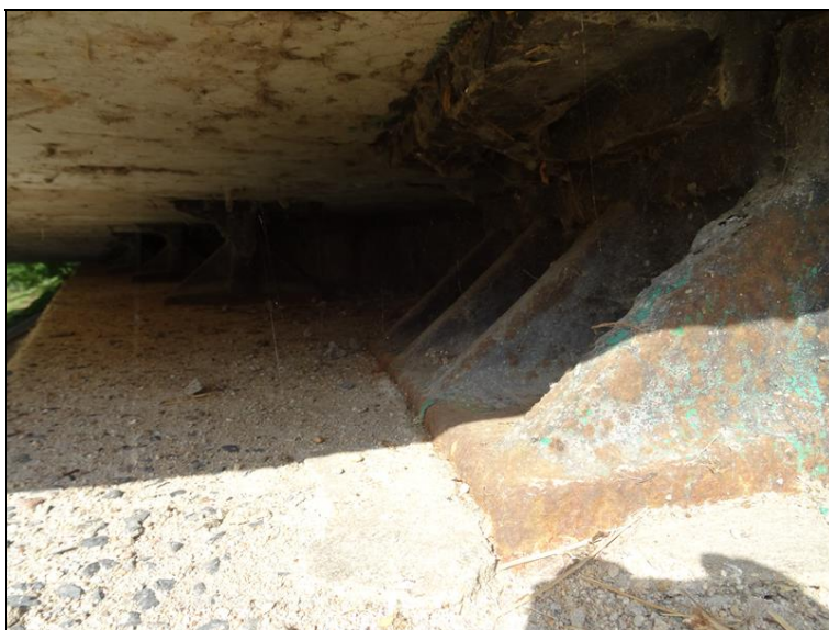
6.JPG Krajní pevné ložisko na Op1 - koroze ložiska, degradace betonu úložného prahu.
