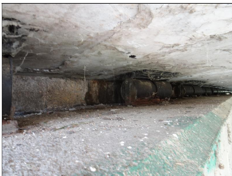
15.JPG ÚP Op2 v místě mezi 3. a 4. válcovým ložiskem. Za 4. ložiskem za závěrné zídce stopy zátoků.
