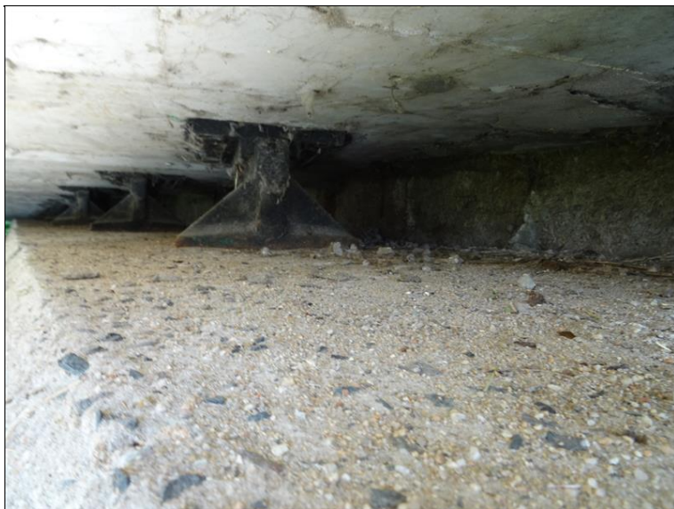
7.JPG Degradace povrchu úložného prahu.
