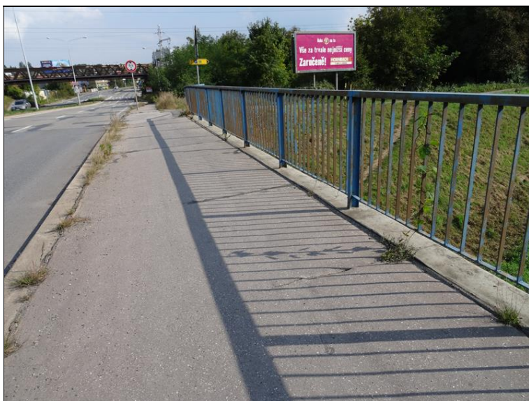
24.JPG Levý chodník - povrch chodníku z LA mírně zvlněný, příčné trhliny, koroze zábradlí, vegetace u obrubníku, místy u římsy.
