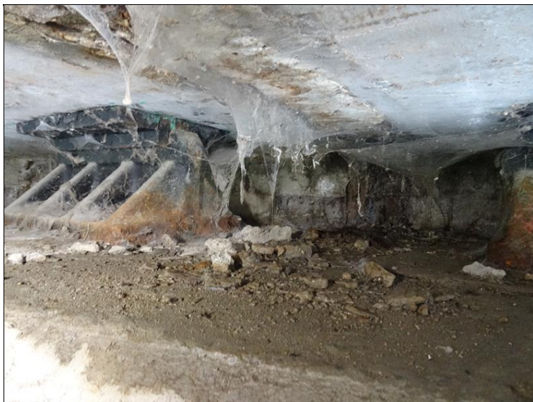
10.JPG Pravé krajní ložisko - koroze spodní částí stolice ložiska, patrný zátok na úlož. práh.
