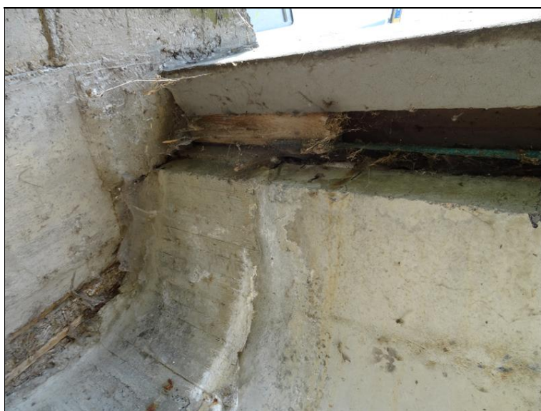
30.JPG Podhled levostranné římsy v konci NK nad Op2. Ponechané prkno, okapový plech izolace nedotažen ke konci mostovky, průsaky dobetonávkou krajového nosníku.
