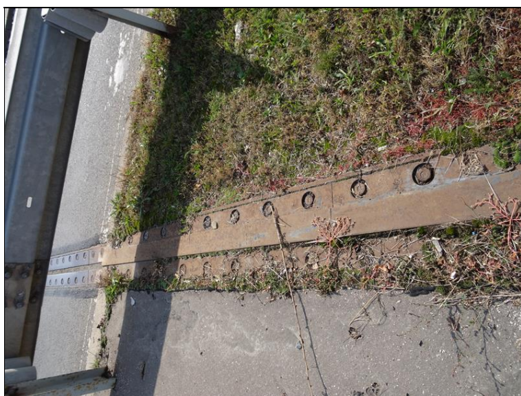
21.JPG MZ nad Op2 - korodující a znečištěná část s vegetací ve středním pásu.
