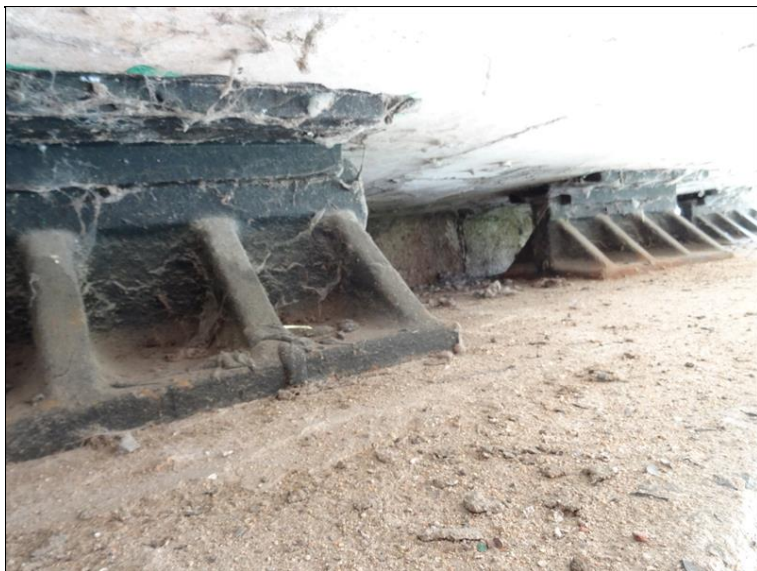
8.JPG Fronta prvních třech pevných ložisek na Op1 z čelního pohledu. Za 2. ložiskem patrný průsak závěrnou zídkou.
