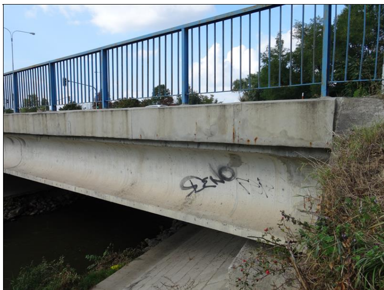
26.JPG Fasáda mostu v místě Op1. Trhliny v sanaci povrchu lícních prefabrikátů s bodovými průniky korozních zplodin zasažené výztuže.
