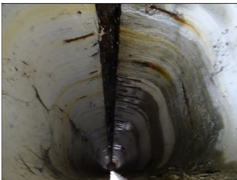
18.JPG Podhled středové spáry krajních nosníků obou mostů ve směru k Op1. Fasády krajních nosníků smáčené zátoky netěsnou středovou spárou, silná koroze lokálně obnažené výztuže.
