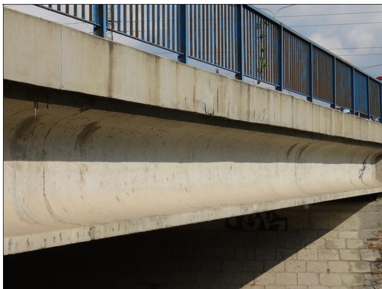
28.JPG Fasáda mostu v pohledu od středu rozpětí NK k Op1. Zboulení a trhliny v sanaci povrchu lícních prefabrikátů s bodovými průniky korozních zplodin zasažené výztuže.
