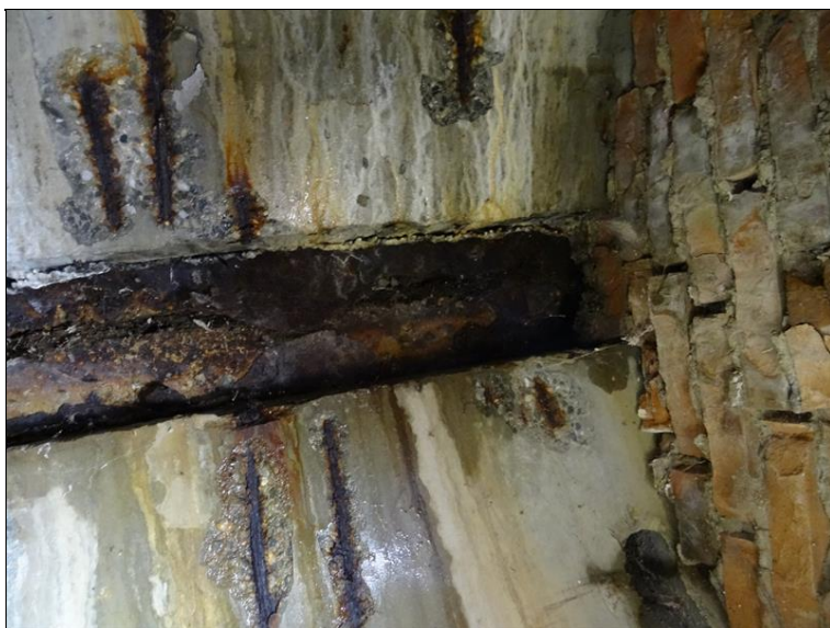
11.JPG Podhled středové spáry mezi krajními nosníky obou mostů v místě nad Op1 v pohledu k její ZZ. Zátoky středovou spárou. Koroze krycího plechu spáry a obnažených třmínků v horní přírubě nosníků.
