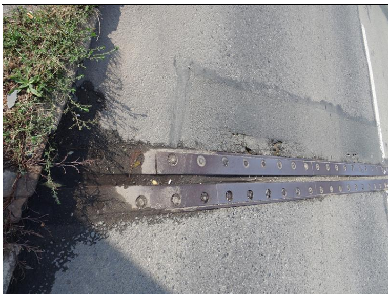
23.JPG MZ nad Op2 na levé straně mostu. Počínající výtluk v krytu vozovky, u chodníkové obruby dochází ke splavování a usazování nečistot.
