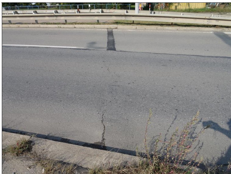
20.JPG EMZ nad Op1. EMZ v pravém jízdním pruhu je přebalen, v živici jsou trhliny.
