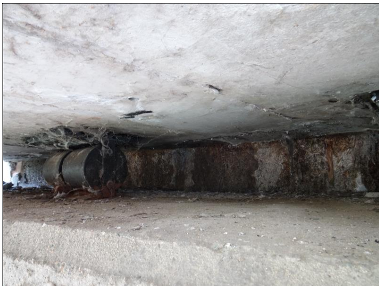
16.JPG ÚP Op2 v místě mezi 2. a 3. ložiskem. Na závěr. zídce patrné zátoky shora.
