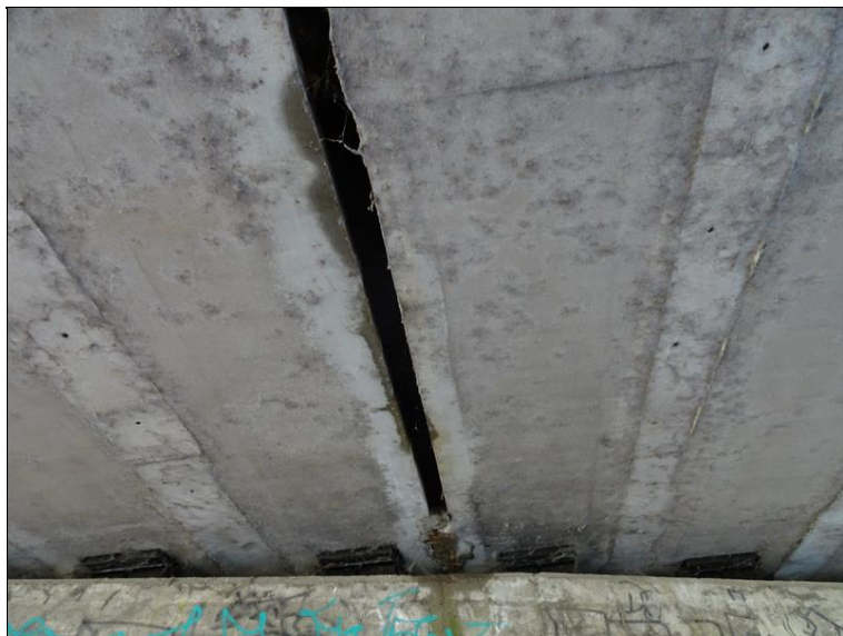
19.JPG Podhled nosné konstrukce (NK) ve směru k Op2 - průsaky ve spáře mezi mosty.
