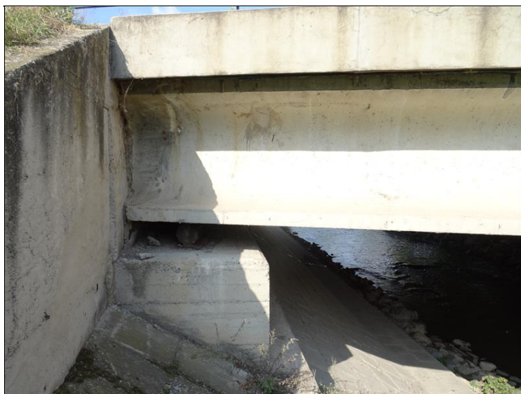
14.JPG Op2 zleva - průsaky na konci NK, povrchová degradace betonu boku opěry a opršené horní části levého křídla.
