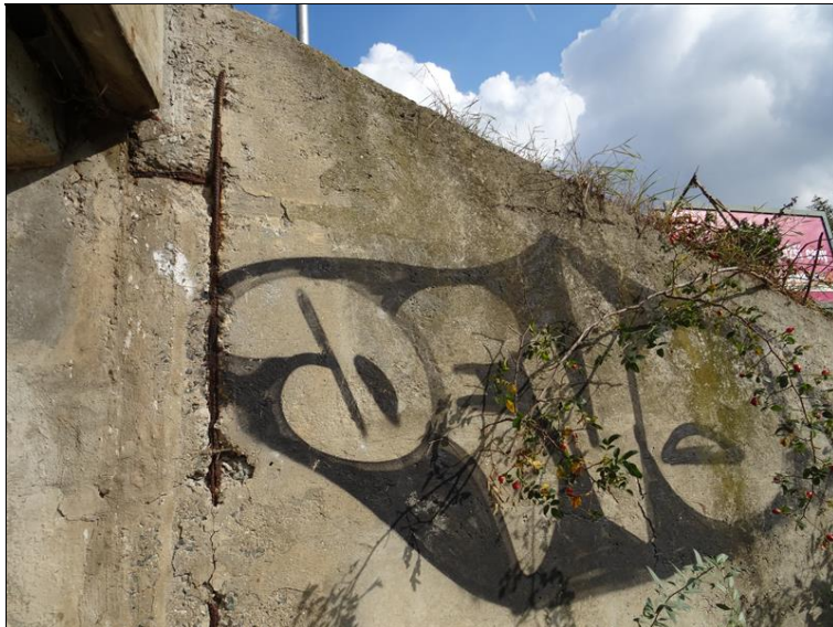
5.JPG Levé křídlo Op1 - degradace betonu, obnažená korodující výztuž, uchycená vegetace na horní povrchu.
