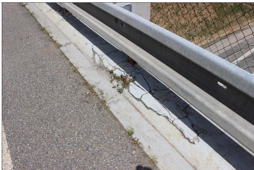
08-pravá strana - řimsa - degradace povrchu.JPG
