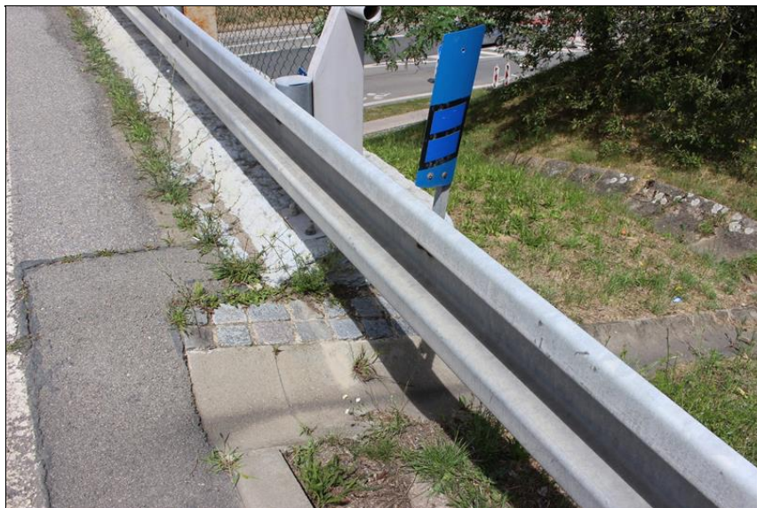
04-pravá strana mostu - odvod. žlab - svodidlo.JPG
