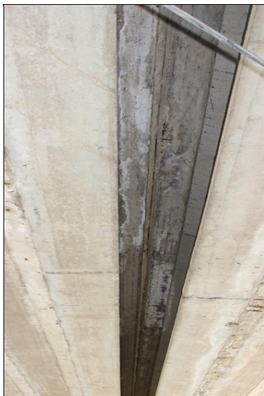
25-spára mezi mosty - vápenné výluhy.JPG
