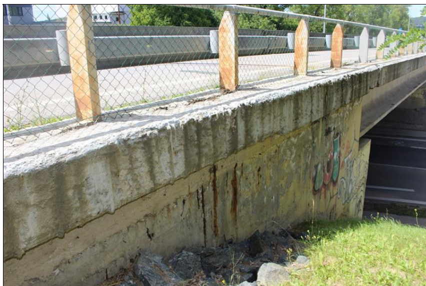
17-degradace povrchu římsy - pravé křídlo opěry 1.JPG
