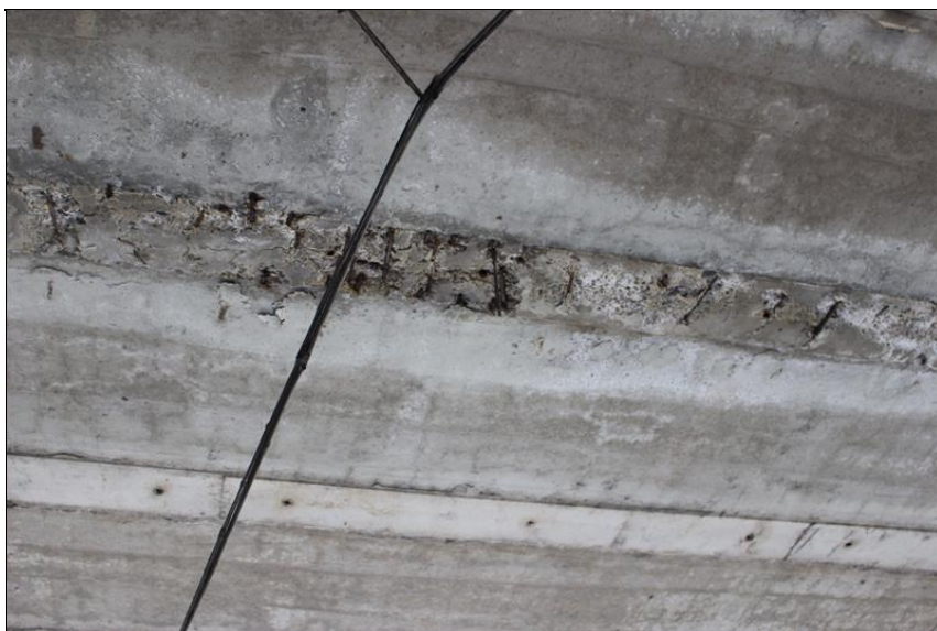
26-podhled NK - koroze obnažené výztuže v dobetonávce mezi nosníky.JPG
