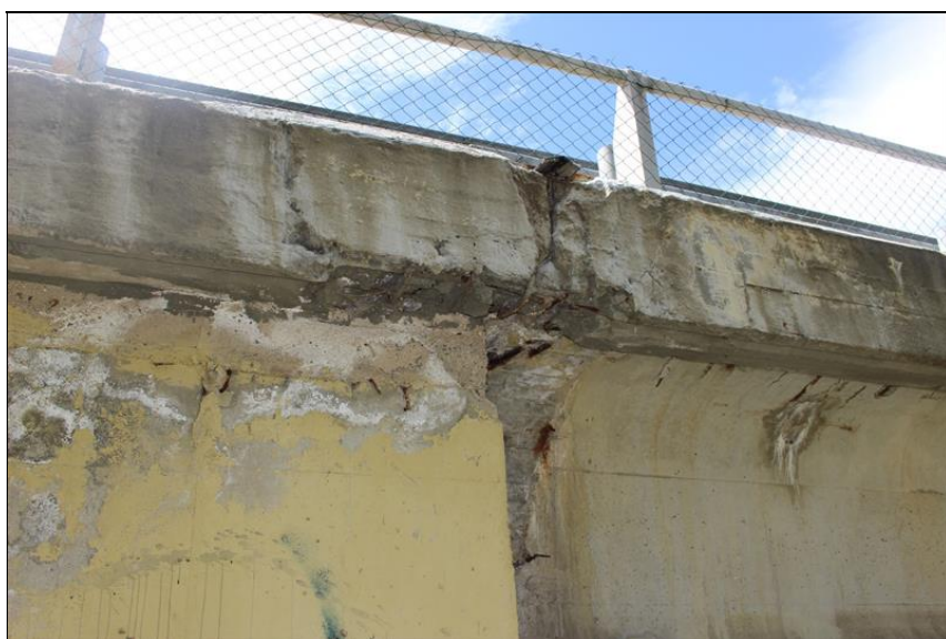
18-silně narušená římsa v místě MZ - opěra 1.JPG
