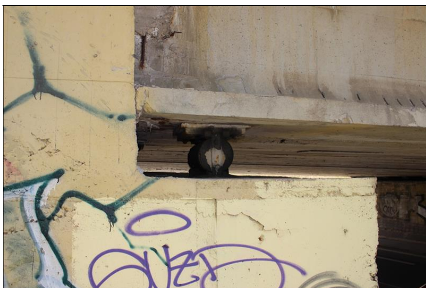
21-koroze krajního ložiska na opěře 1.JPG
