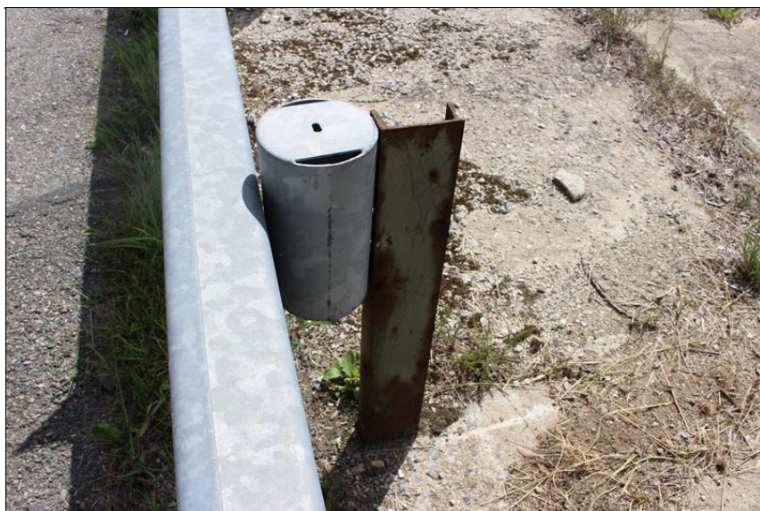
14-levá strana - koroze sloupku svodidla.JPG
