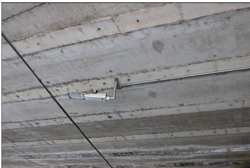
24-podhled NK - osazeno svítidlo VO.JPG
