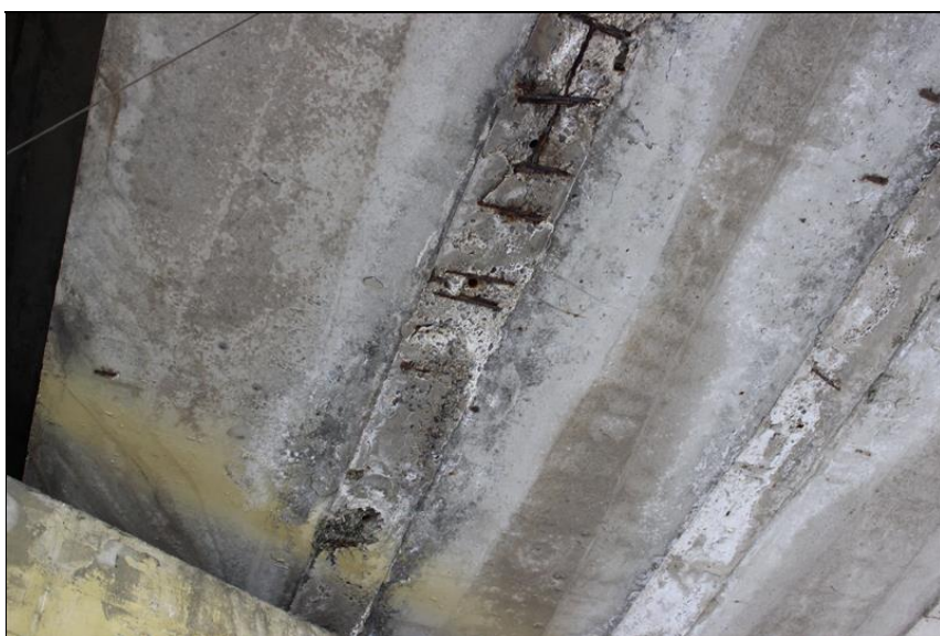
27-podhled NK - koroze obnažené výztuže v dobetonávce mezi nosníky.JPG
