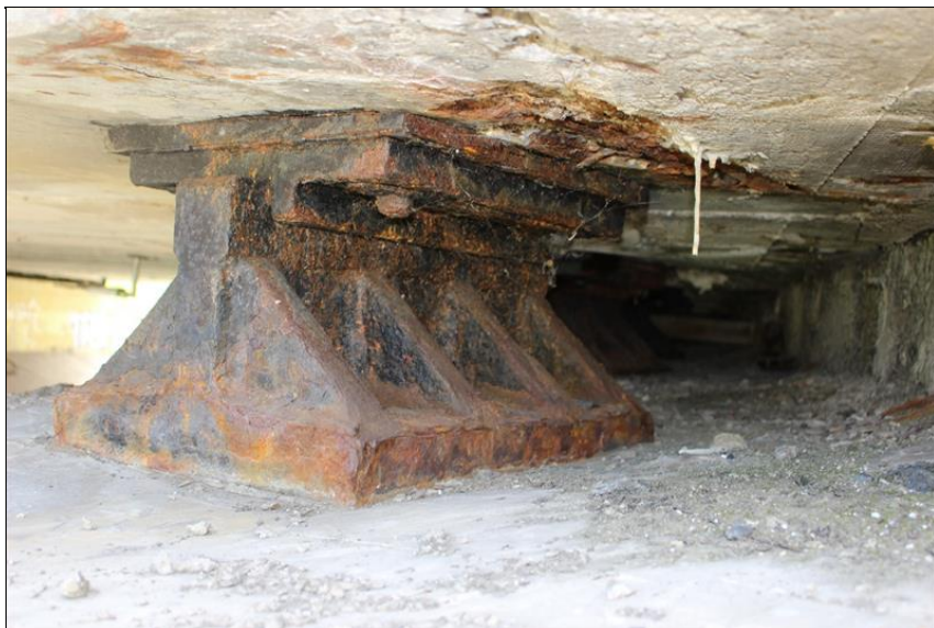
22-zkorodované krajní ložisko na opěře 2.JPG
