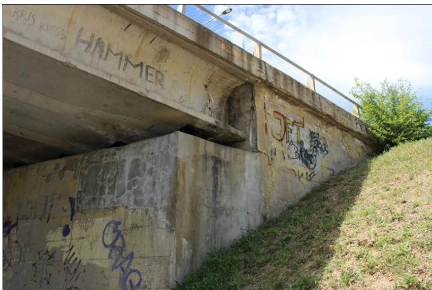
23-uložení NK na opěře 2 - rovnoběžné křídlo.JPG
