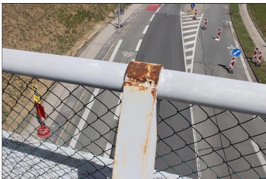
09-pravá strana zábr. svodidlo - koroze.JPG
