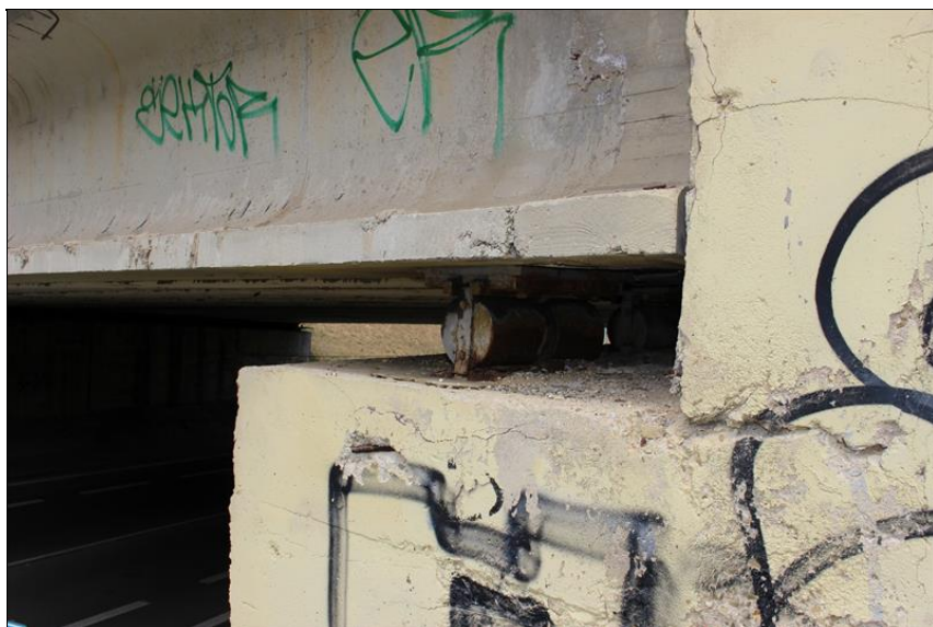
11-uložení NK na opěře 1 - koroze ložiska.JPG
