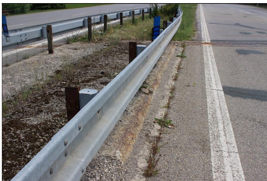
09-svodidlo na pravé straně mostu - rozpad římsy - vegetace u krajnice.JPG
