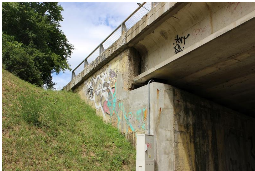
19-uložení NK na opěře 2 - degradace římky i povrchu křídla .JPG
