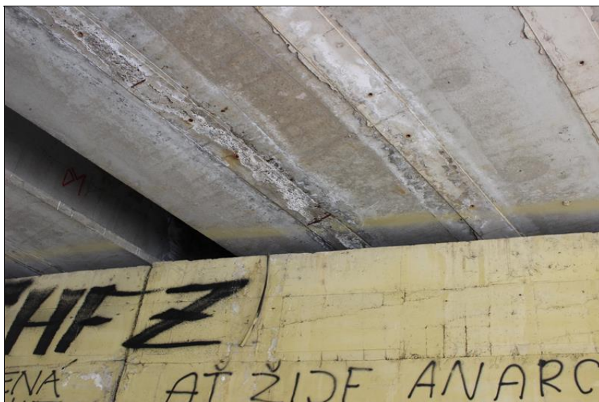
18-podhled NK u opěry 2 - váp.výluhy v dobetonávce mezi nosníky - koroze výztuže.JPG
