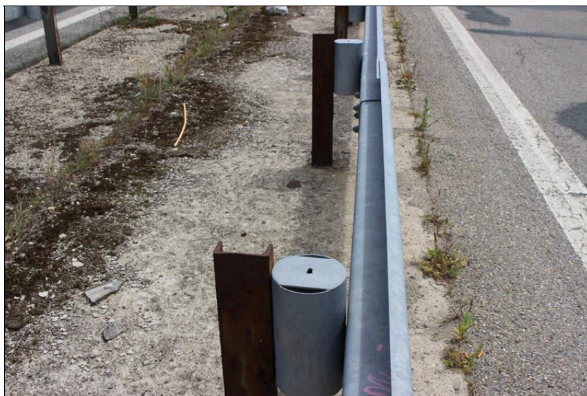
08-svodidlo na pravé straně mostu - rozpad římsy - vegetace u krajnice.JPG
