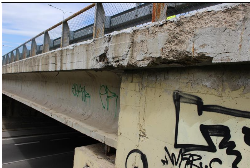
10-porušená římsa v místě křídla opěry 1.JPG
