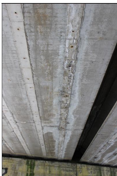
18-podhled NK u opěry 2 - váp.výluhy v dobetonávce mezi nosníky - koroze výztuže.JPG
