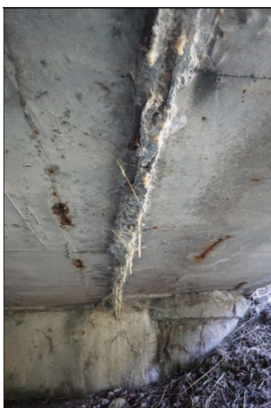
Pohled na pravou krajní spáru, zřetelné mapy po zatékání, tvorba inkrustu, na opačné straně situace stejná.
