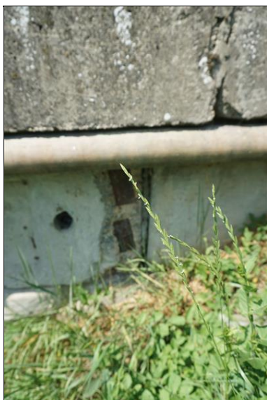
Odtržený beton za kotvama předpínacího systému na pravé straně opěry OP2.
