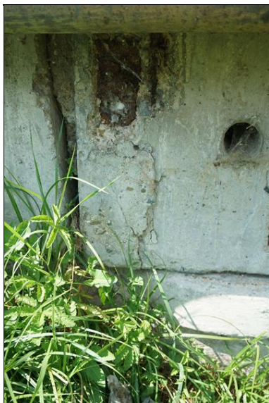
Odtržený beton za kotvama předpínacího systému na levé straně opěry OP2.
