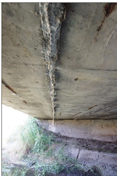
Pohled na pravou krajní spáru, zřetelné mapy po zatékání, tvorba inkrustu, na opačné straně situace stejná.
