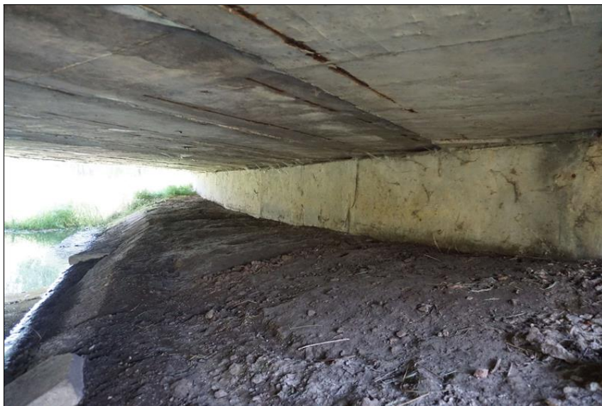
Pohled na pravou krajní spáru, zřetelné mapy po zatékání, tvorba inkrustu, na opačné straně situace stejná.
