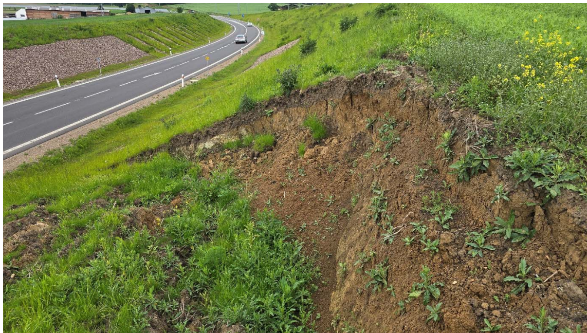
Obrázek 24: detail hlavní odtrhové linie sesuvu v pozici nejvyšší části svahu s druhotně aktivovaným pohybem
