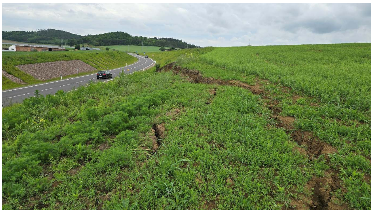
Obrázek 23: rozsah narušení horní části svahu trhlinami, podél kterých dochází k další infiltraci vody do sesuvu, trhliny jsou průměrně široké 0,15 m, lokálně i 0,2 m
