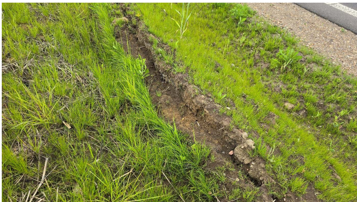
Obrázek 31: charakter posouvání horních vrstev svahu pod původní patu svahu
