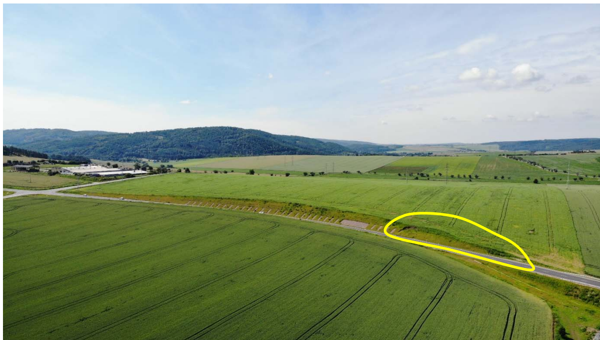
Obrázek 18: lokalizace svahové poruchy 2 v pravé straně zářezu, na kraj sesuvu navazuje stabilizace svahu dle PD pomocí štěrkových žeber, ta byla provedena oboustranně
