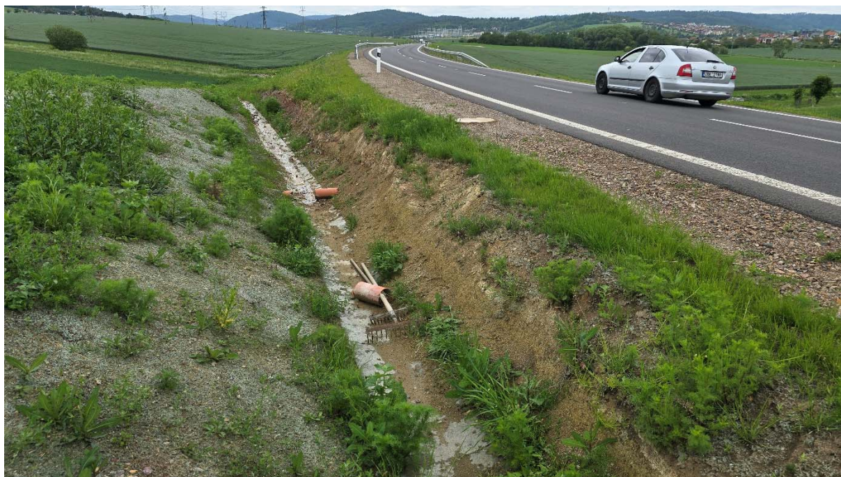
Obrázek 32: zpevněný příkop v ukončení poruchy a zářezu, PVC roura je vyústěním podélné drenáže zářezu svahu ze šachty
