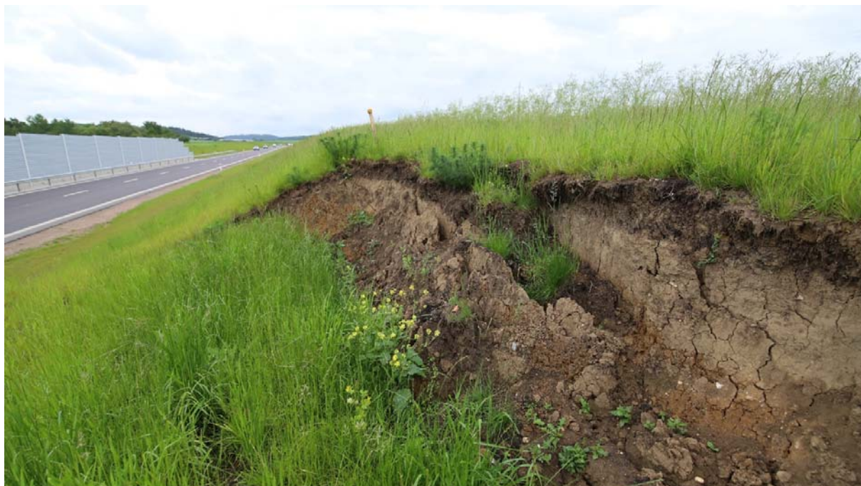
Obrázek 16: detail horní části sesuvu s odtrhovou linií a velikostí posunu a transportu zemin sesuvem
