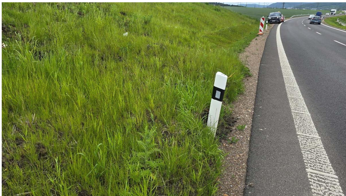
Obrázek 28: detail největšího nasunutí akumulční oblasti sesuvu ke krajnici komunikace s vyhnutím směrového sloupku
