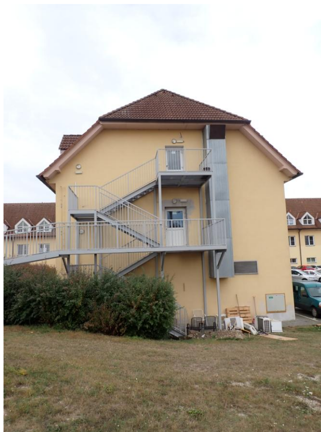
POHLED NA ŠTÍT VÝCHODNÍHO KŘÍDLA HLAVNÍHO OBJEKTU
