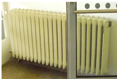
Obrázek 3: Stávající OT typu KALOR –DEMONTOVAT vč. přípojek a armatur
