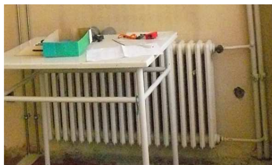
Obrázek 4: Stávající OT typu KALOR –DEMONTOVAT vč. přípojek a armatur
