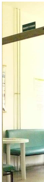
Obrázek 2: Stávající stoupačka 8a bude přeložena do zdi
