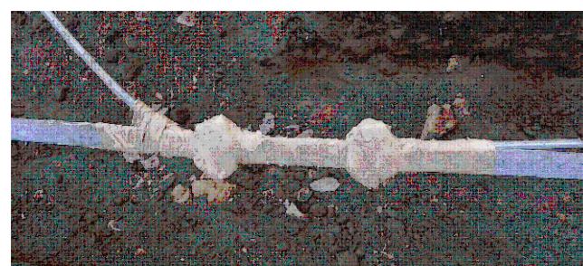
VZOR ANTIKORÍ OCHRANY SPOJŮ ANTIKOROZNÍ PÁSKOU A VULKANIZAČNÍ PÁSKOU
