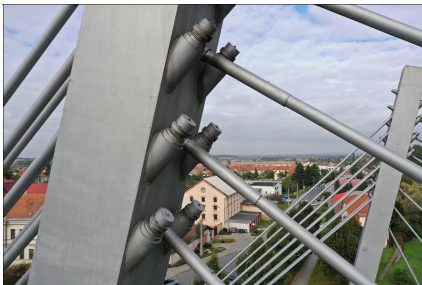
22.JPG Spodní kotvy kotevních lan na levém pylonu
