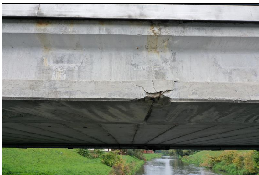
15.JPG Levý hl. nosník v místě mezi 5. a 6. závěsem.
