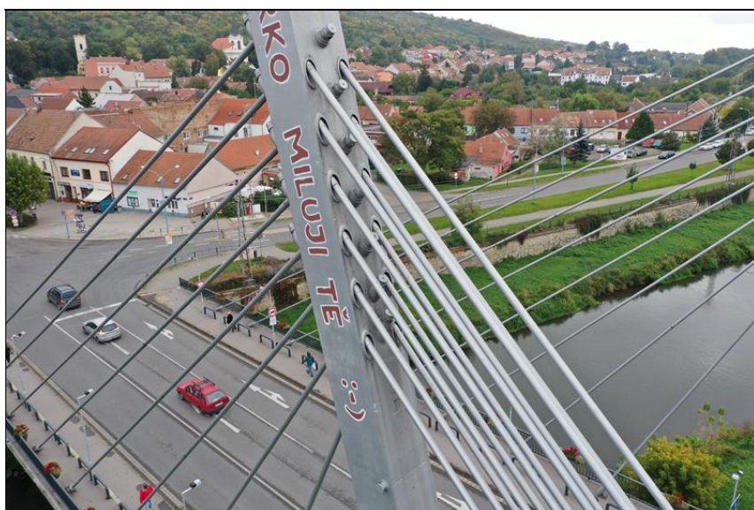
30.JPG Horní část pravého pylonu v pohledu z levé (návodní) strany mostu.
