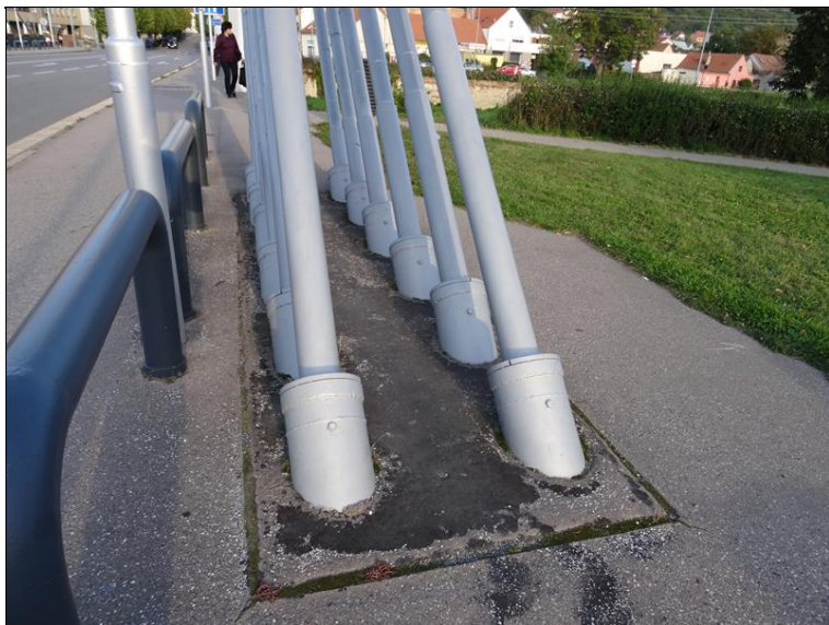
25.JPG Kotevní lana za levým pylonem.
