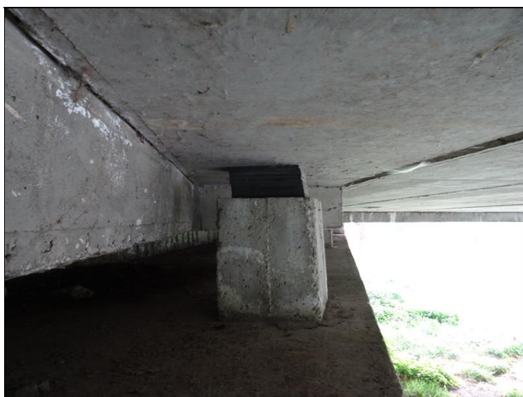
50.JPG Boční pohled na 2. podložiskový bloček s ložisky zprava (návodní strana).
