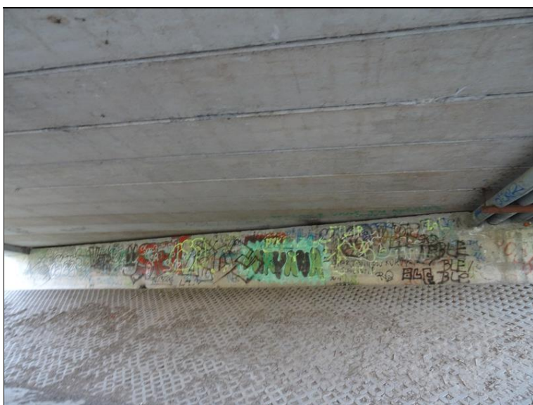
6.JPG Pohled na opěru 2 (Op2).
