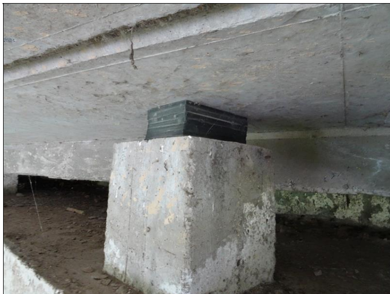
52.JPG Boční pohled na 3. podložiskový blok s rovnaninou 7 ložisek zleva.
