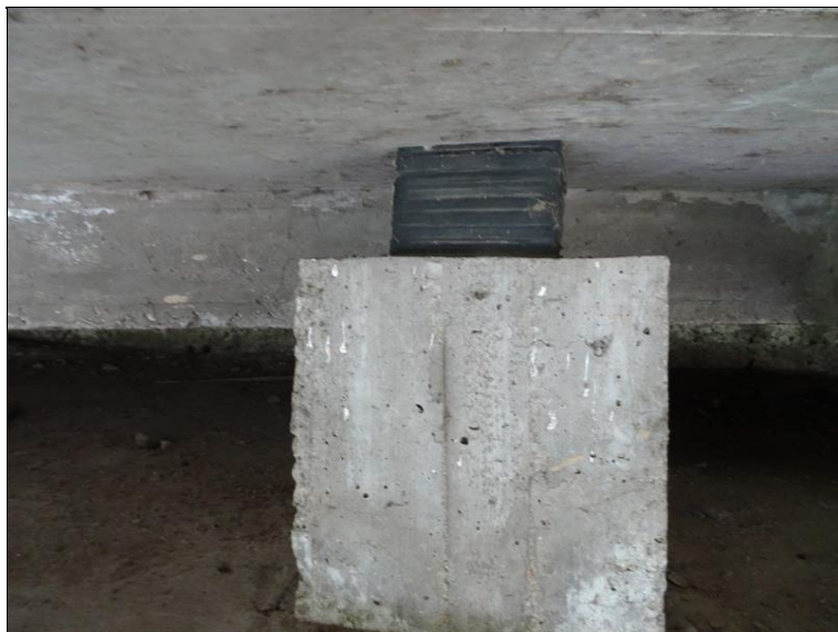
49.JPG Čelní pohled na 2. (mostovkový) podložiskový blok s rovnaninou 8 ložisek na Op1.
