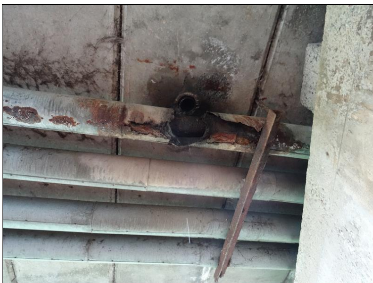
57.JPG Vyústění odvodňovače pravé strany vozovky před u Op1. Poloha vyústění je přímo nad zavěšeným potrubním.
