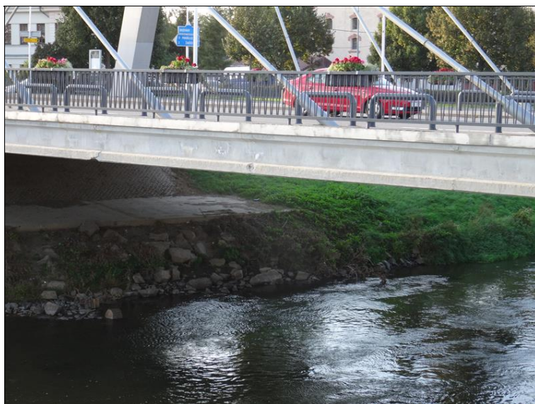
14.JPG Fasáda levého hl. nosníku.
