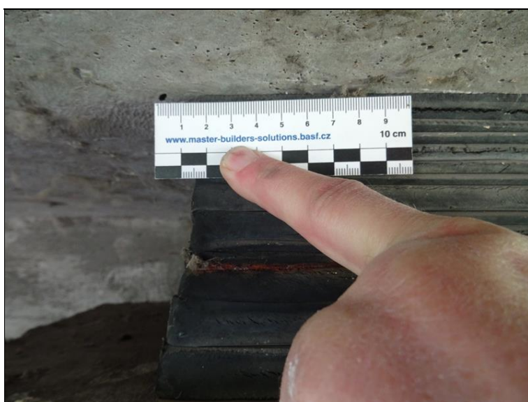
45.JPG Příčný posun 1. rovnaniny ložisek.
