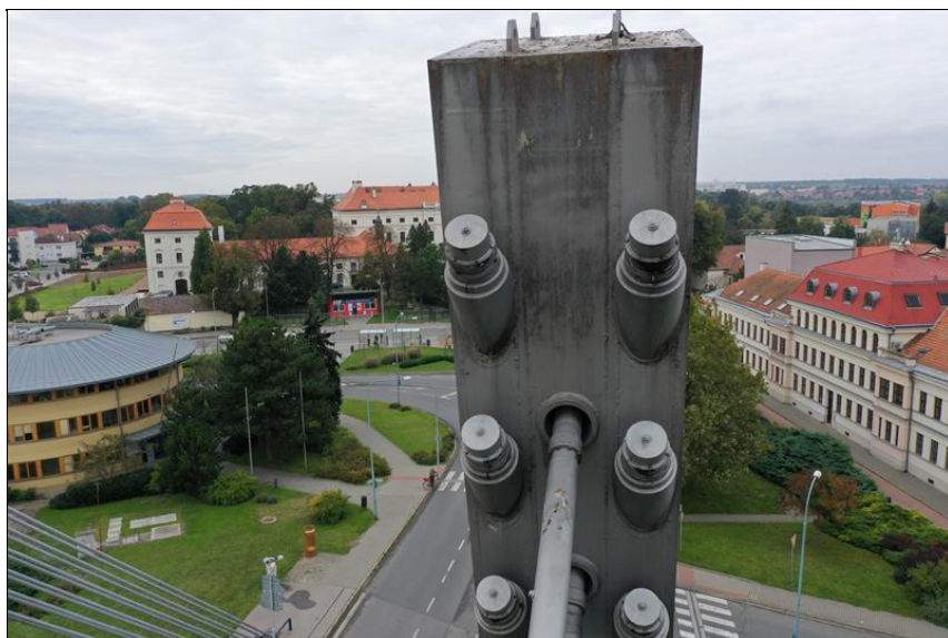
29.JPG Horní část pravého pylonu s kotvami kotevnicích lan.
