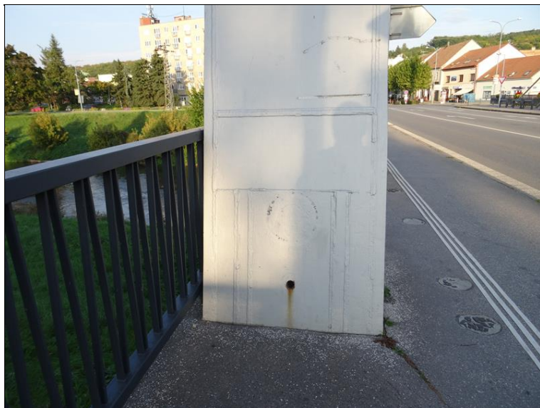
31.JPG Pata pravého pylonu - odvod. otvor pylonu.
