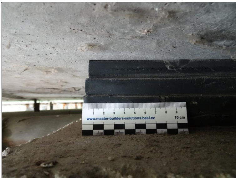
56.JPG Podélný posun 4. rovnaniny ložisek.
