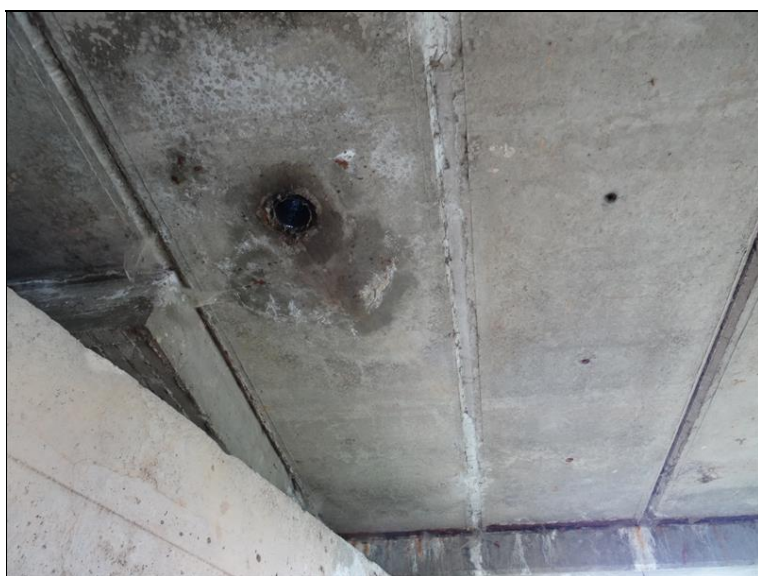
42.JPG Vyústění odvodňovače vozovky při levé straně na podhledu mostovky před Op1.
