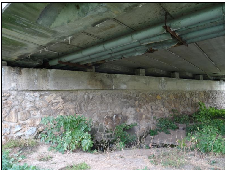
5.JPG Pohled na opěru 1 (Op1).
