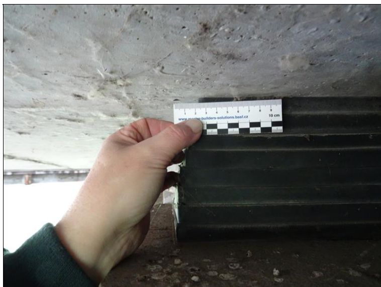
51.JPG Podélný posun 2. rovnaniny ložisek v pohledu z levé strany.
