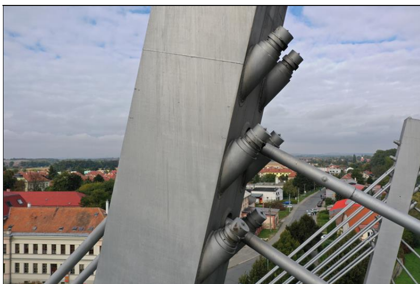
21.JPG Horní kotvy kotevní lan na levém pylonu.
