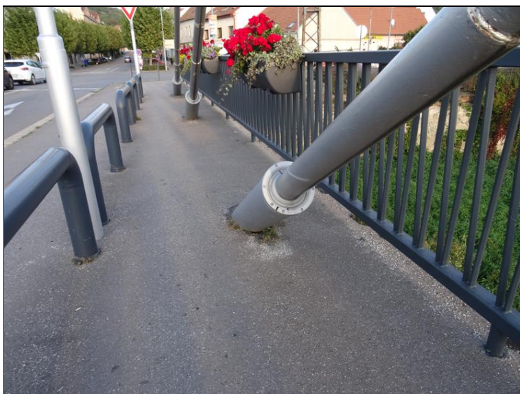
27.JPG Levý chodník - poloha prostupu pouzder tlumičů závěs. lan chodníkem.
