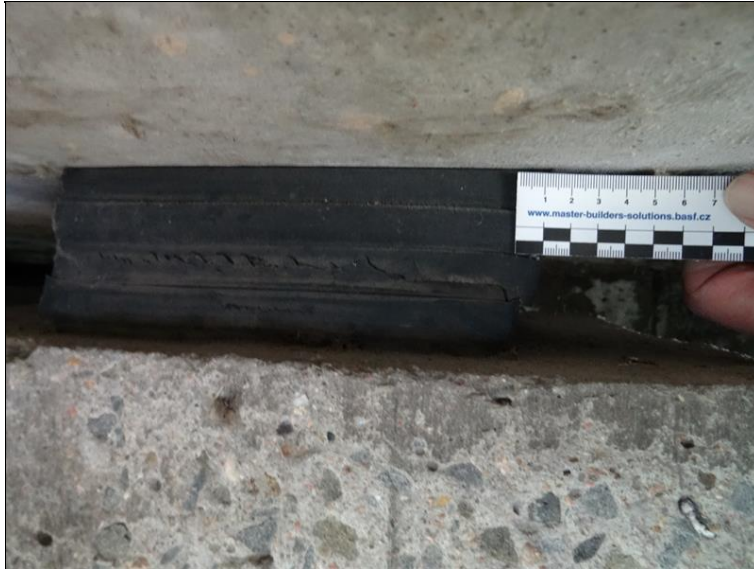
55.JPG Příčný posun 4. rovnaniny ložisek.
