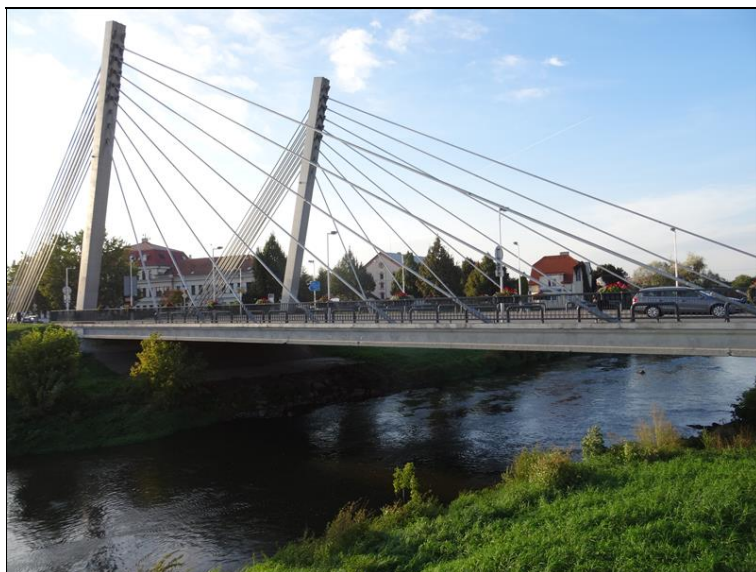
3.JPG Pohled na most zleva.
