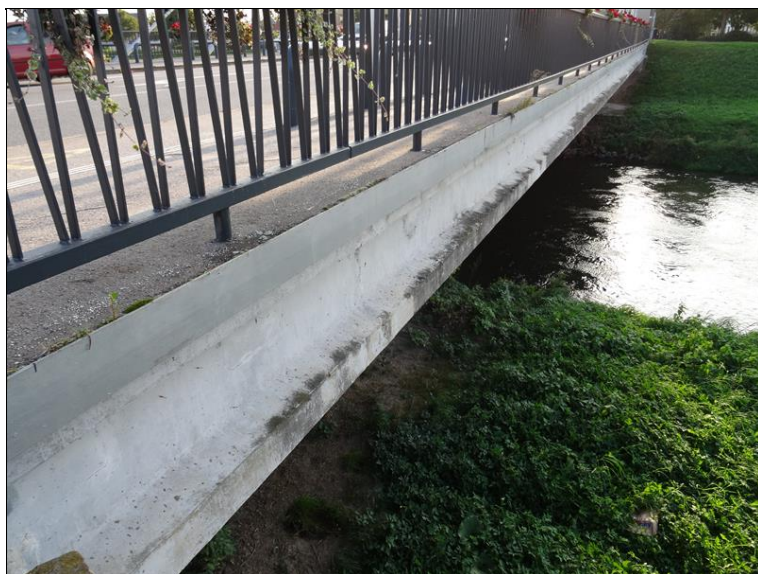
19.JPG Fasádní strana pravého hl. nosníku.
