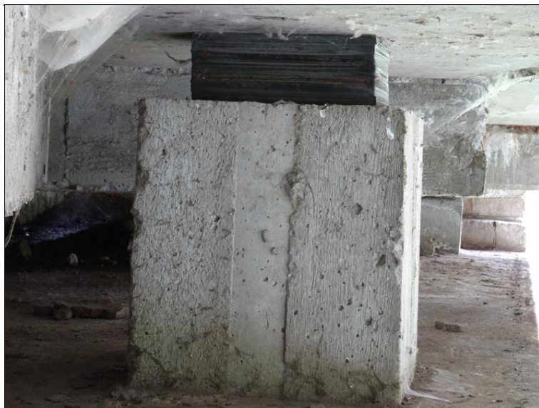
46.JPG 1. rovnánina ložisek v pohledu z pravé (návodní) strany.
