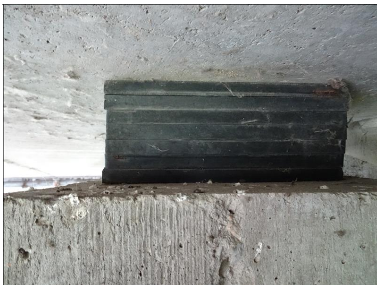
47.JPG 1. rovnánina ložisek v pohledu z levé (povodní) strany.
