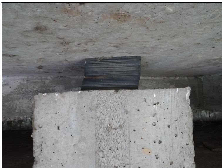
43.JPG Čelní pohled na 1.podložiskový blok mostovky zleva s rovnaninou 7 elastomerových ložisek.
