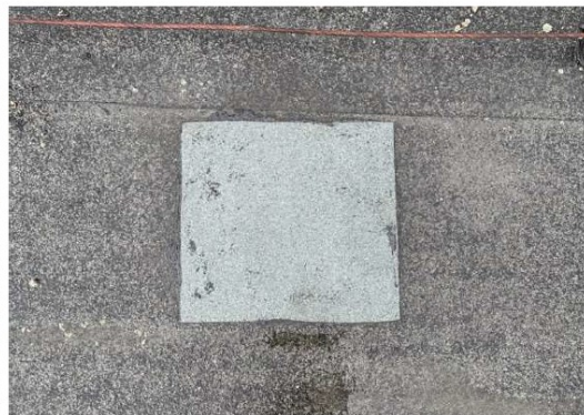
foto/8/ Pohled na zapravenou sondu S4
