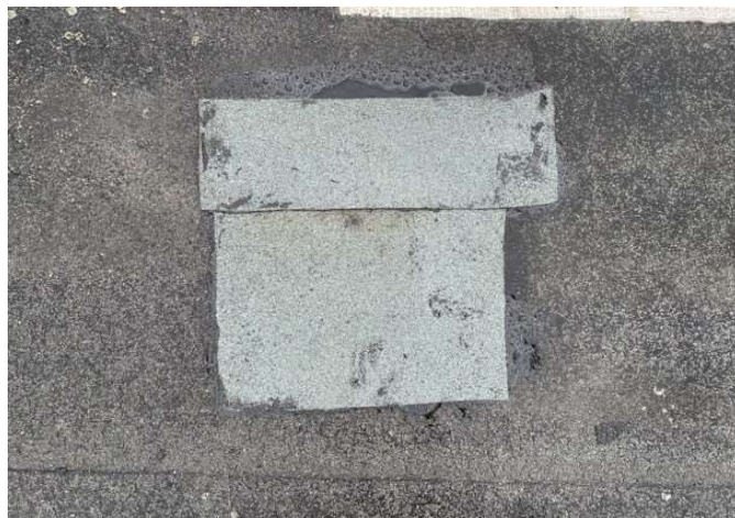
foto/6/ Pohled na zapravenou sondu S3
