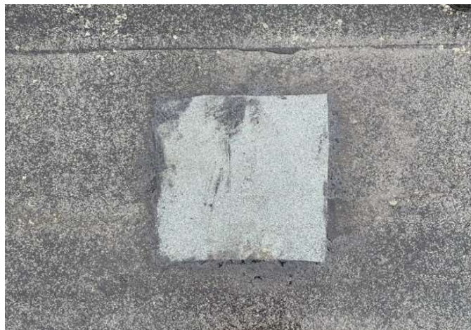
foto/4/ Pohled na zapravenou sondu S2
