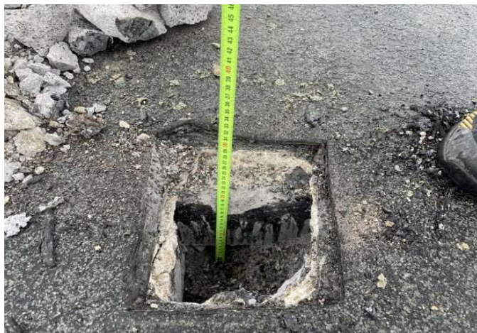
foto/3/ Pohled na provedenou sondu S2
