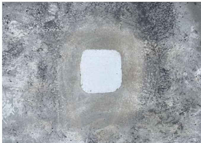
foto/12/ Pohled na zapravenou sondu S6
