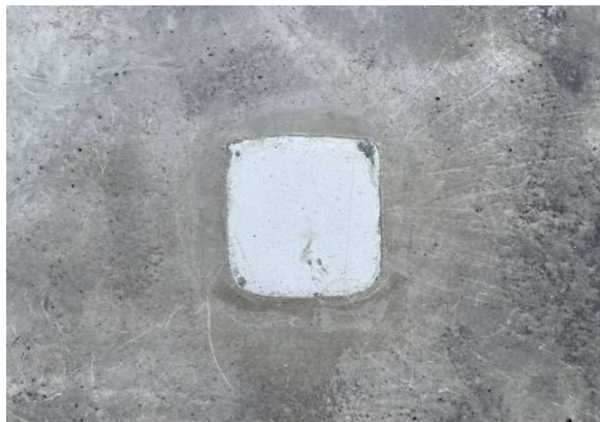
foto/10/ Pohled na zapravenou sondu S5
