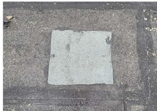
foto/2/ Pohled na zapravenou sondu S1
