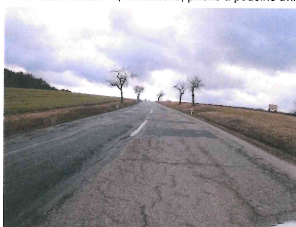
Hlubková koroze, příčné a podélné trhliny, vysprávký
