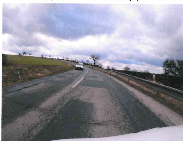
Hlubková koroze, mozaikové, příčné a podélné trhliny
