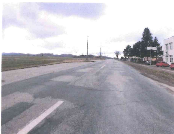
Hl. koroze, vyjeté koleje, trhliny, zvýšené nezp. krajnice
