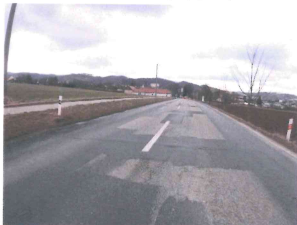
Hl. koroze, vysprávkky, olamování okrajů, trhliny
