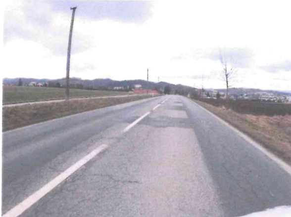
Hl. koroze, vyjeté koleje, mozaikové trhliny, vysprávkky
