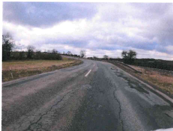
Hl. koroze, výtlučky, síťové trhliny, vysprávký, deformace
