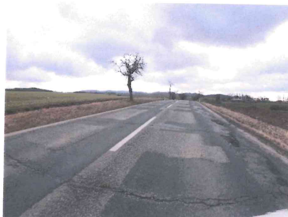
Hl. koroze, příčné rozvětvené trhliny, olamování okrajů
