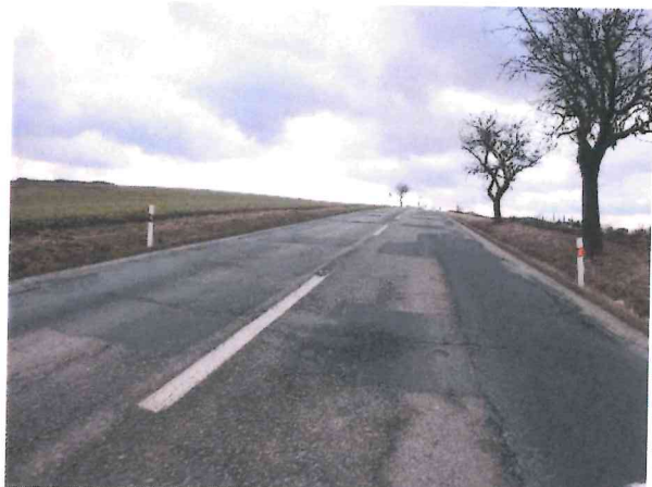
Ztráta makrotextury, vysprávký, mozaikové trhliny
