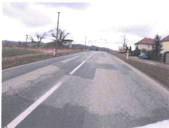
Hl. koroze, mozaikové trhliny, vysprávkky
