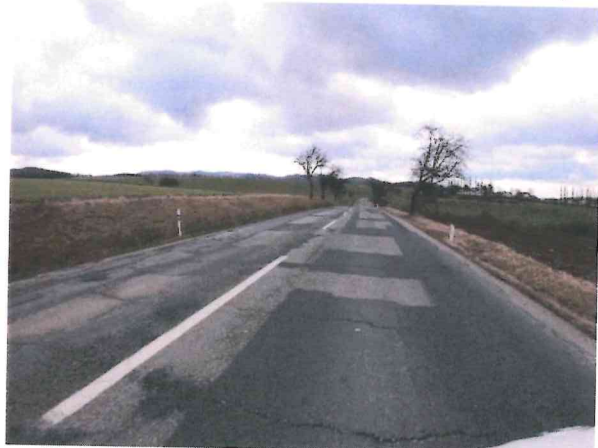
Hl. koroze, vysprávký, příčné trhliny, vyjeté koleje
