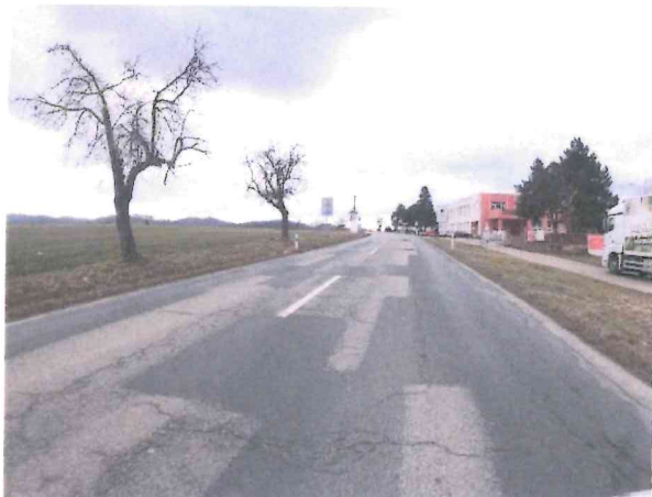
Hl. koroze, mozaikové trhliny, vysprávkky,
