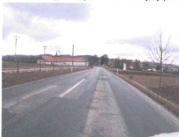
Hl. koroze, vyjeté koleje, podélné trhliny, vysprávkky
