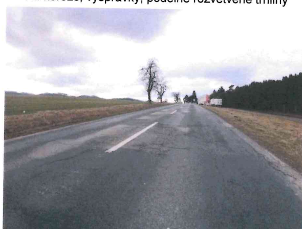
ztráta makrotextury, vysprávký, mozaikové trhliny
