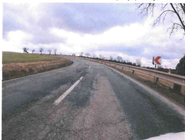
Hlubková koroze, mozaikové, příčné a podélné trhliny
