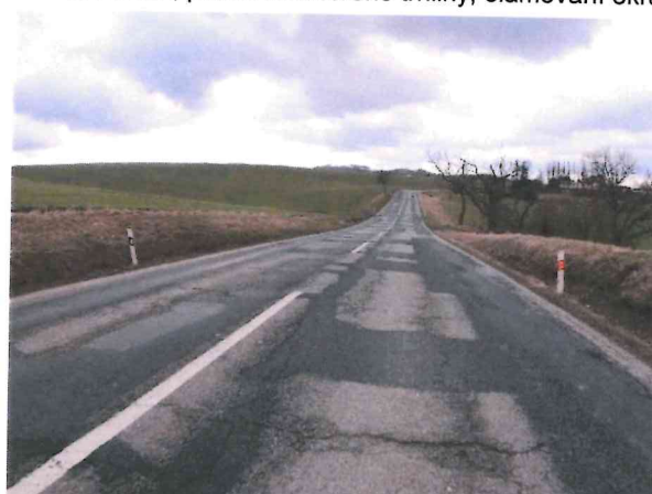
Hl. koroze, vysprávký, mozaik. trhliny, olamování okrajů
