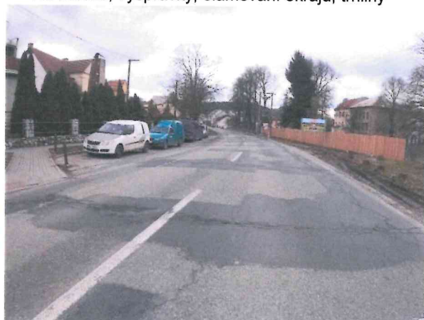
Hl. koroze, příčné rozvětvené trhliny, vysprávkky
