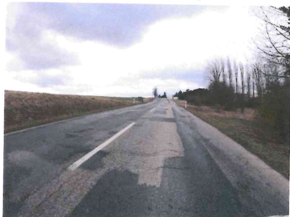
Hl. koroze, mozaikové až síťové trhliny, nepr. hrboły
