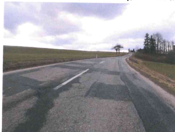
Hl. koroze, vysprávký, podélné rozvětvené trhliny
