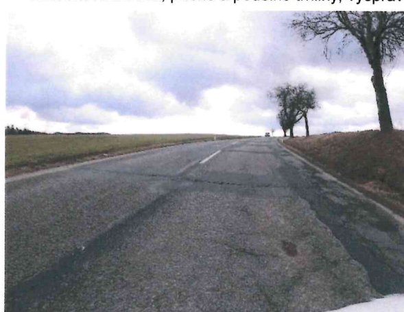
Hl. koroze, podélné a příčné trhliny, vysprávký
