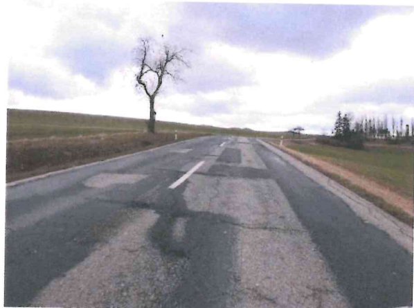
Hl. koroze, vyjeté koleje, vysprávký, mozaikové trhliny
