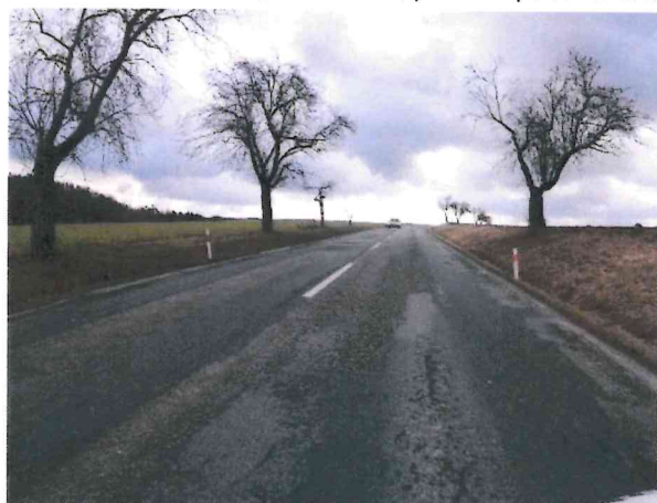
Ztráta makrotextury, vysprávký, mozaikové trhliny
