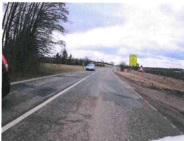
Hl. koroze, podélné a mozaik. trhliny, plošná deformace
