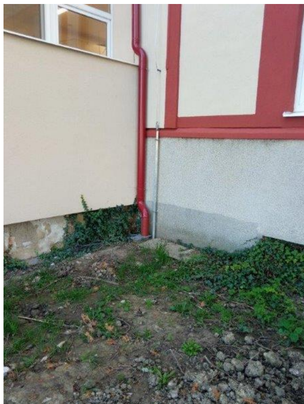
Foto 10: Pohled od severu na místo napojení budovy jídelny na podélný trakt
