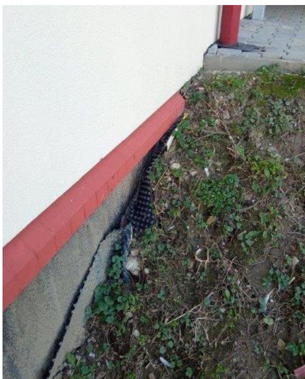
Foto 23: Nedbale ukončená nopová fólie v místě nové přístavby nouzového schodiště v západní části objektu
