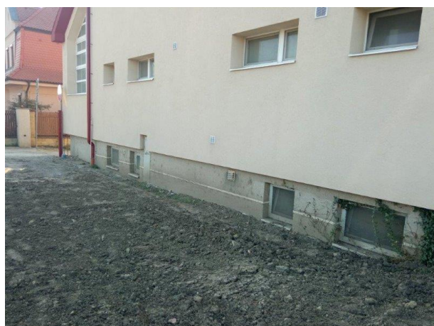
Foto 11: Pohled na dolní část fasády budovy jídelny směrem do ulice
