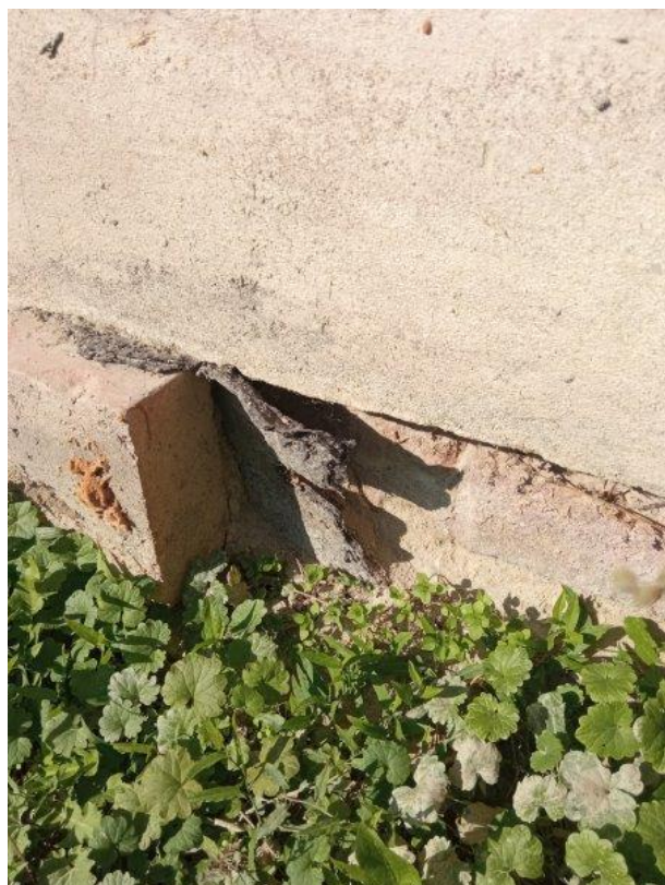
Foto 18: Detail odhalené části stávající hydroizolace spodní stavby na obvodové zdi nepodsklepeného zadního traktu
