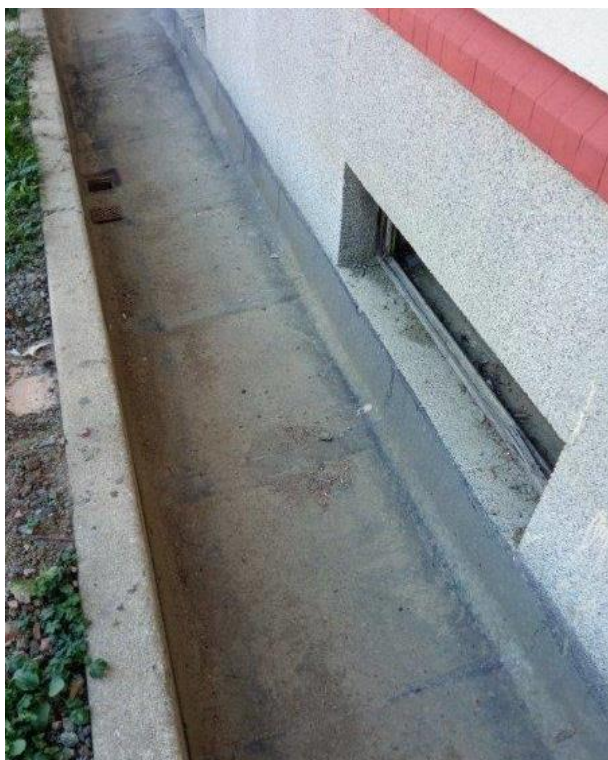
Foto 5: Detail dna anglického dvorku s asfaltovou hydroizolací
