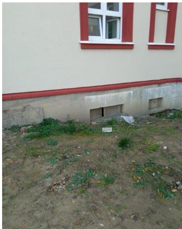
Foto 6: Pohled na terén a dolní část fasády v místě napojení podélného a příčného traktu na severozápadní straně. Detail rohu viz foto 24
