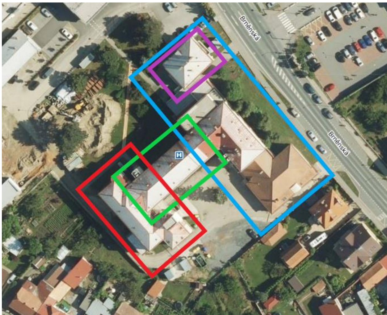
Letecký snímek areálu: modře vyznačeno podélný trakt souběžný s ulicí Brněnskou, zeleně označen příčný trakt a červeně zadní trakt, fialově označená budova laboratoře a vedení nemocnice
