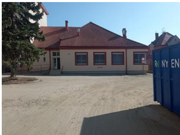
Foto 13: Pohled na budovu jídelny z nádvoří
