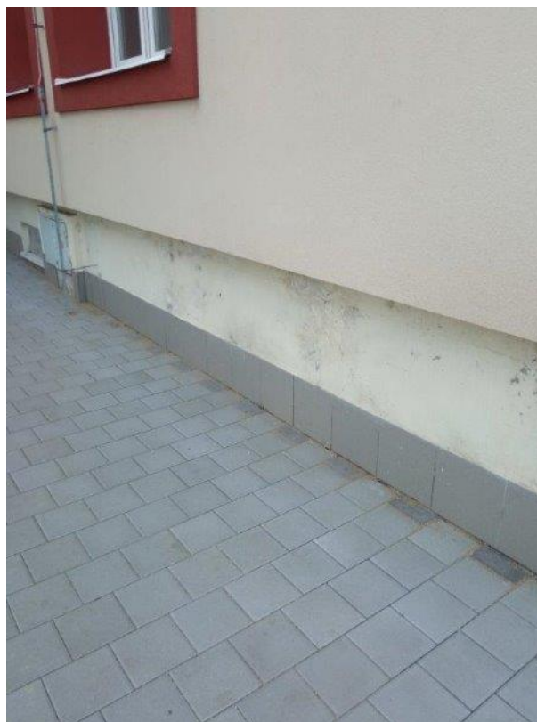
Foto 8: Pohled od jihovýchodu na dolní část fasády budovy severozápadní nároží budovy laboratoře a vedení
