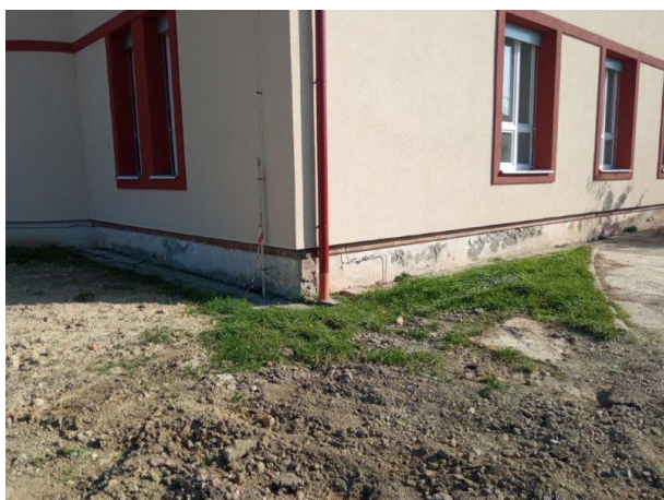
Foto 3: Pohled od severozápadu na dolní část fasády zadního traktu
