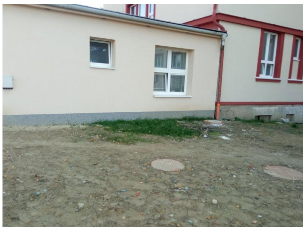
Foto 7: Pohled od západu na místo napojení přístavby vstupu na původní severní štít podélného traktu
