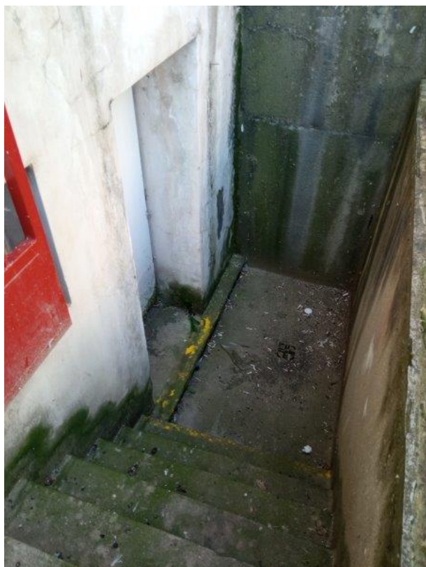
Foto 17: Pohled do vstupu do výtahové šachty na nádvoří
