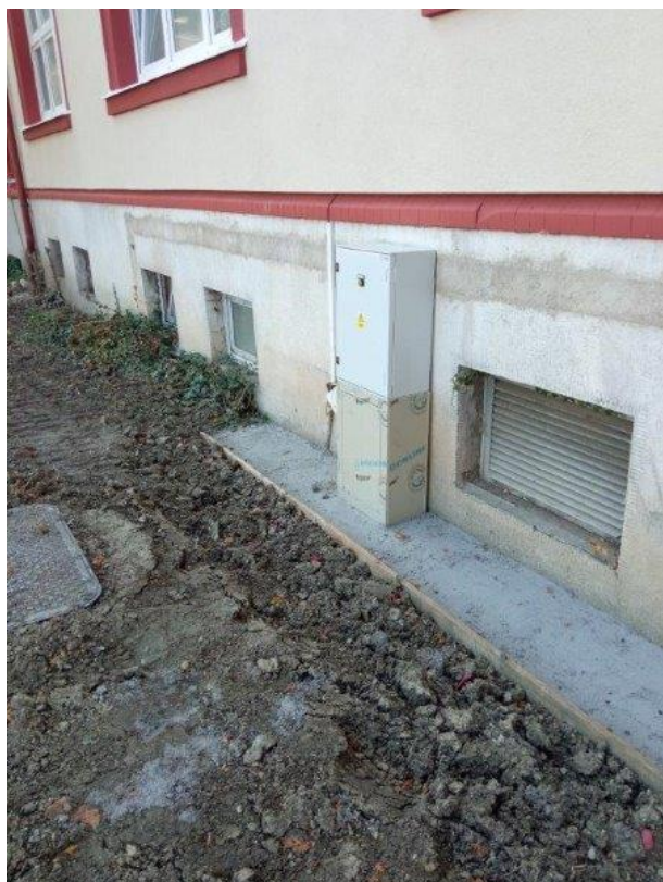
Foto 9: Pohled na dolní část uliční fasády podélného traktu.
