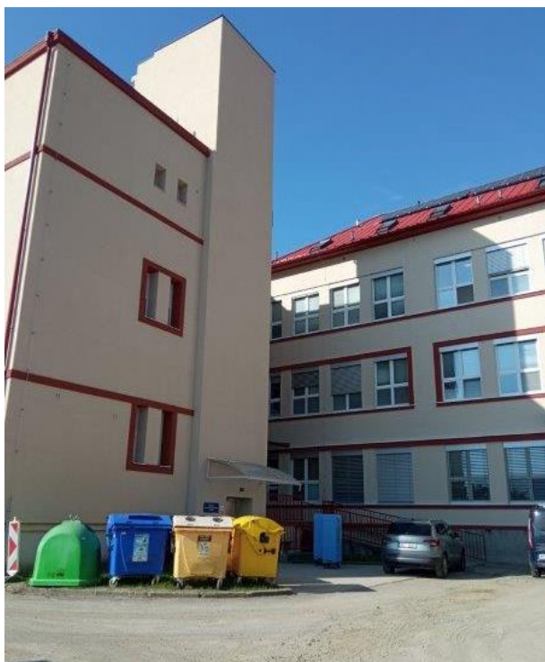
Foto 1: Pohled z nádvoří západním směrem, vlevo zadní trakt, vpravo příčný trakt
