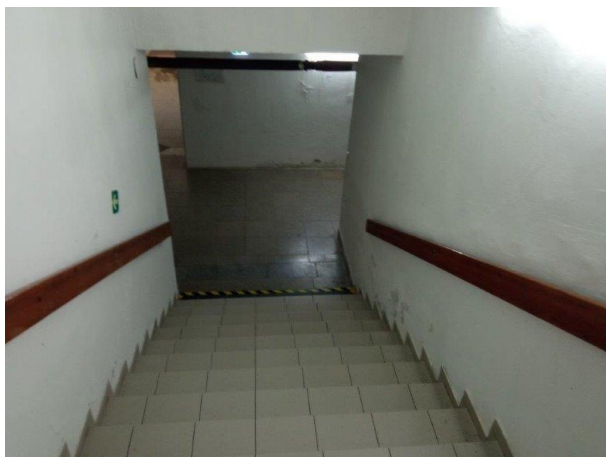
Foto 37: Pohled na schodiště do suterénu podélného a příčného traktu
