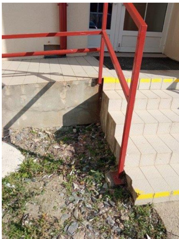
Foto 15: Venkovní schodiště a rampa před vchodem z nádvoří do jídelny.
