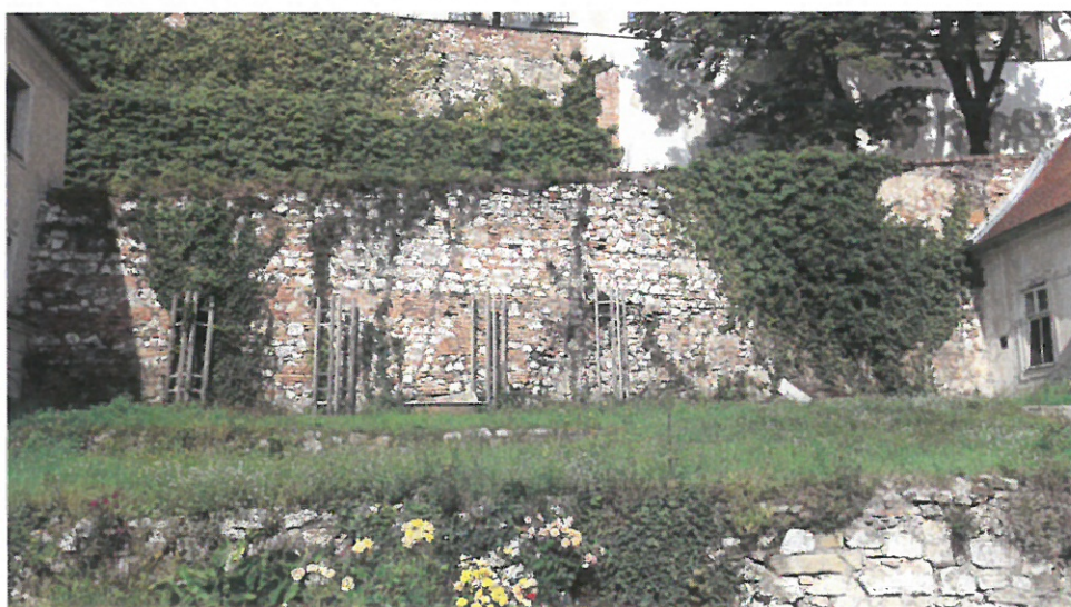
Obr. 2 – pohled na opěrnou stěnu
