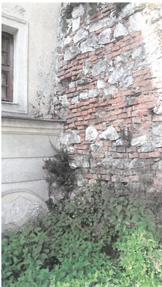
Obr. 3 – zdivo opěrné stěny
