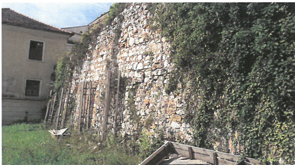
Obr. 8 – pohled zdivo opěrné stěny
