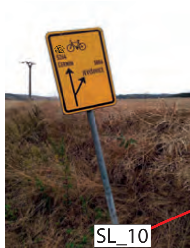
UPRAVIT STÁVAJÍCÍ IS20 DOLEPENÍM LOGA MLYNÁŘSKÉ STEZKY (1x) PŘEBETONOVAT SLOUPEK
