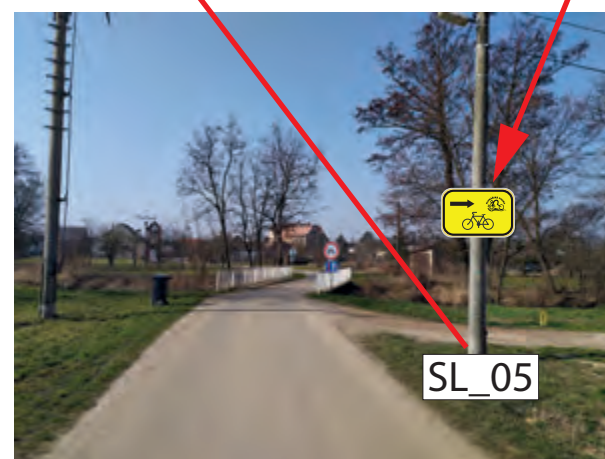
INSTALACE IS21b A IS21c (MLYNÁŘSKÁ) V OBOU SMĚRECH NA BETONOVÉM SLOUPU ROZHLASU
