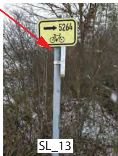
INSTALACE IS21b A IS21c (MLYNÁŘSKÁ) PRO OBA SMĚRY NA STÁVAJÍCÍM SLOUPKU, ŘAZENÍ SMĚRŮ POD SEBE POSUNEM IS21b (5264)
