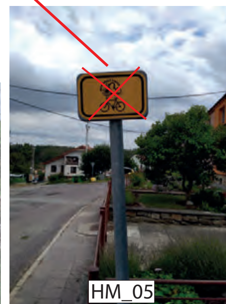
DEMONTÁŽ STÁVAJÍCÍ IS21a (MLYNÁŘSKÁ) MONTÁŽ NOVÉ IS21b (MLYNÁŘSKÁ) NA STÁVAJÍCÍM SLOUPKU
