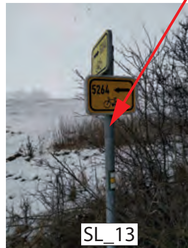
INSTALACE IS21b A IS21c (MLYNÁŘSKÁ) PRO OBA SMĚRY NA STÁVAJÍCÍM SLOUPKU, ŘAZENÍ SMĚRŮ POD SEBE POSUNEM IS21b (5264)
