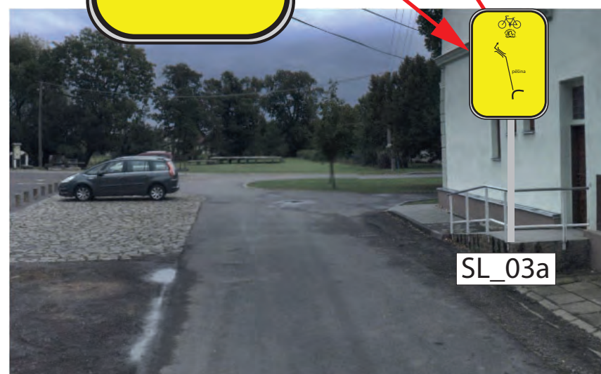
INSTALACE IS20 (MLYNÁŘSKÁ) NA NOVÉM SLOUPKU, INSTALACE PÁSKOU K ZÁBRADLÍ NA RAMPĚ DOMU (OBCNÍ ÚŘAD), POZEMEK: PARC. Č. 32/32, K.Ú. SLUP (OBEČ SLUP)
