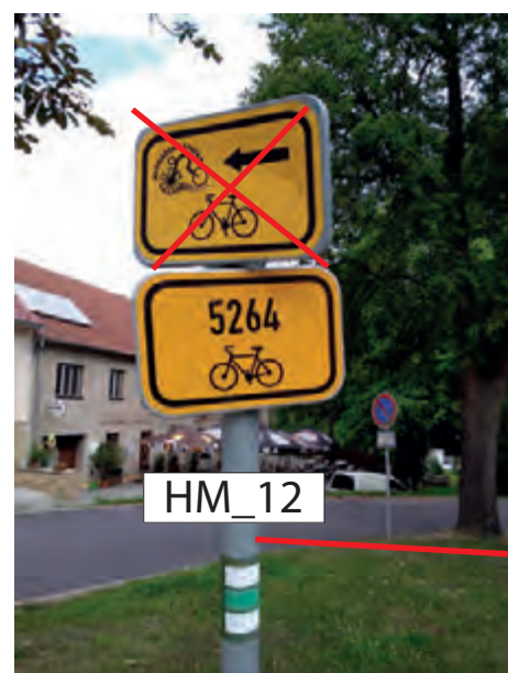
DEMONTÁŽ PŮVODNÍHO ZNAČENÍ IS21b (MLYNÁŘSKÁ) MONTÁŽ NOVÉ IS21a (MLYNÁŘSKÁ) NA STÁVAJÍCÍ SLOUPEK UMÍSTĚNÍ NAD STÁVAJÍCÍ IS21a (5264)
