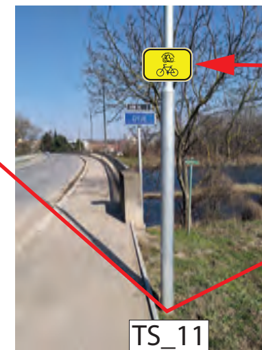
INSTALACE IS21a (MLYNÁŘSKÁ) V JEDNOM SMĚRU NA SLOUPU VEŘEJNÉHO OSVĚTLENÍ
