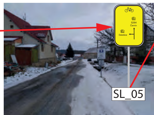
INSTALACE IS20 (MLYNÁŘSKÁ + 5264) V JEDNOM SMĚRU NA NOVÉM SLOUPKU V KOTEVNÍ PATCE
