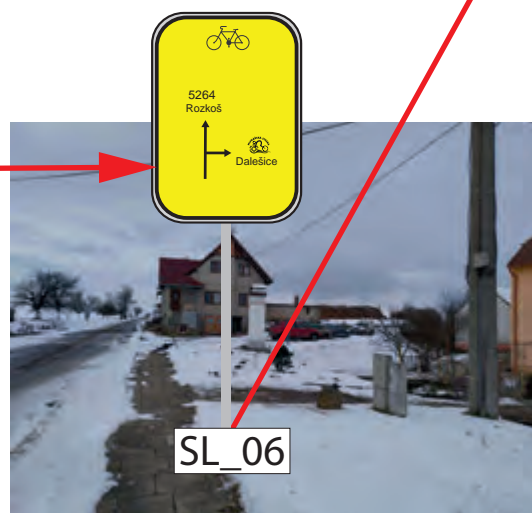
INSTALACE IS20 (MLYNÁŘSKÁ + 5264) V JEDNOM SMĚRU NA NOVÉM SLOUPKU V KOTEVNÍ PATCE
