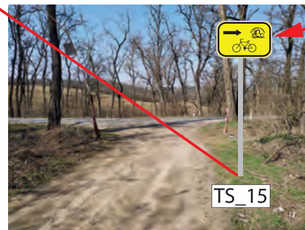
INSTALACE IS21c (MLYNÁŘSKÁ) NA NOVÉM SLOUPKU V ZEMNÍ BETONOVÉ PATCE POZEMEK: PARC. Č. 4127, K.Ú. TASOVICE (OBEC TASOVICE)
