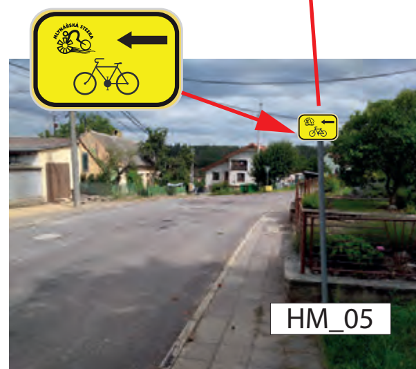
DEMONTÁŽ STÁVAJÍCÍ IS21a (MLYNÁŘSKÁ) MONTÁŽ NOVÉ IS21b (MLYNÁŘSKÁ) NA STÁVAJÍCÍM SLOUPKU
