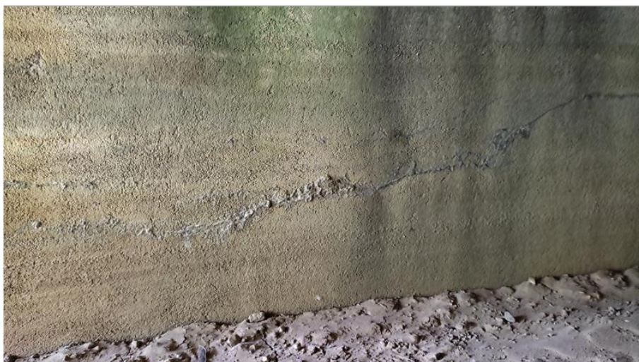
Opěra OP2 vlevo - vodorovná trhlina.jpg
