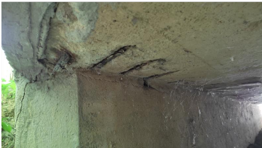
Opěra OP1 vpravo - odpadená krycí vrstva.jpg
