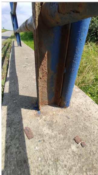
Detail koroze zábradlí.jpg
