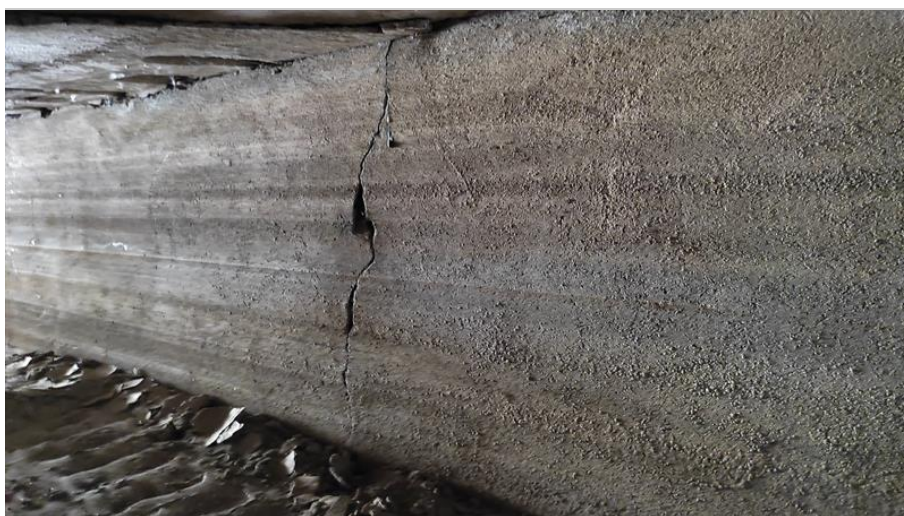
Zhruba v polovině opěry OP2 svislá trhlinka.jpg
