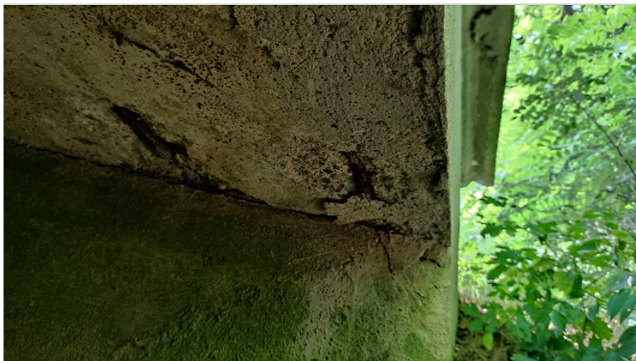
Zdegradovaný betonový povrch. Malá krycí vrstva betonu která je na mnoha místech odpadlá.jpg
