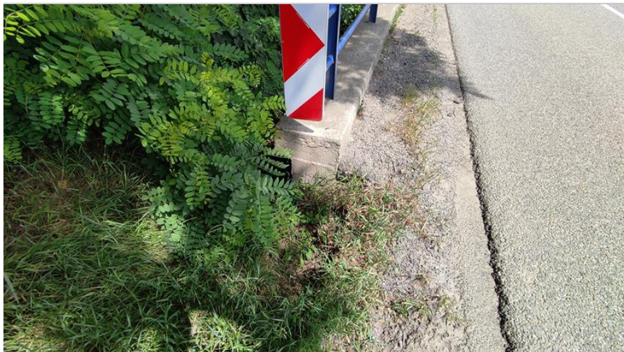
Propad krajnice za opěrou OP2 vpravo.jpg
