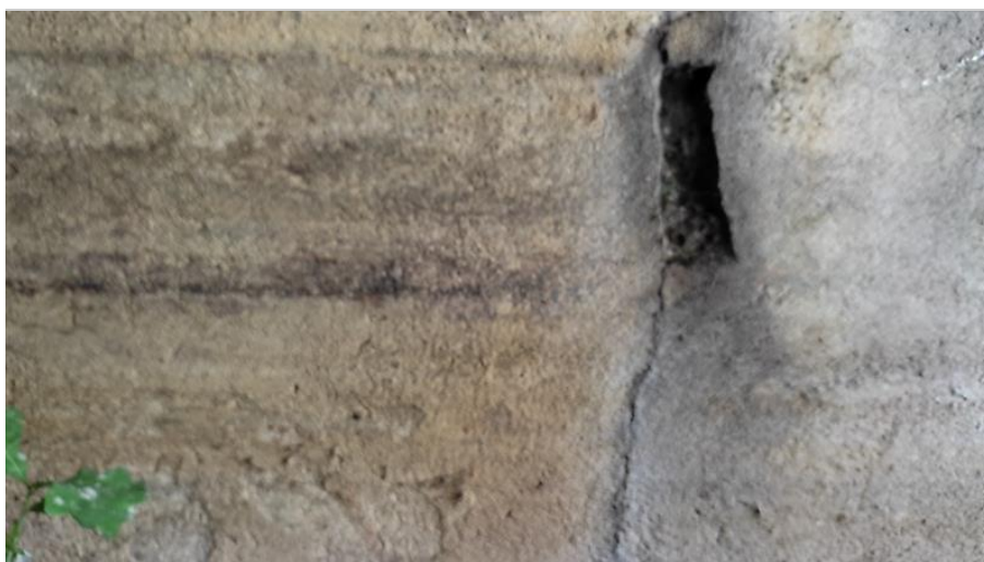
Opěra OP1 vlevo - svislé trhliny odpadená omítka zavlhnutí.jpg
