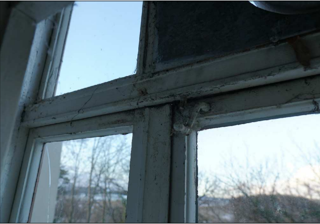
DETAIL ZAOBLENÍ HORNÍHO KŘÍDLA U NADSVĚTLÍKU
