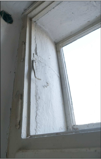
DETAIL PANTU, CHYBĚJÍCÍ KŘÍDLO
