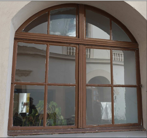
VNĚJŠÍ POHLED OKNO S OBLOUKOVÝM NADSVĚTLÍKEM
