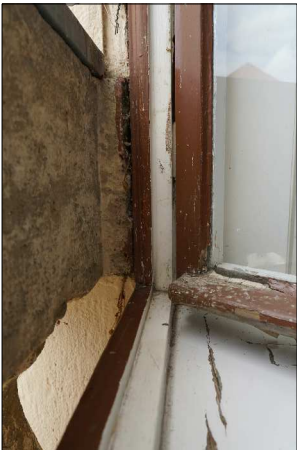
DETAIL NAPOJENÍ NA VNĚJŠÍ OSTĚNÍ A TRÁMEC BALUSTRÁDY
