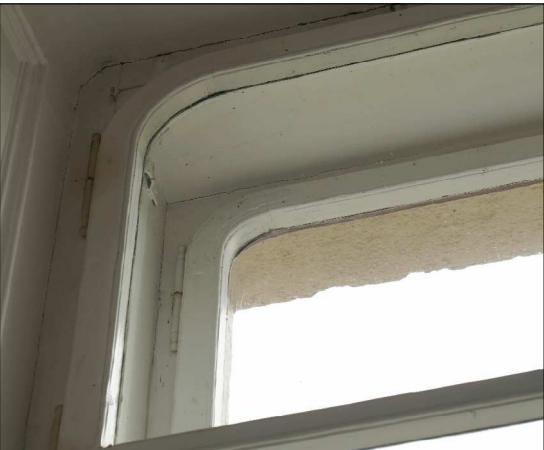
DETAIL ZAOBLENÍ HORNÍHO KŘÍDLA U NADSVĚTLÍKU
