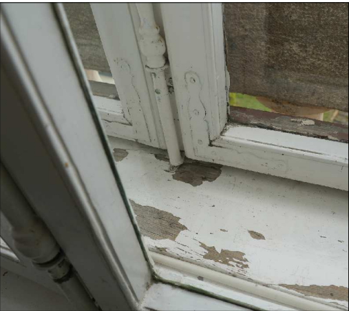
DETAIL VNITŘNÍHO PARAPETNÍHO VLYSU A ROHOVNÍKŮ KŘÍDEL
