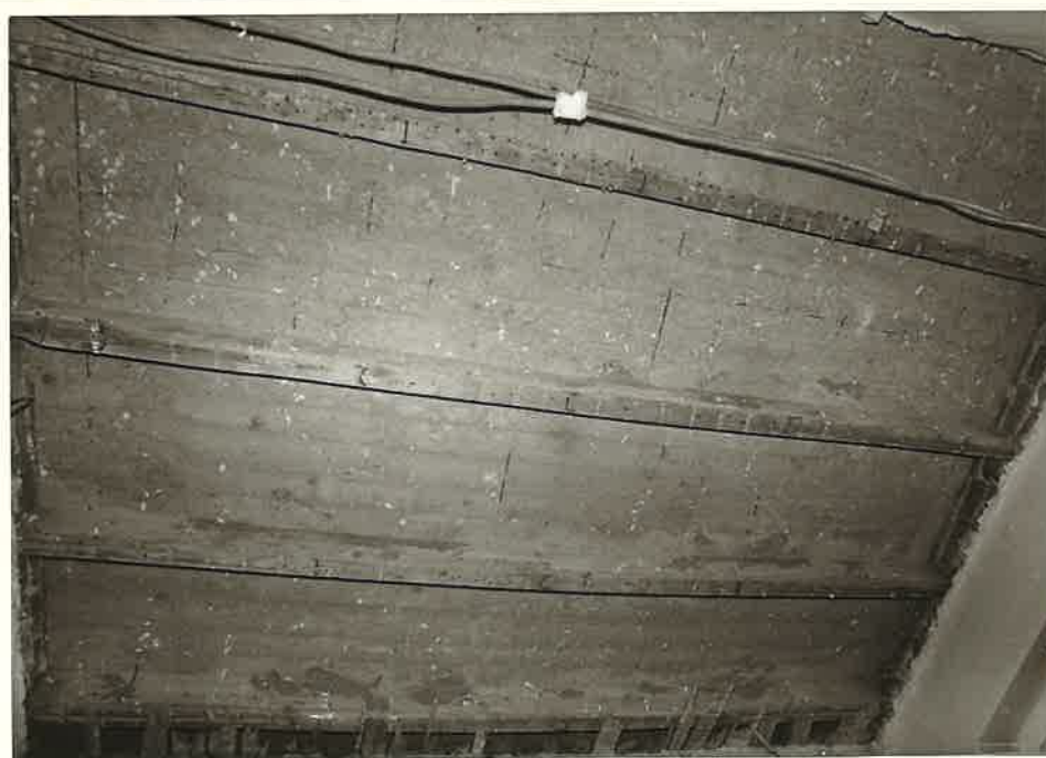
F.č. 6 - Armovací síť a ŽB desky je místy bez krycí vrstvy a výztuž je obnažena.
