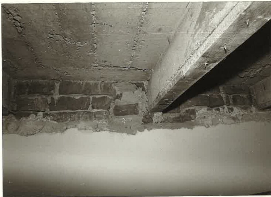
F.č. 9 - Uložení nosné ŽB konstrukce na zdivo.
