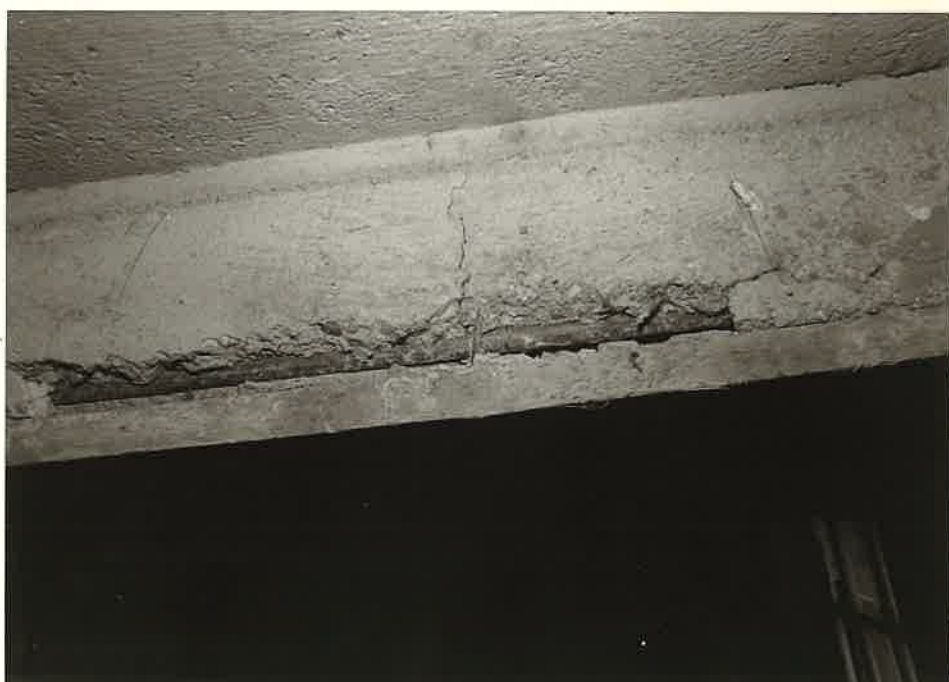
F.č. 11, 12 - Malá krycí vrstva nekvalitního betonu odpadává a tím dochází k obnažení výztuže.
