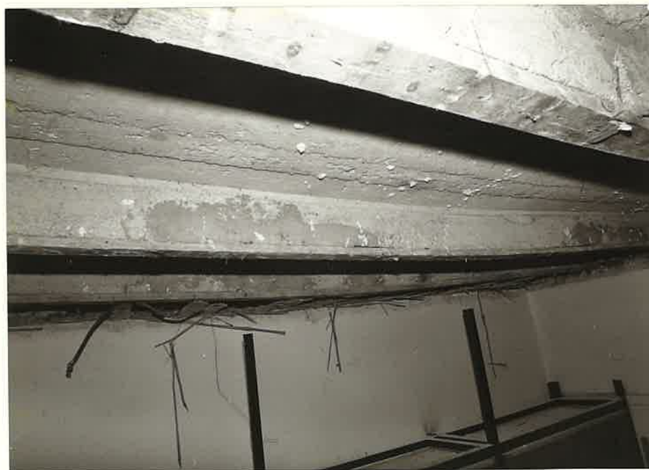
F.č. 4 - Výrazný průhyb ŽB stropního trámu. Trhliny na žebrech byly již v minulosti zamazány cementovým potěrem.
