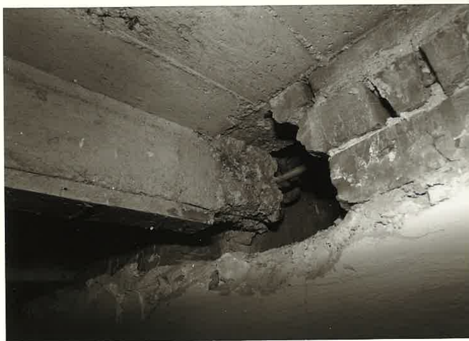
F.č. 10 - Uložení ŽB žebra po odstranění zdiva.
