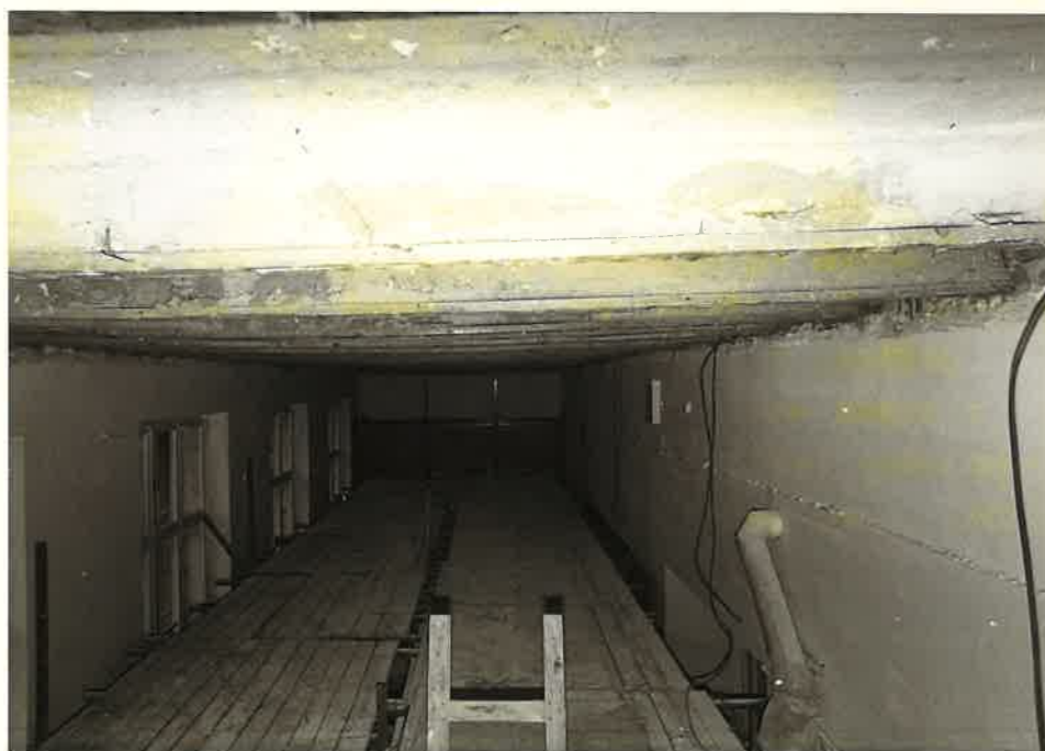
F.č. 1, 2 - Celkové pohledy na obnažený železobetonový žebrový strop v kabinetu chemie, kde byl průhyb největší. Trhliny na žebrech byly již v minulosti zamazány cementovým potěrem.
