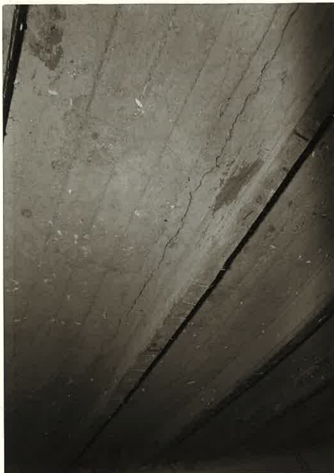
F.č. 5 - Deska mezi žebry je na některých místech výrazně narušena trhlinami.
