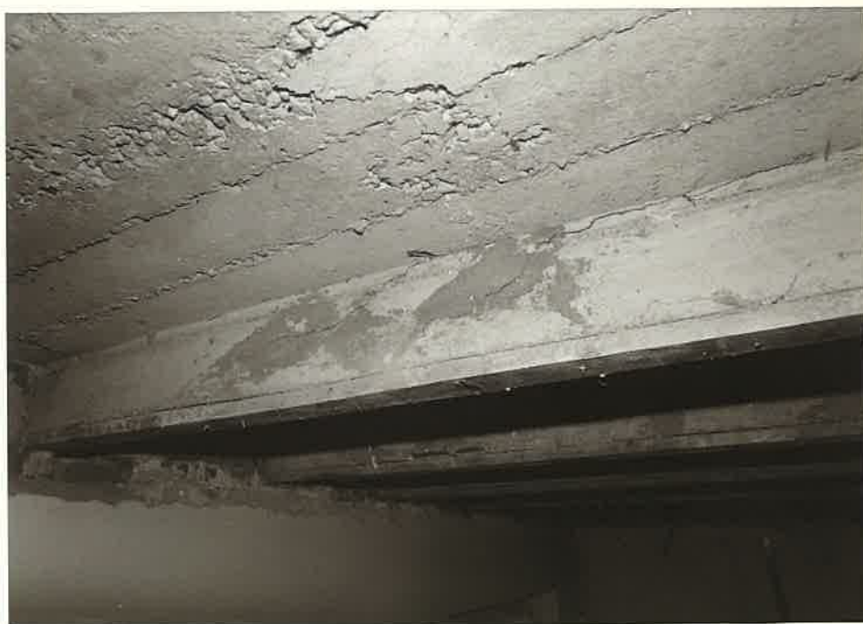
F.č. 7, 8 - Smykové trhliny na nosných ŽB žebrech.
