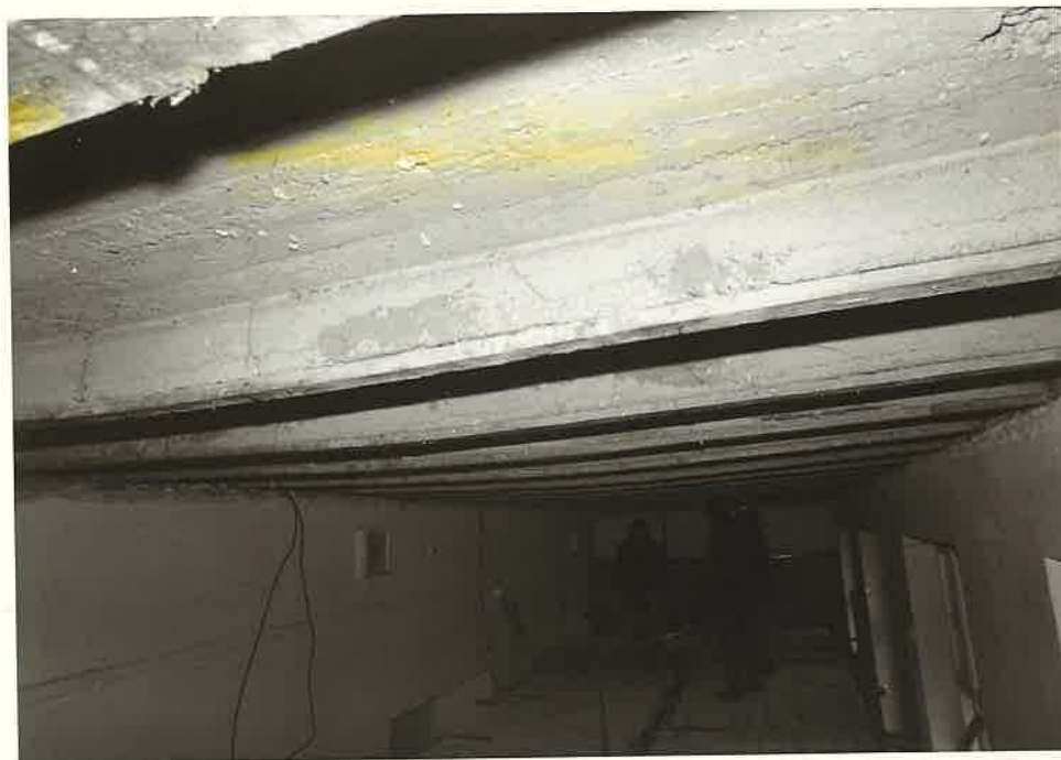
F.č. 3 - Výrazný průhyb stropní konstrukce nad kabinetem chemie.
