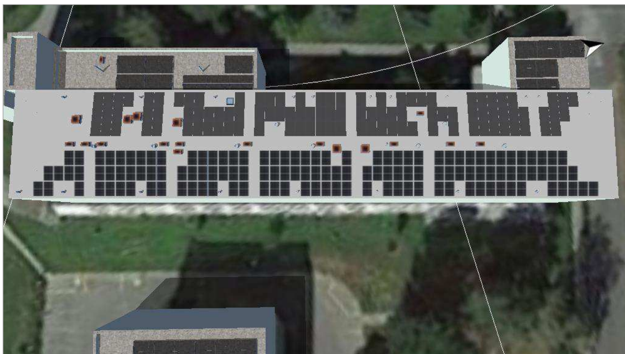
Obrázek: Umístění modulu - Budova P-1.1-Plocha střechy Východ
