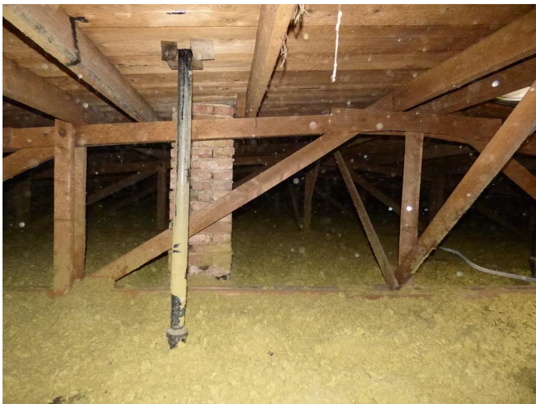
Foto 6: Částečný pohled na levou stranu vazníku v prvním úseku.
