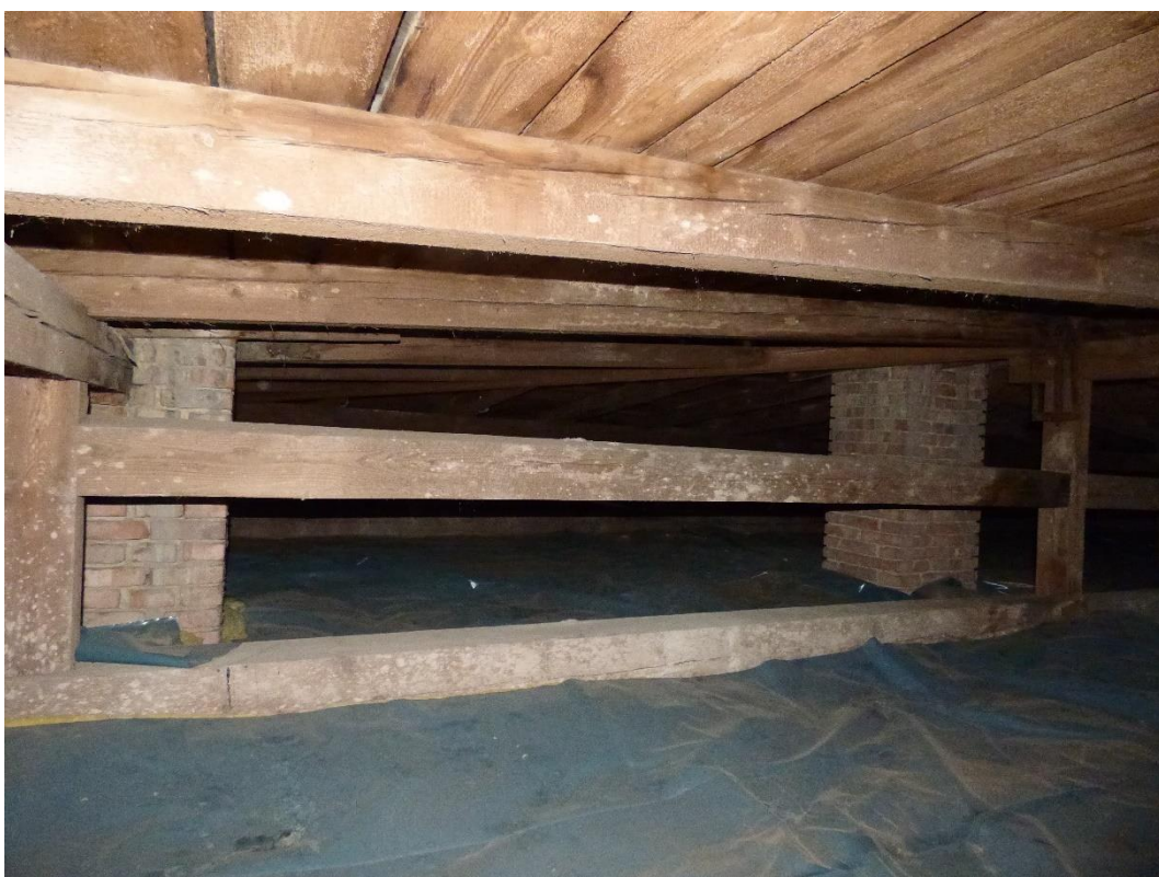
Foto 29: Pohled na levou stranu krovu.
