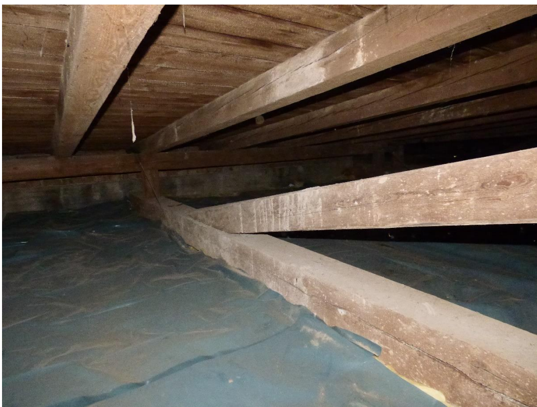
Foto 60 – druhý úsek: Pohled na levou stranu krovu.
