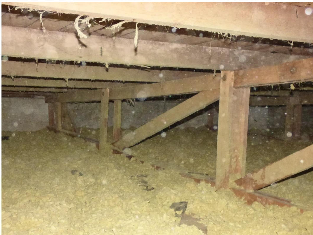
Foto 4: Částečný pohled na levou stranu vazníku v prvním úseku.
