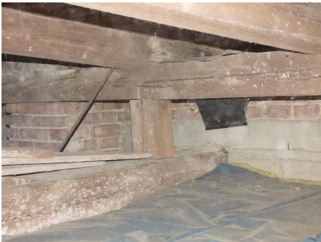
Foto 34: Pohled na pravou stranu krovu.
