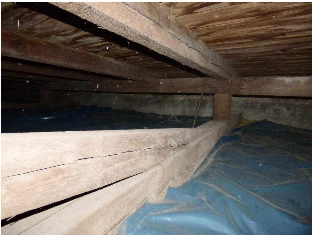
Foto 40: Částečný pohled na pravou stranu krovu.
