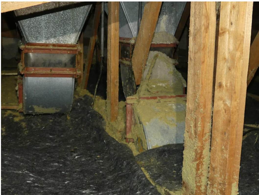
Foto 82 – porucha C: Detailní pohled na uříznutou diagonálu z předchozí fotky.
