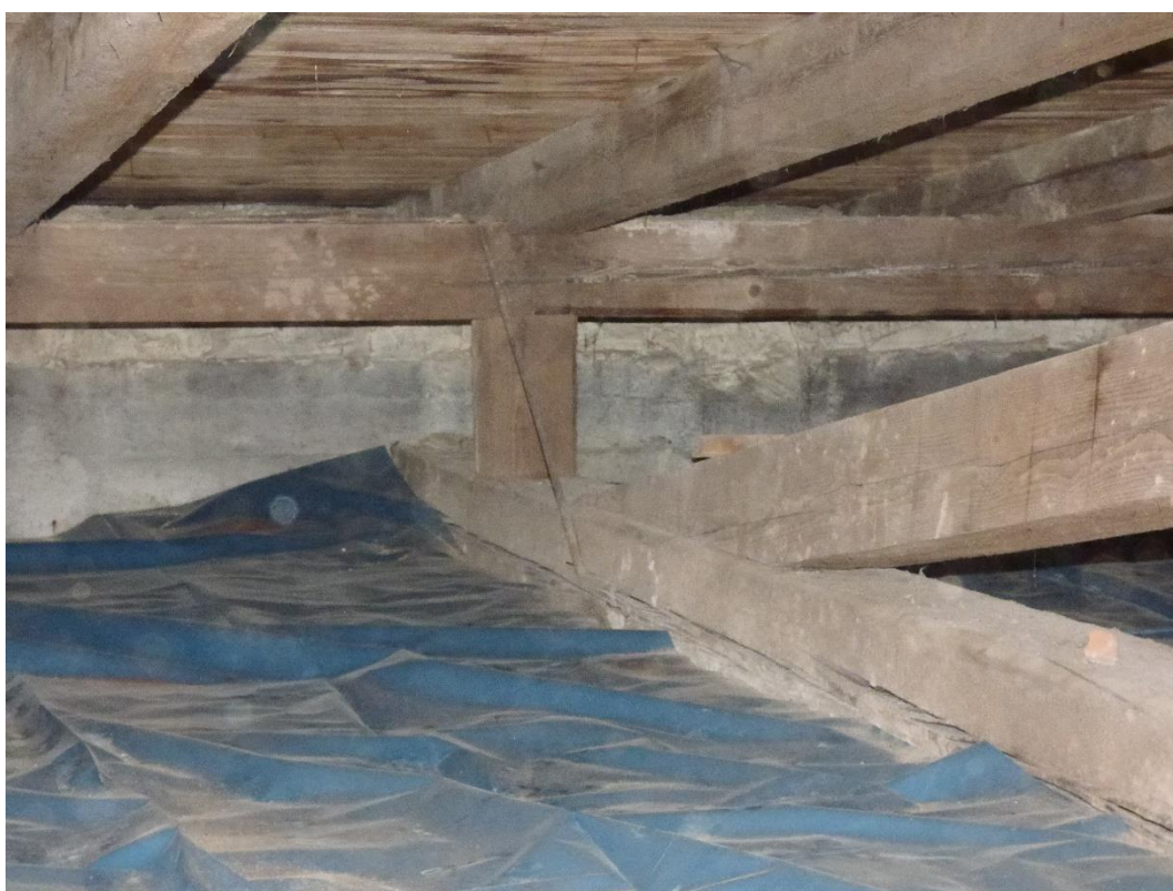
Foto 35: Částečný pohled na levou stranu krovu.
