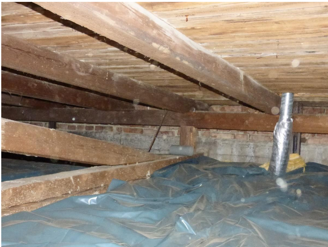
Foto 49 – první úsek: Pohled na pravou stranu krovu.
