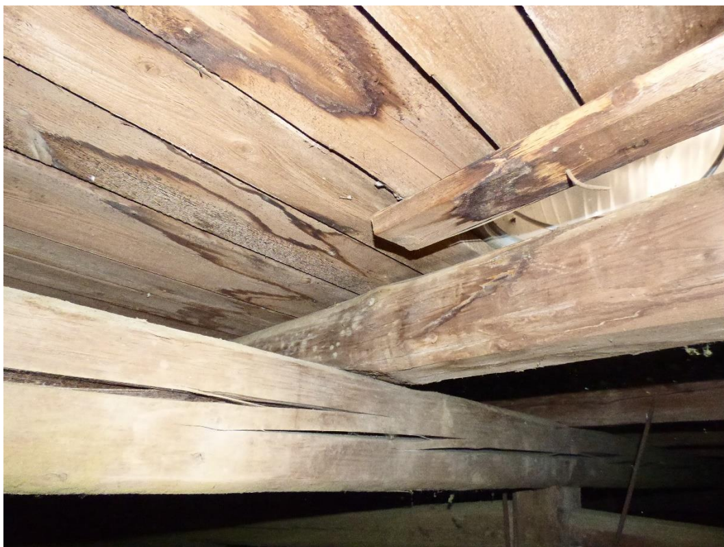
Foto 26 – porucha E: Historické stopy po zatečení.
