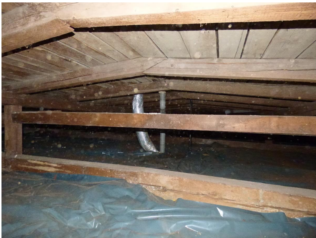
Foto 51 – první úsek: Pohled na hřeben střechy.
