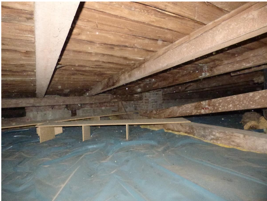
Foto 27: Pohled na levou stranu krovu.
