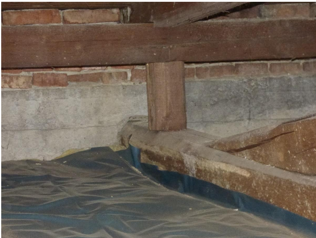
Foto 55 – první úsek: Pohled na levou stranu krovu.
