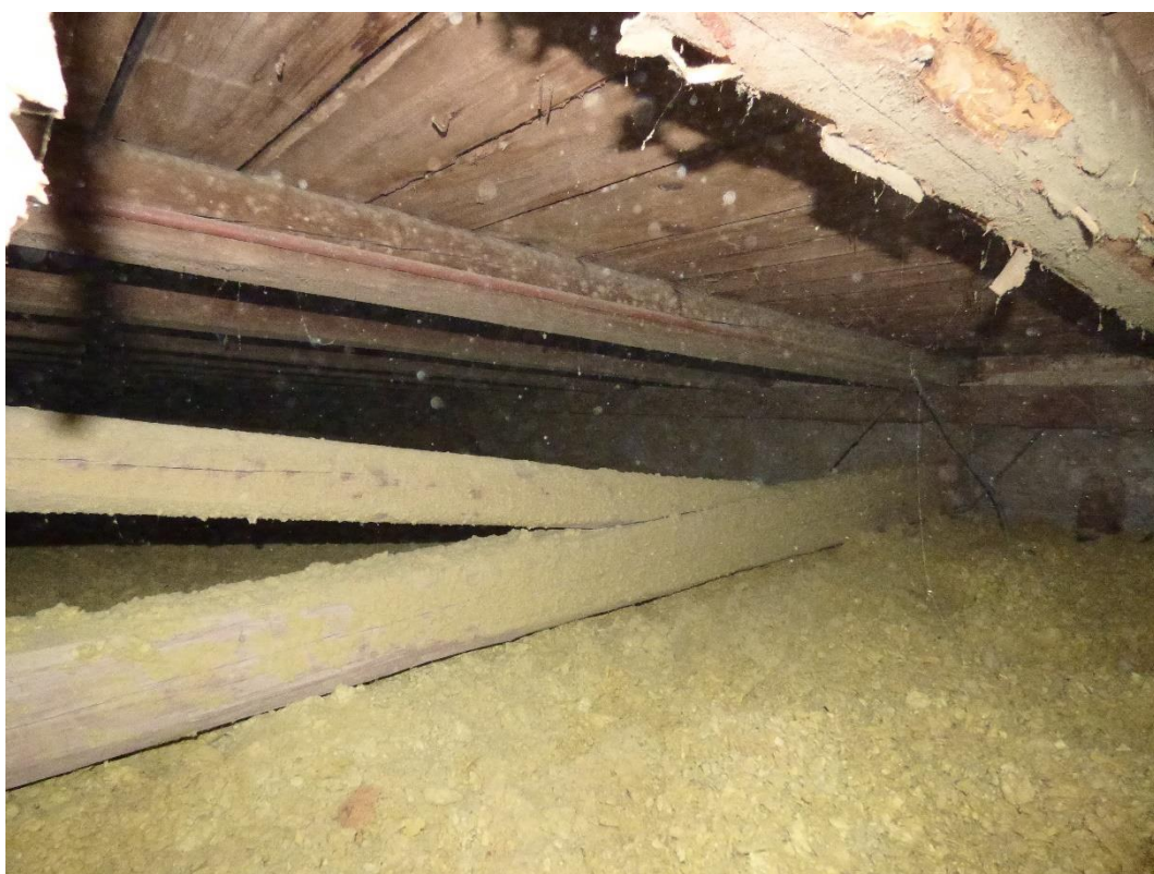
Foto 19: Částečný pohled na pravou stranu krovu.
