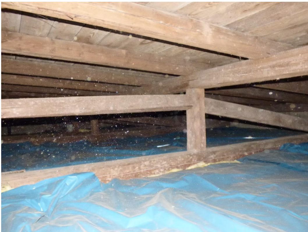
Foto 68: Pohled na pravou stranu krovu.
