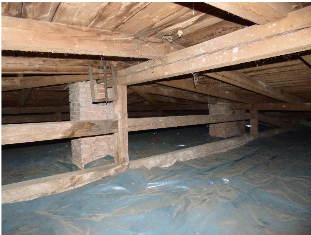
Foto 30: Pohled na hřeben střechy.
