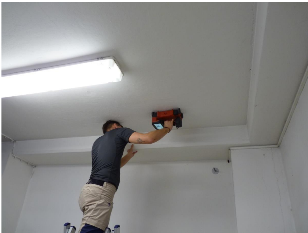
Foto 2: Průzkumné práce prováděné profometrem Hilti ve 4NP.
