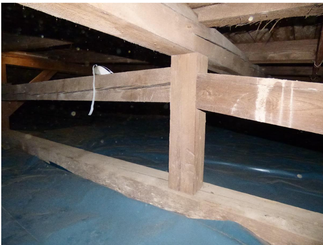
Foto 39: Částečný pohled na pravou stranu krovu.
