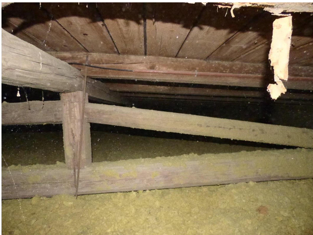
Foto 18: Částečný pohled na pravou stranu krovu.
