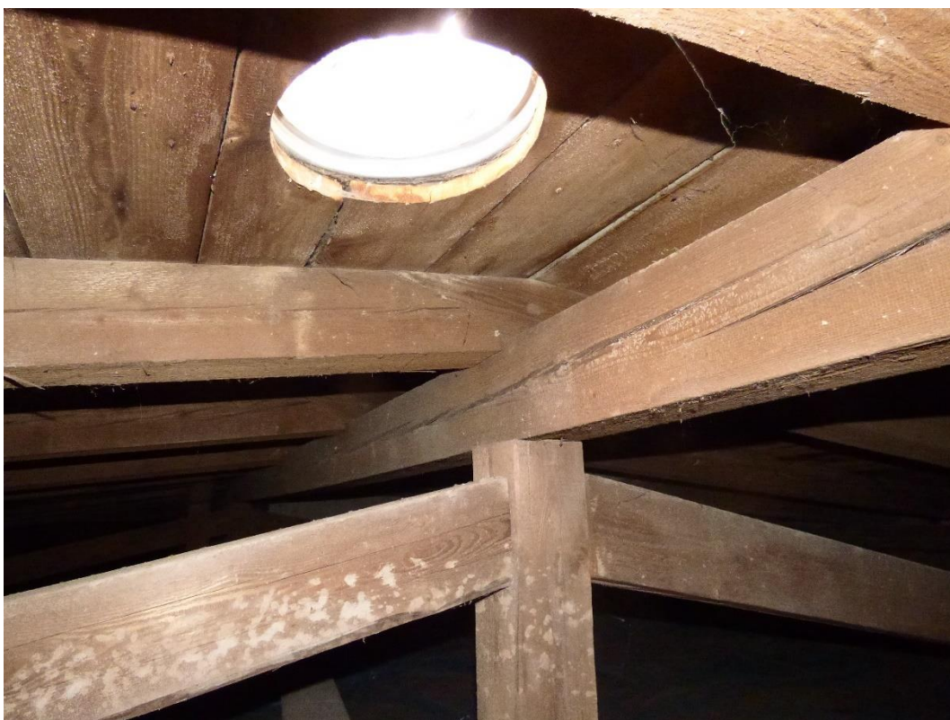
Foto 58 – druhý úsek: Pohled na vrcholovou vaznici.
