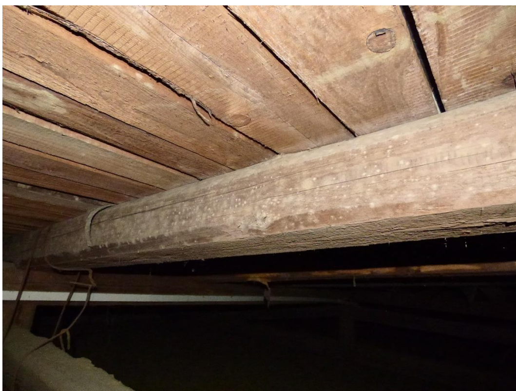
Foto 23 – porucha C: Plíseň na krokvi a bedně.
