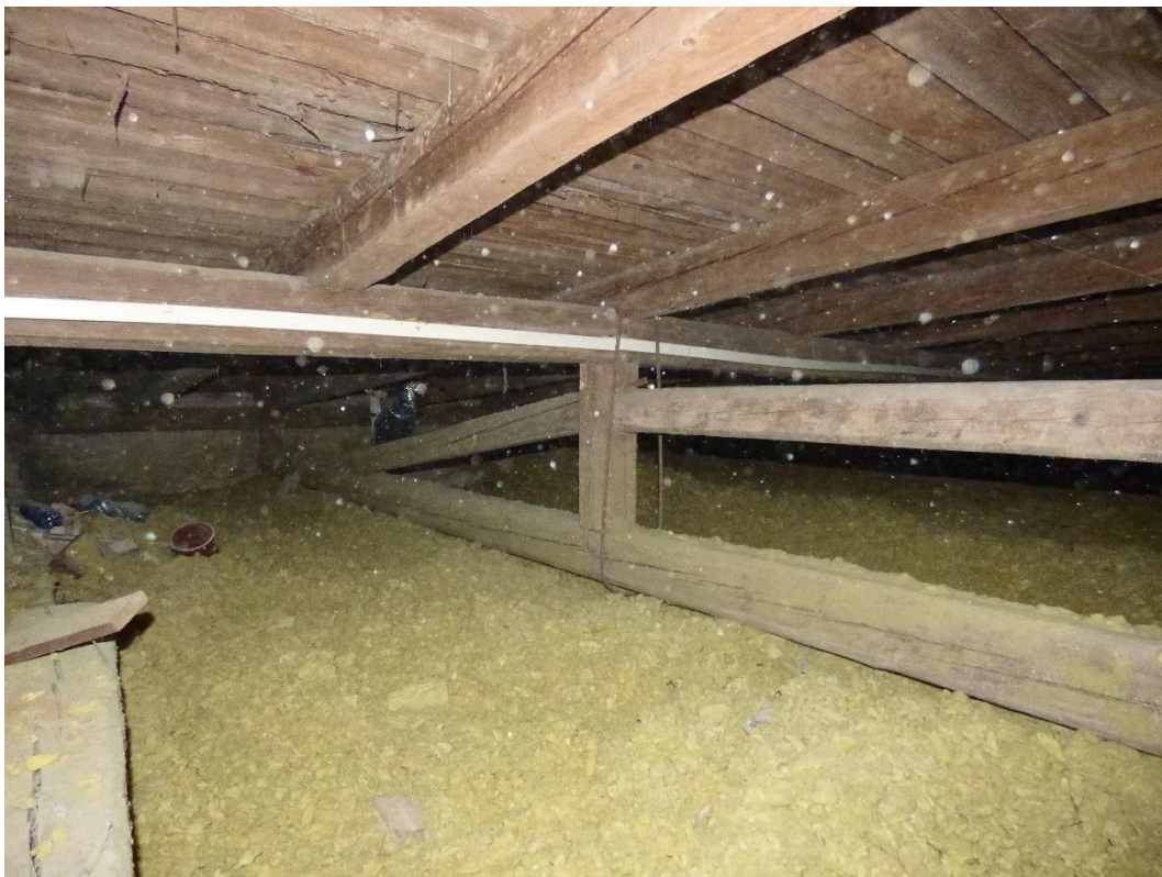
Foto 16: Částečný pohled na levou stranu krovu.
