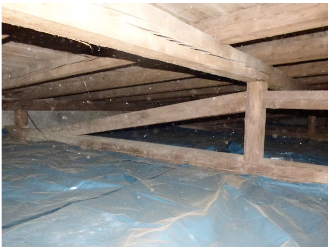
Foto 65: Pohled na levou stranu krovu.
