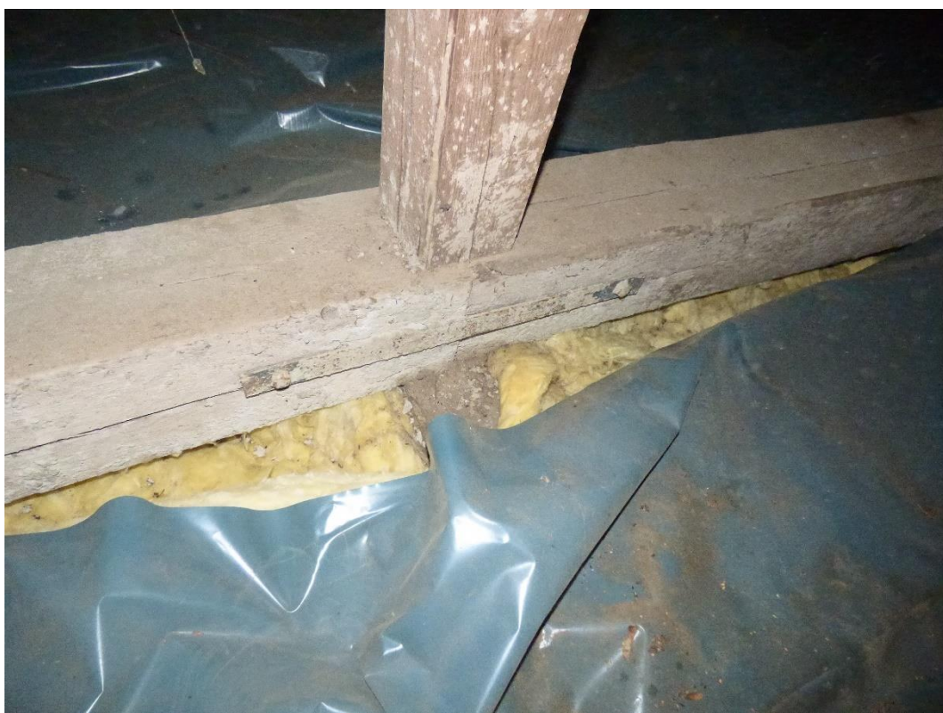
Foto 31: Pohled na spojení vazného trámu pod středovým sloupkem.
