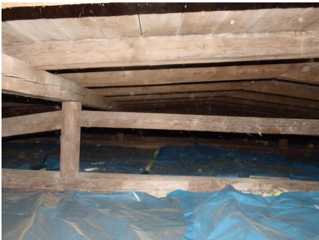
Foto 66: Pohled na levou stranu krovu.
