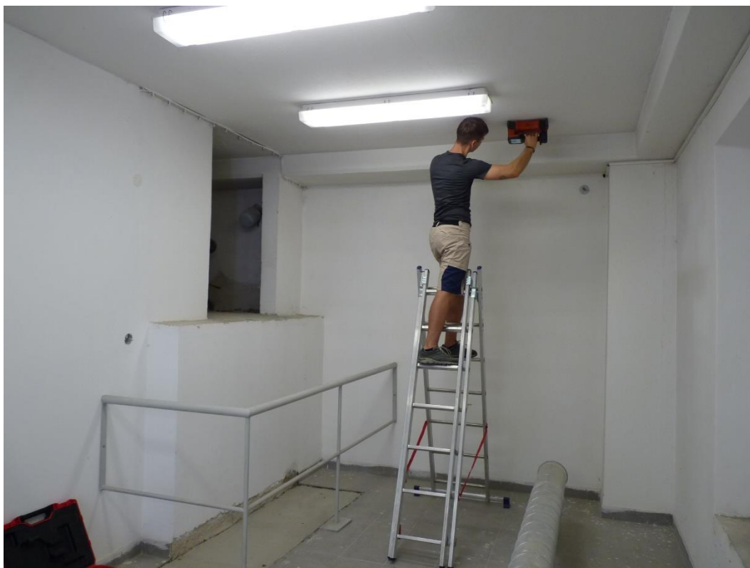
Foto 1: Průzkumné práce prováděné profometrem Hilti ve 4NP.
