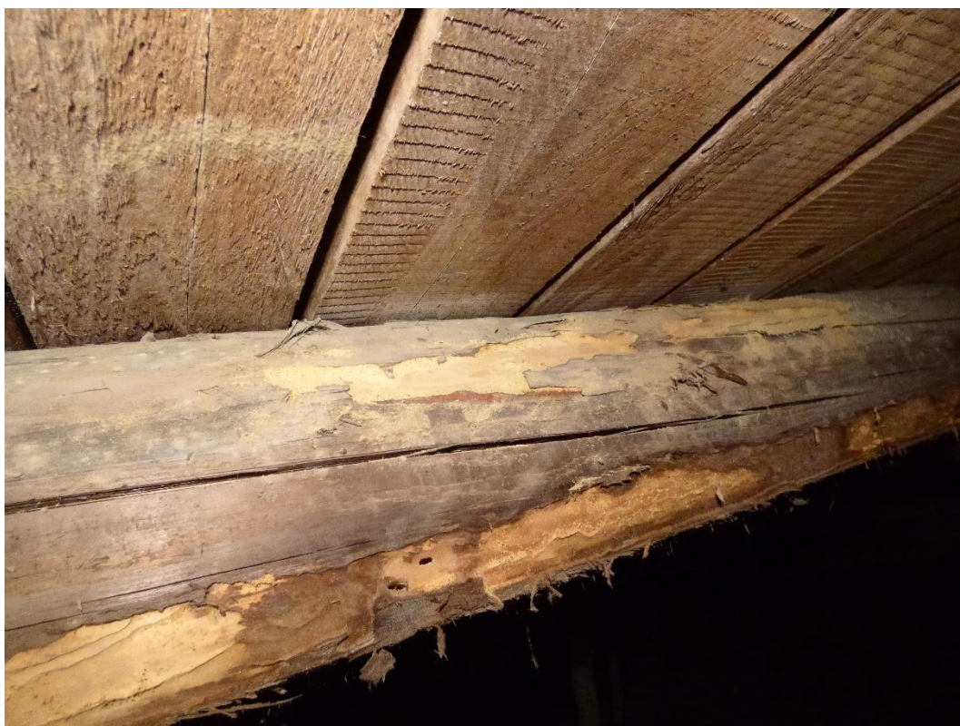
Foto 21 – porucha A: Stopy po dřevokazném hmyzu.
