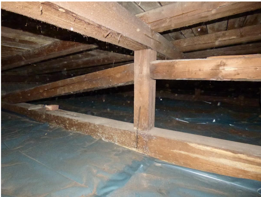
Foto 53 – první úsek: Pohled na levou stranu krovu.
