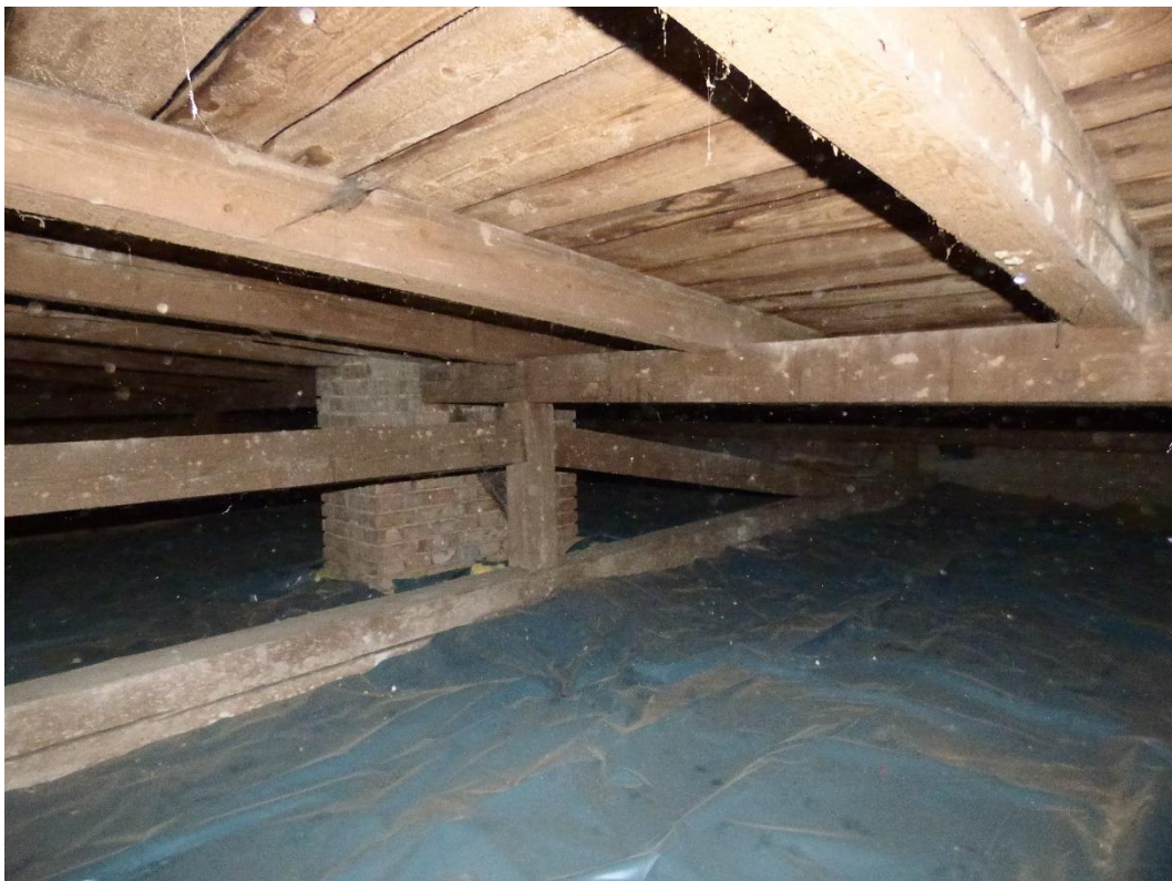
Foto 32: Pohled na pravou stranu krovu.
