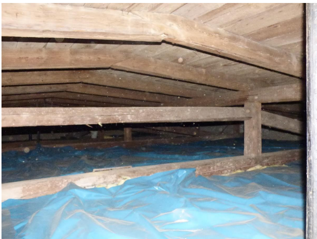
Foto 67: Pohled na hřeben krovu.
