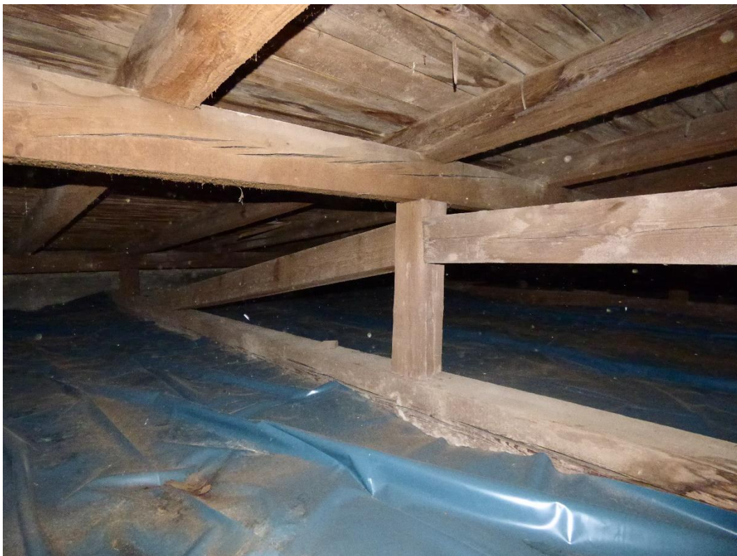
Foto 36: Částečný pohled na levou stranu krovu.
