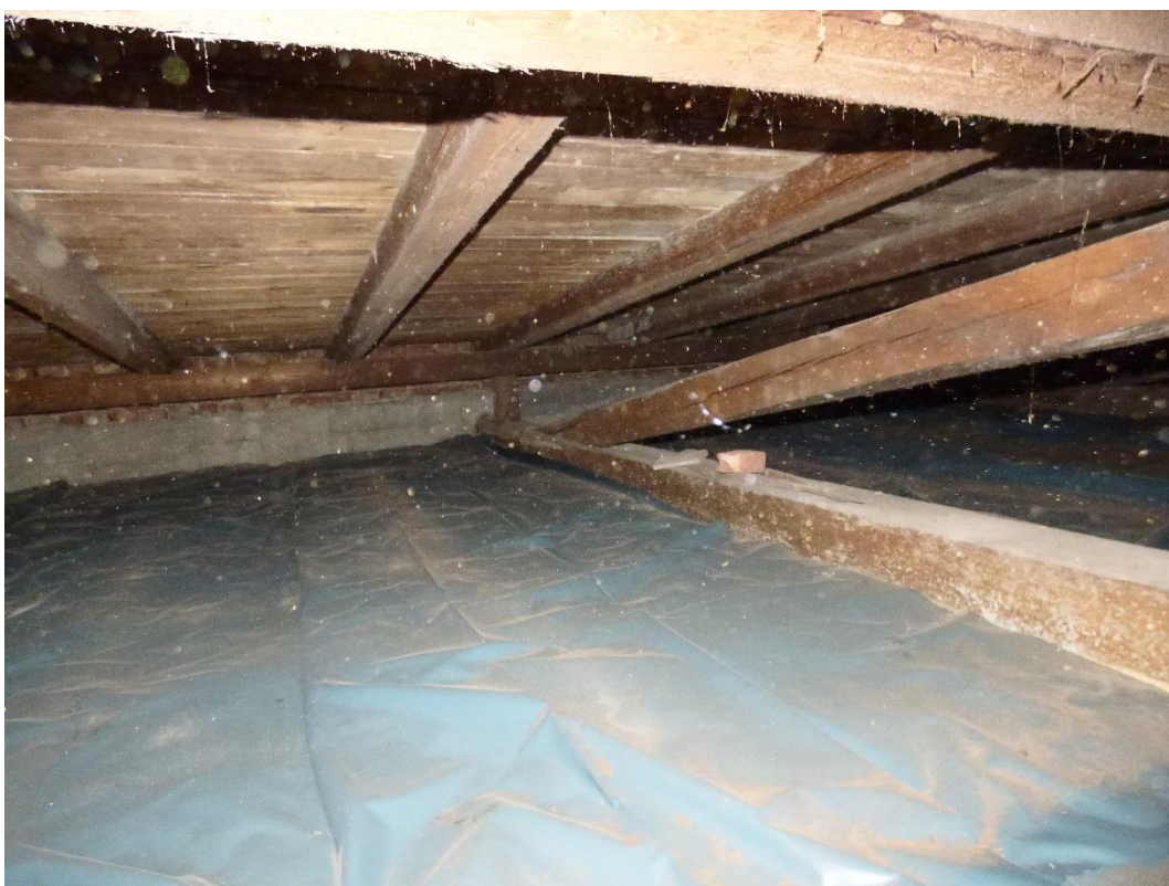
Foto 54 – první úsek: Pohled na levou stranu krovu.
