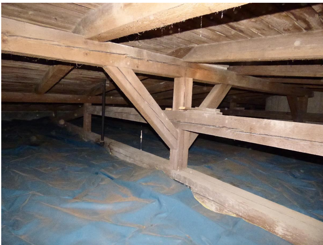
Foto 37: Částečný pohled na vrcholovou vaznici s napojením vazného trámu pod středovým sloupkem.
