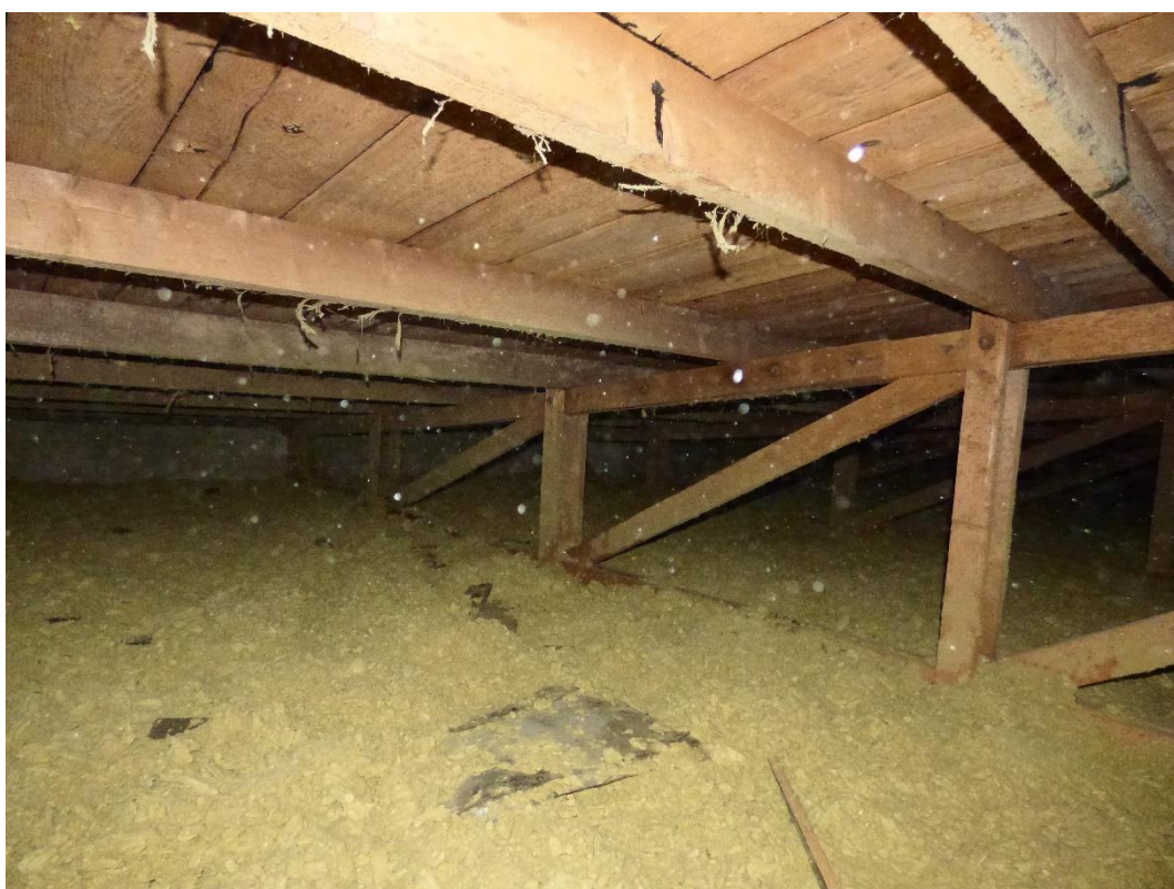
Foto 5: Částečný pohled na levou stranu vazníku v prvním úseku.
