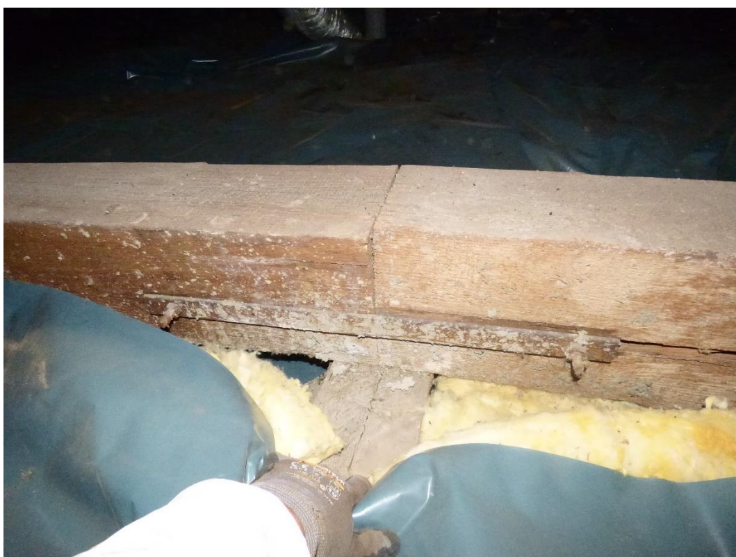
Foto 52 – první úsek: Pohled na spojení vazného trámu pod hřebenem střechy.
