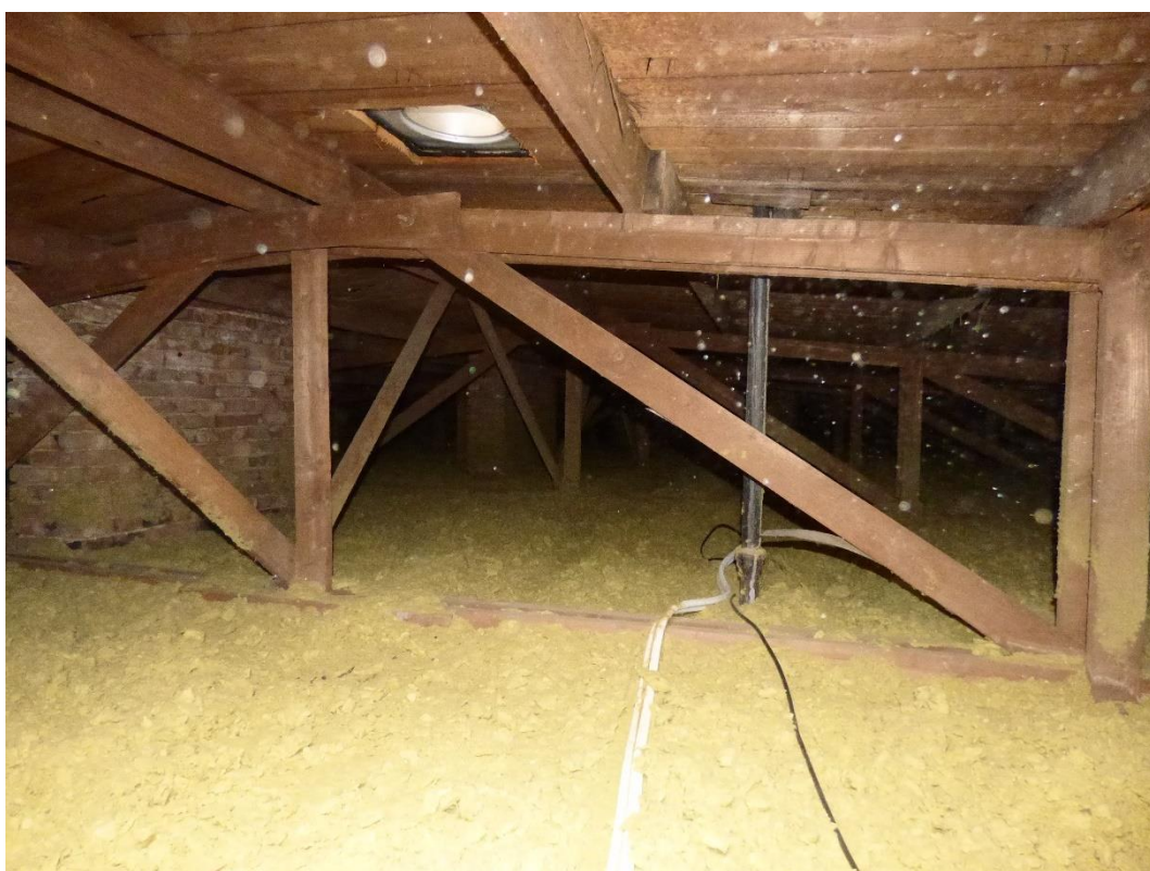
Foto 7: Částečný pohled na pravou stranu vazníku v prvním úseku.
