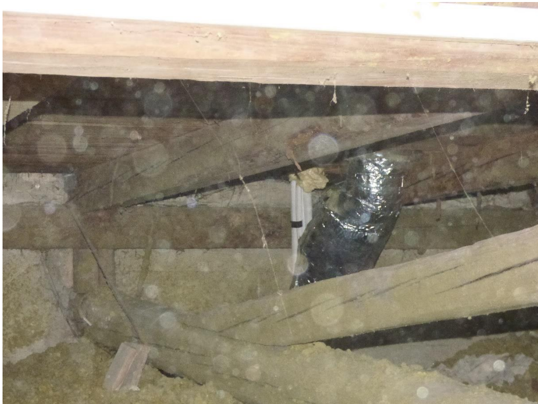
Foto 15: Částečný pohled na levou stranu krovu.
