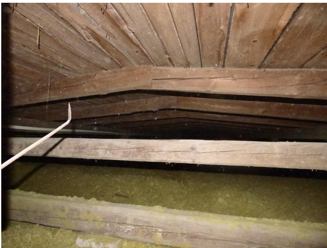
Foto 17: Částečný pohled na hřeben krovu.
