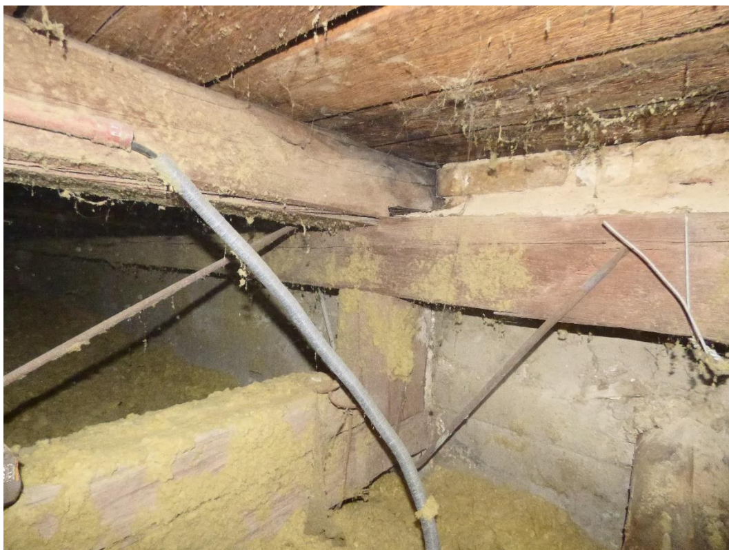
Foto 20: Částečný pohled na pravou stranu krovu.
