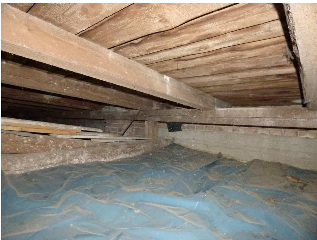
Foto 33: Pohled na pravou stranu krovu.
