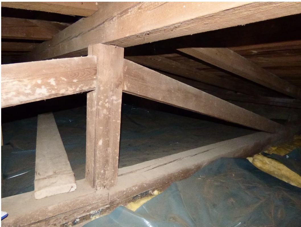
Foto 57 – druhý úsek: Pohled na krov v hřebeni.
