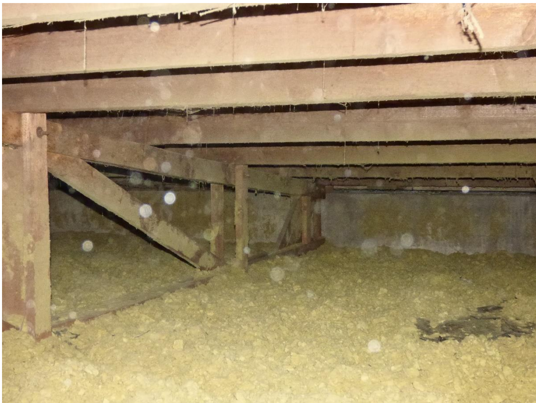
Foto 10: Částečný pohled na pravou stranu vazníku v prvním úseku.
