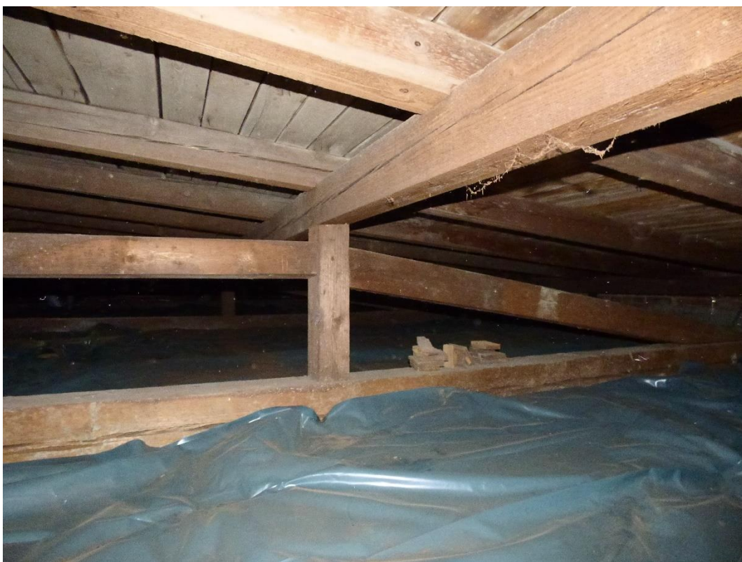
Foto 50 – první úsek: Pohled na pravou stranu krovu.
