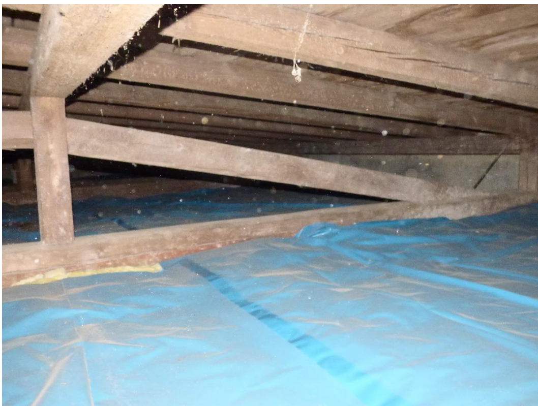
Foto 69: Pohled na pravou stranu krovu.
