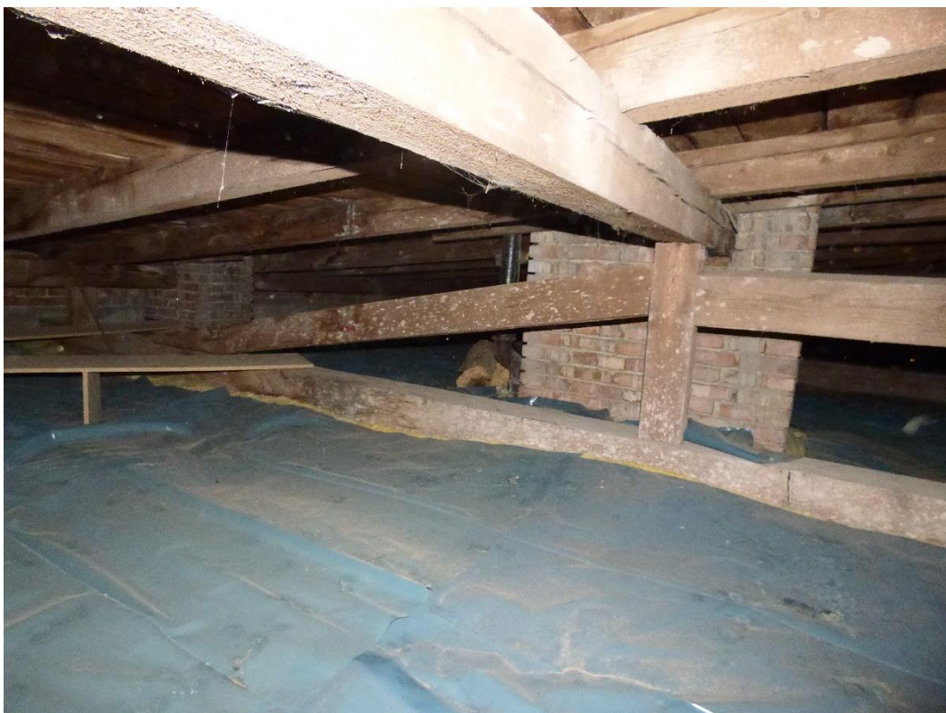
Foto 28: Pohled na levou stranu krovu.
