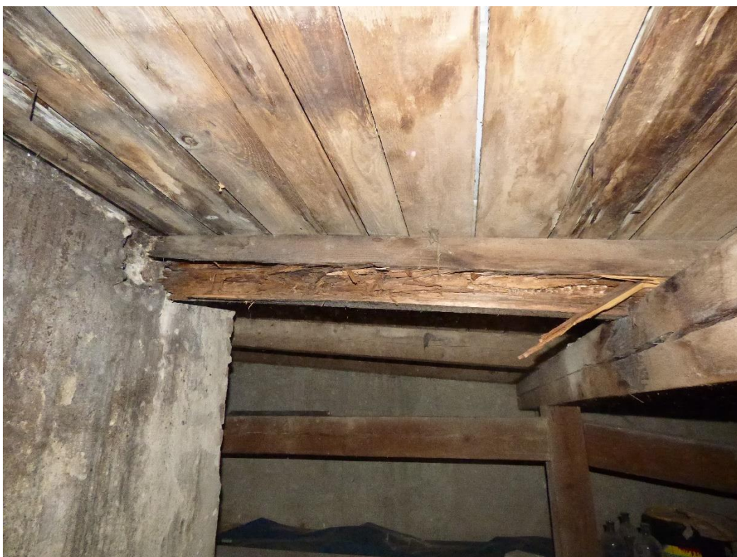
Foto 45 – porucha B: Pohled na shnilou krokev, kdy hniloba pokračuje doprava za středovou vaznici cca v délce 1 m.
