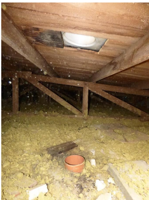
Foto 13 – porucha B: Pohled na odvětrání vyvedené do podstřešního prostoru.
