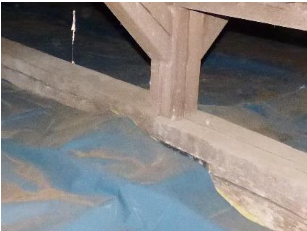
Foto 38: Detail spoje vazného trámu z předchozí fotky.
