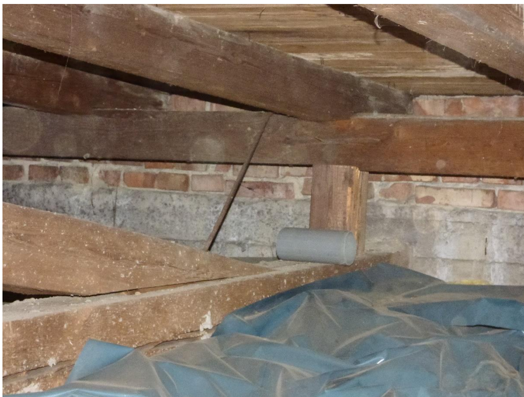
Foto 48 – první úsek: Pohled na pravou stranu krovu.
