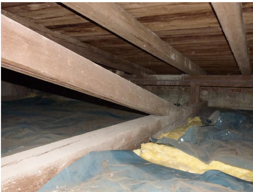
Foto 56 – druhý úsek: Pohled na pravou stranu krovu.
