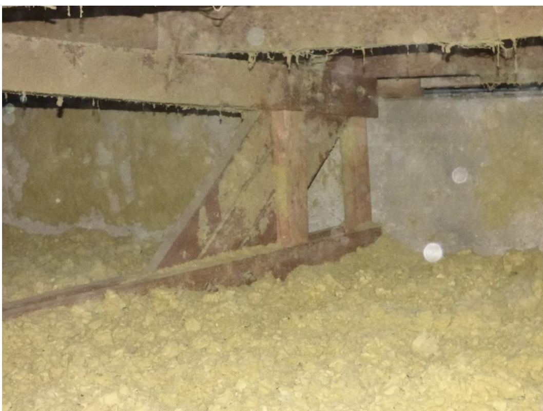
Foto 11: Částečný pohled na pravou stranu vazníku v prvním úseku.
