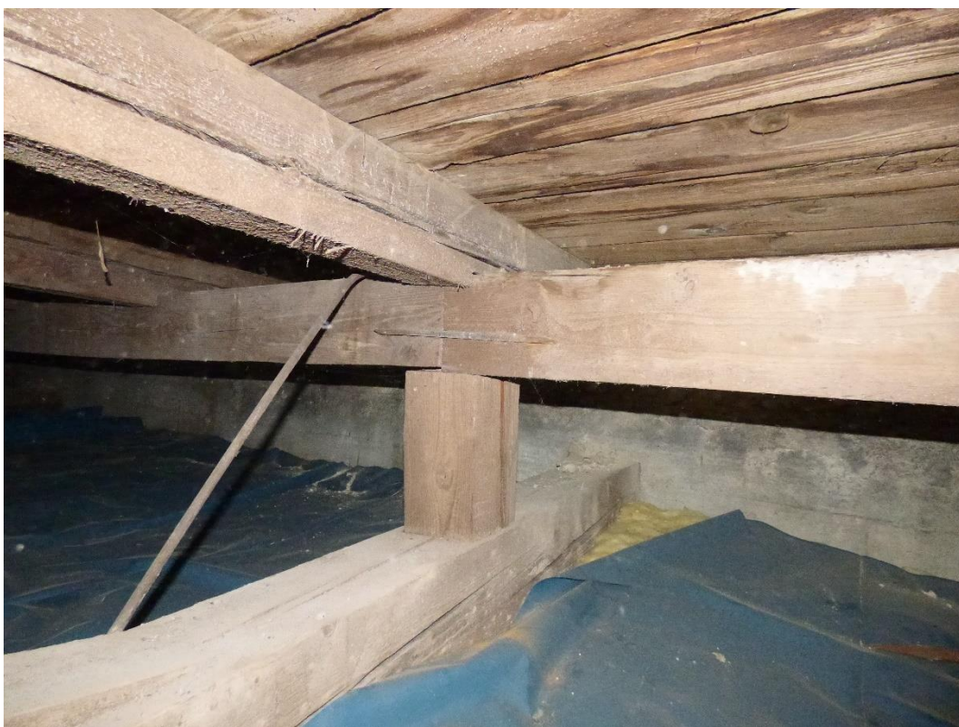
Foto 41: Částečný pohled na pravou stranu krovu.
