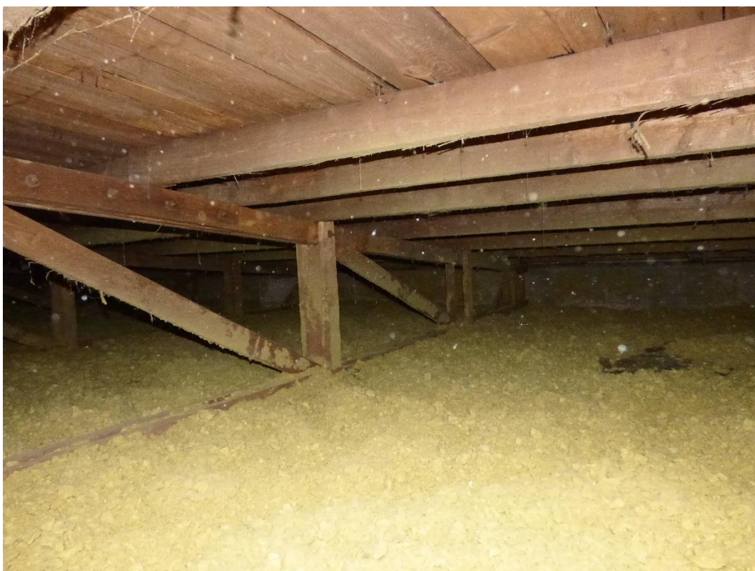
Foto 9: Částečný pohled na pravou stranu vazníku v prvním úseku.
