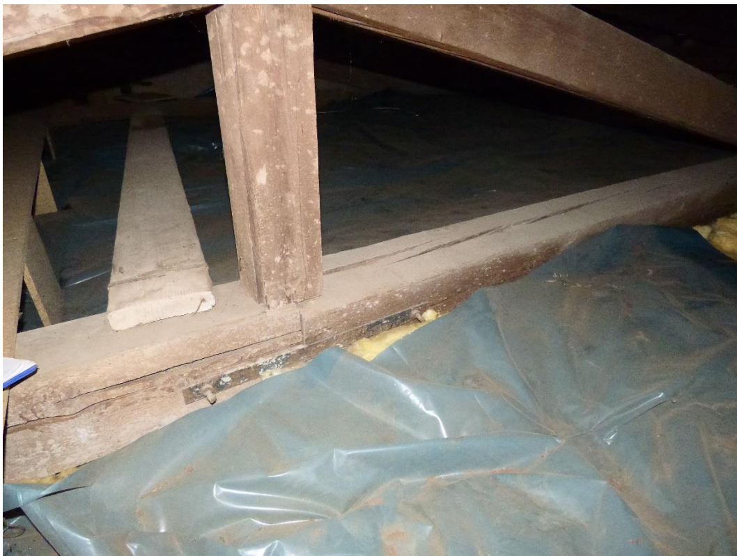
Foto 59 – druhý úsek: Pohled na spojení vazného trámu pod hřebenem střechy.
