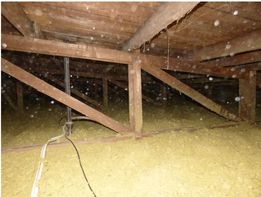
Foto 8: Částečný pohled na pravou stranu vazníku v prvním úseku.
