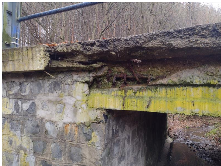
Rozpad betonu římsy a NK na pravé straně u OP1
