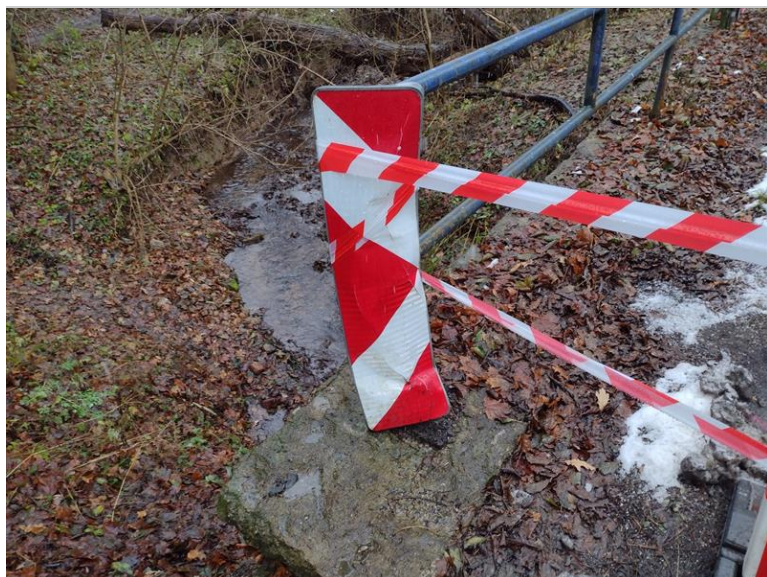
Poškození značky Z4 po nárazu vozidla - levá strana u OP1
