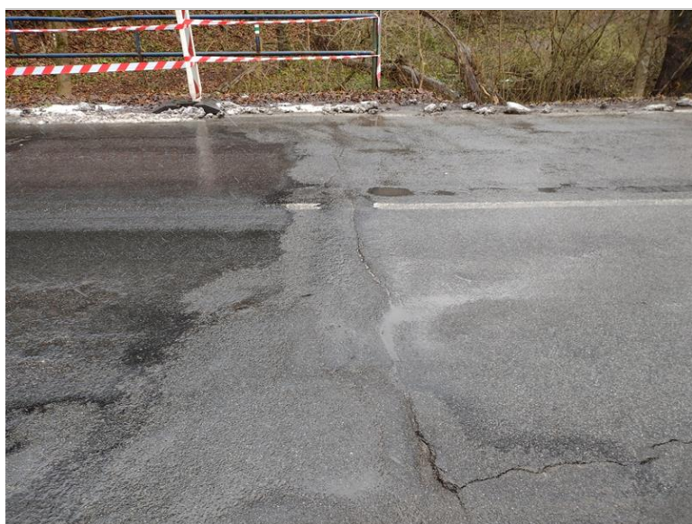
Trhliny ve vozovce v místě dilatace u OP2
