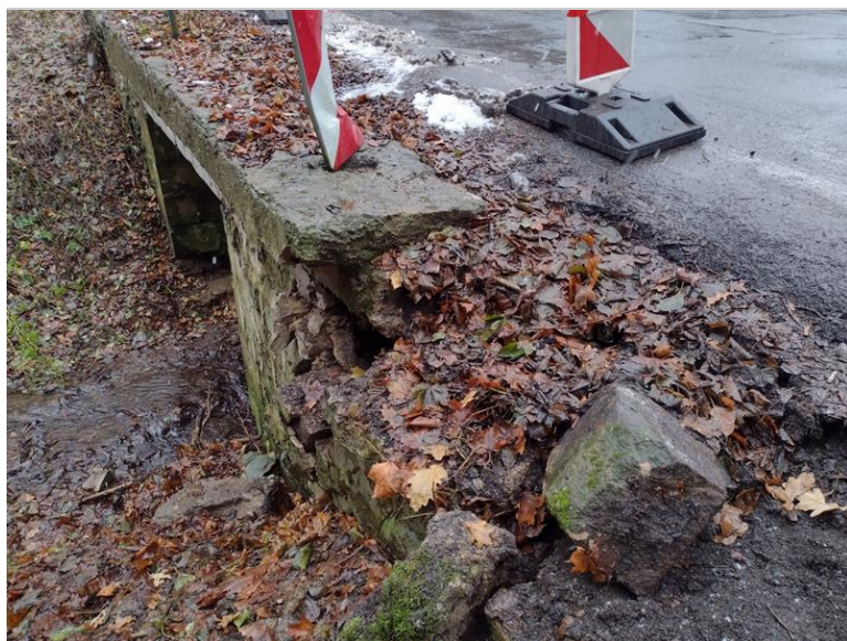
Levé křídlo OP1 - patrné stopy po nárazu vozidla a deformace křídla
