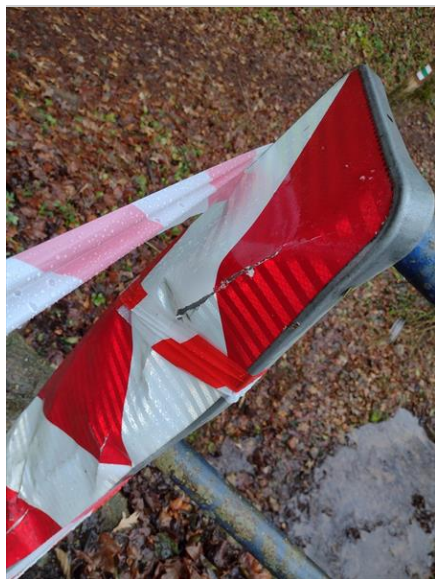
Poškození značky Z4 po nárazu vozidla - levá strana u OP1
