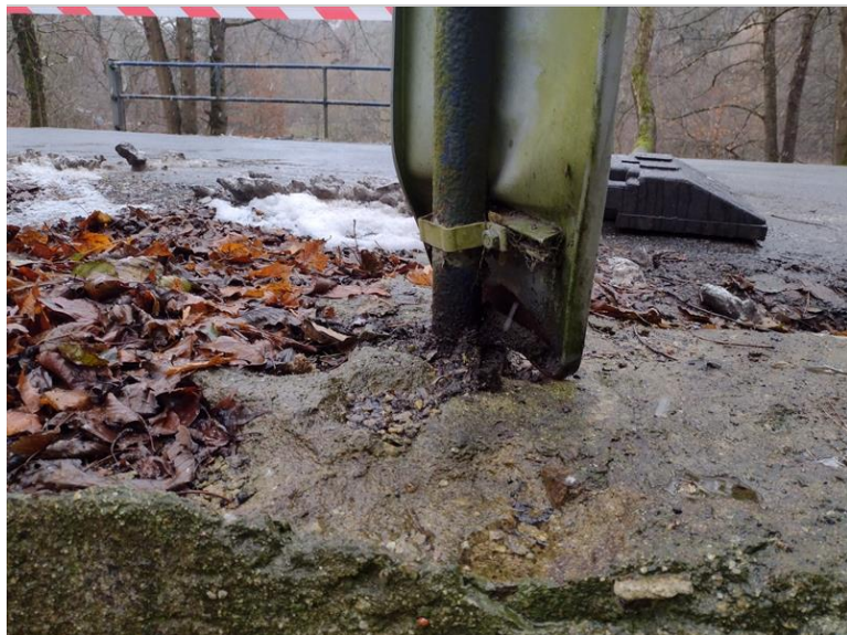
Kotvení sloupku zábradlí na levém křídle OP1
