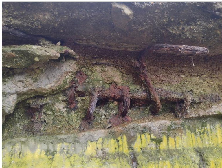
Rozpad betonu řimsy a NK na pravé straně u OP1 - silná korozí výztuže
