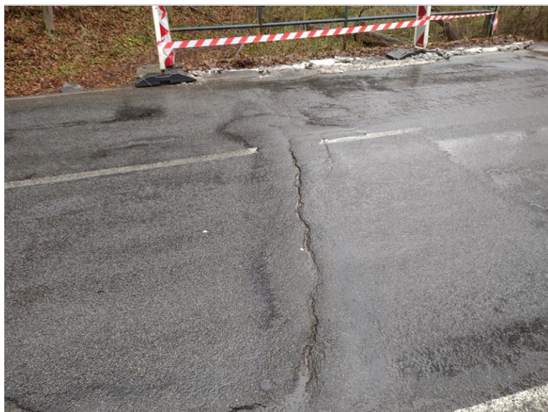
Trhliny ve vozovce v místě dilatace u OP1
