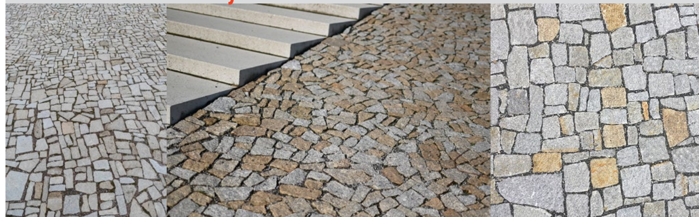
Kamenná dlažba z žulových odseků
