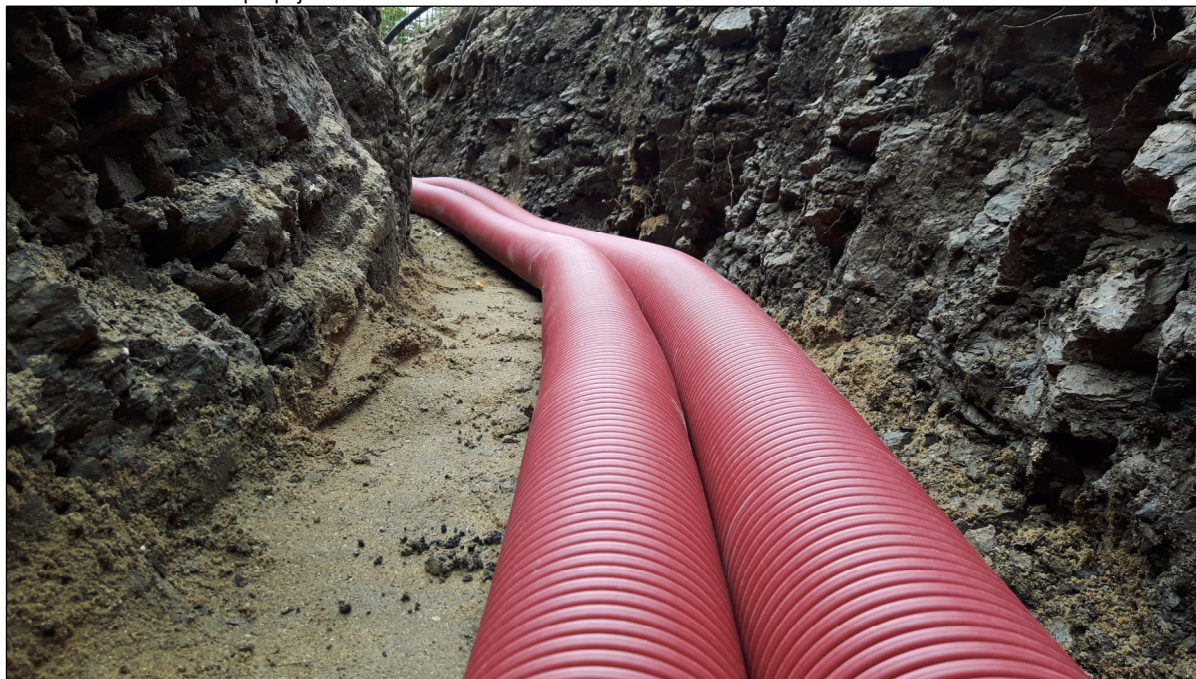
Obrázek č. 4 - Izolované propojení vrtů
