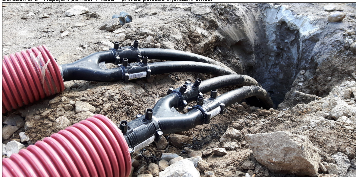
Obrázek č. 3 - Napojení pomocí Y-kusů + příklad poklesu injektážní směsi
