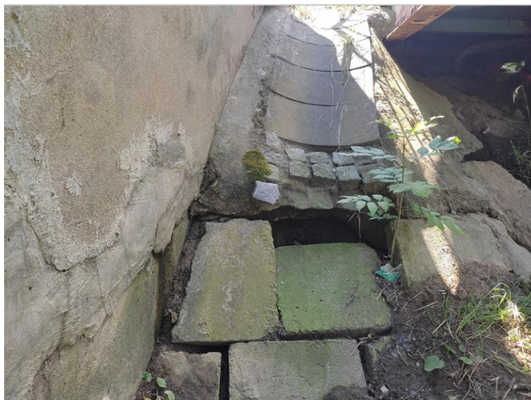
Opevnění skluzu u levého křídla OP1
