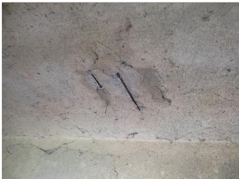
Nedostatečně krytí výztuže na podhledu NK
