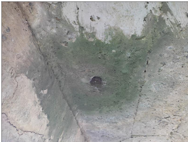
Stopy po zatékání na podhledu NK na pravé straně
