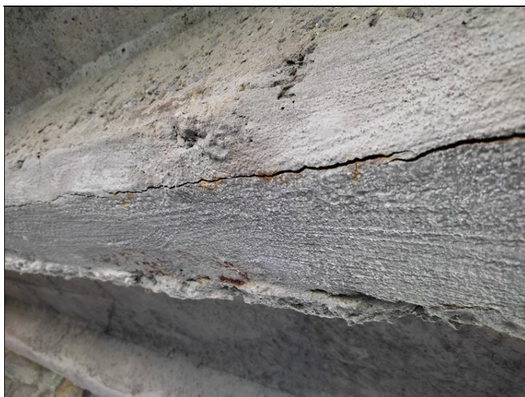
Trhliny v sanaci na pátém trámu zleva
