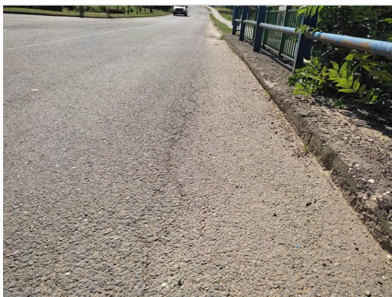
Propad vozovky u levé římsy
