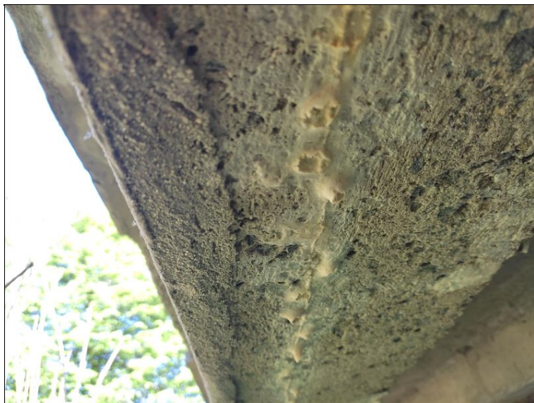
Stopy po zatékání na podhled NK na pravé straně
