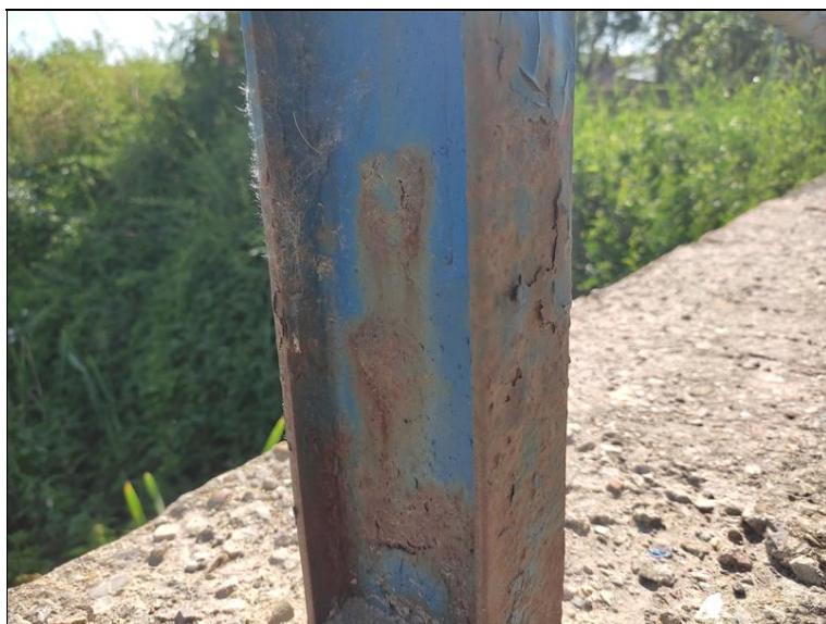
Koroze zábradlí
