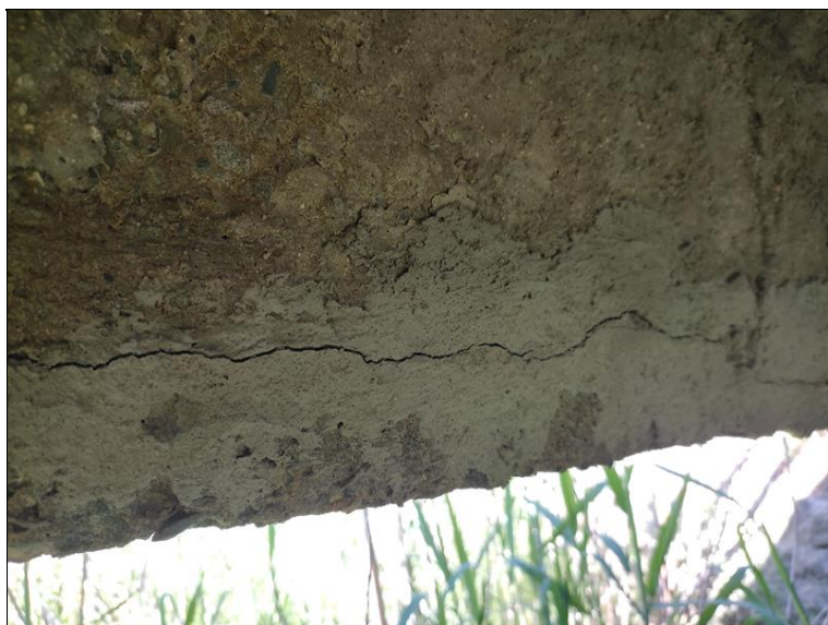
Trhy na spodním líci pravého trámu v sanaci
