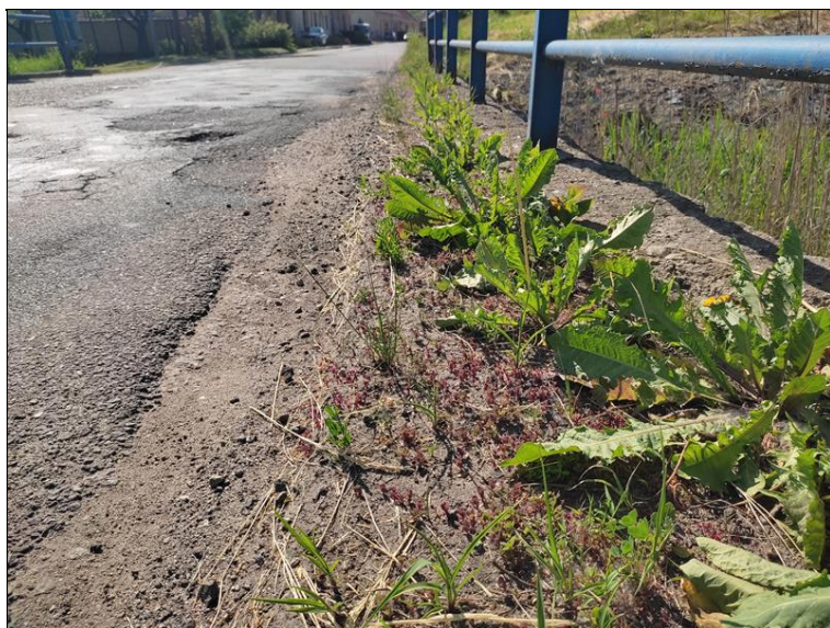
Uchycená vegetace ve spáře mezi vozovkou a římsou
