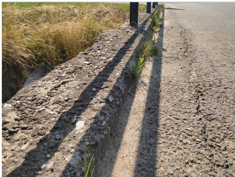
Uchycení vegetace ve spáře mezi vozovkou a římsou
