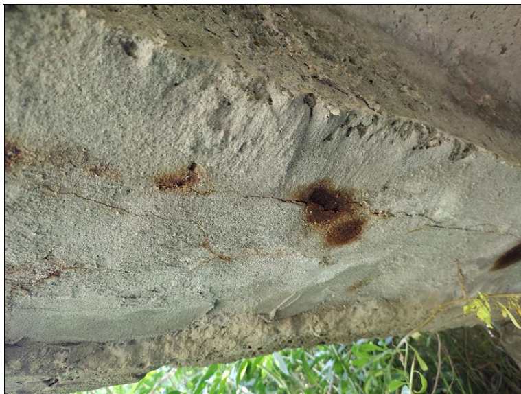
Prokopírovaná výztuž na podhledu krajního levého trámu
