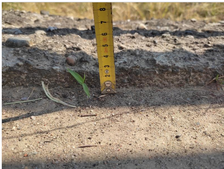
Výška římsy nad vozovkou
