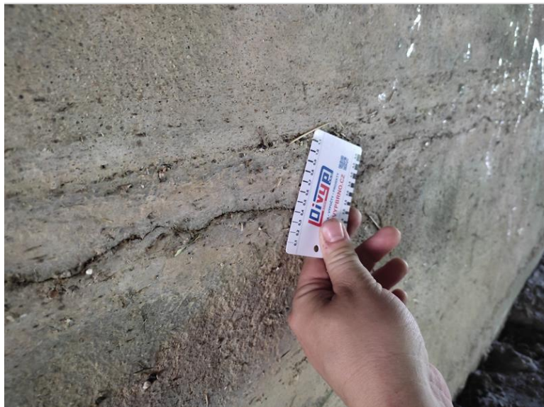
Vodorovná trhlina v polovině výšky opěry OP1
