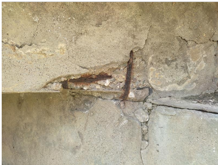
Stav uložení pravého krajního nosníku nad OP2
