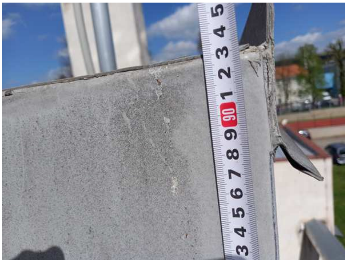
Fotografie 4 – Pořízena autorem zprávy – Výška atiky v měřeno u okapu.
