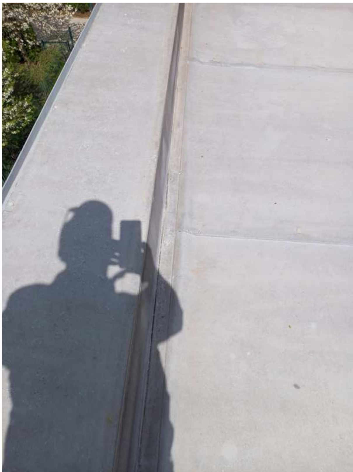
Fotografie 5 – Pořízena autorem zprávy – Posunutá koutová lišta v hraně pultu.
