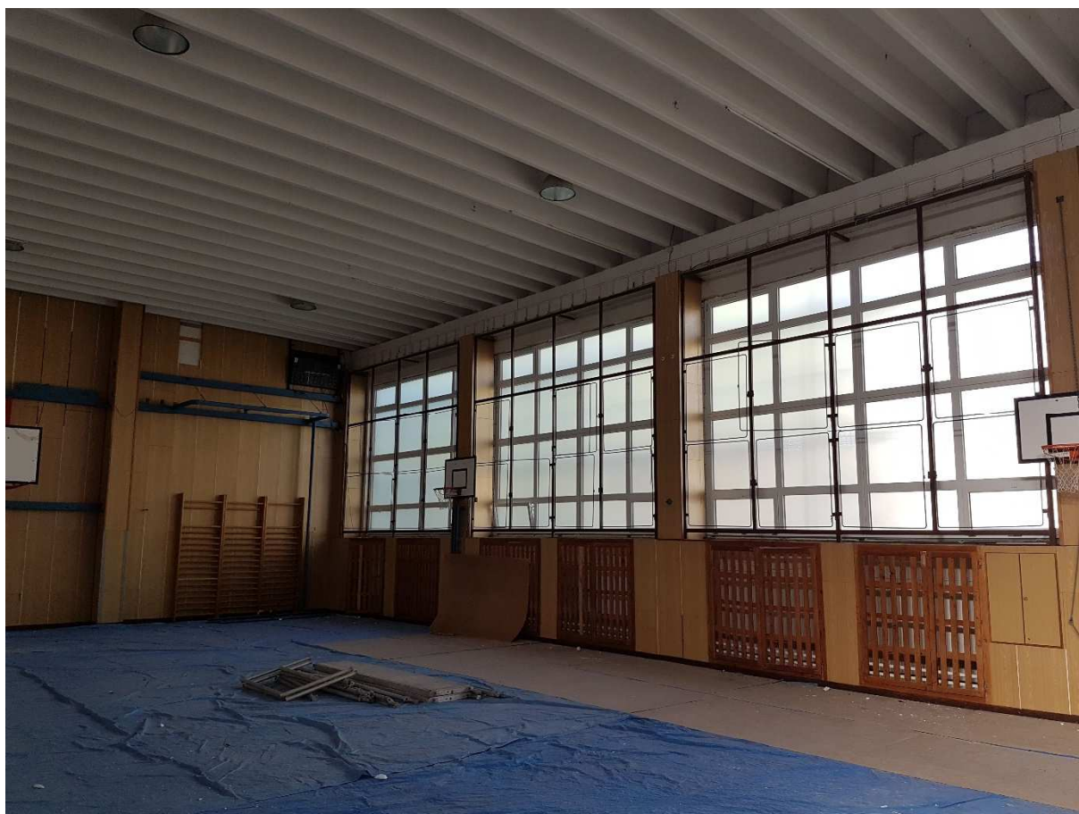
Fotografie 18 – Poskytnuto objednatelem zprávy – Pořízeno při dříve prováděné rekonstrukci. Další fotografie interiéru.
