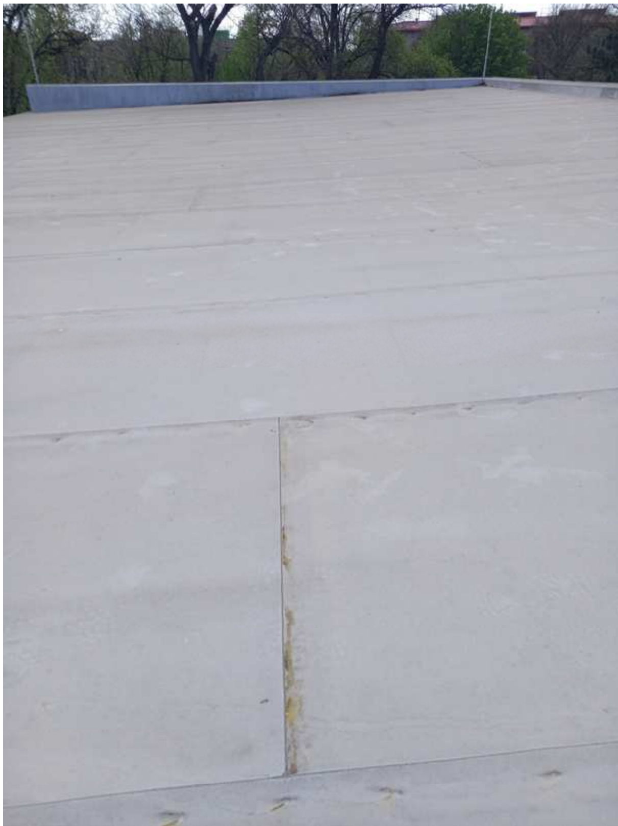
Fotografie 10 – Pořízena autorem zprávy – Pohled na řešenou střechu.
