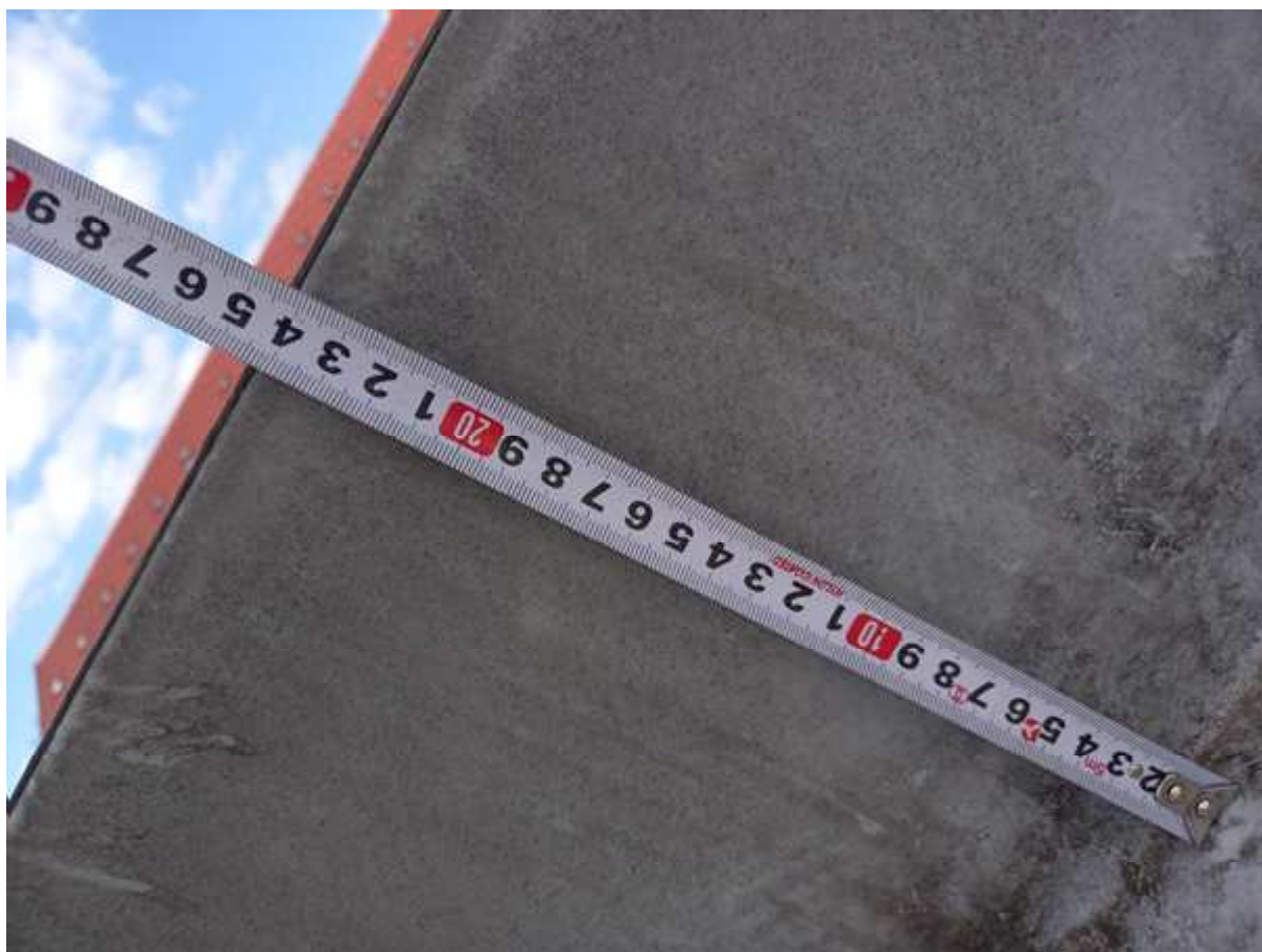
Fotografie 3 – Pořízena autorem zprávy – Výška atiky v nejvyšším místě střechy.
