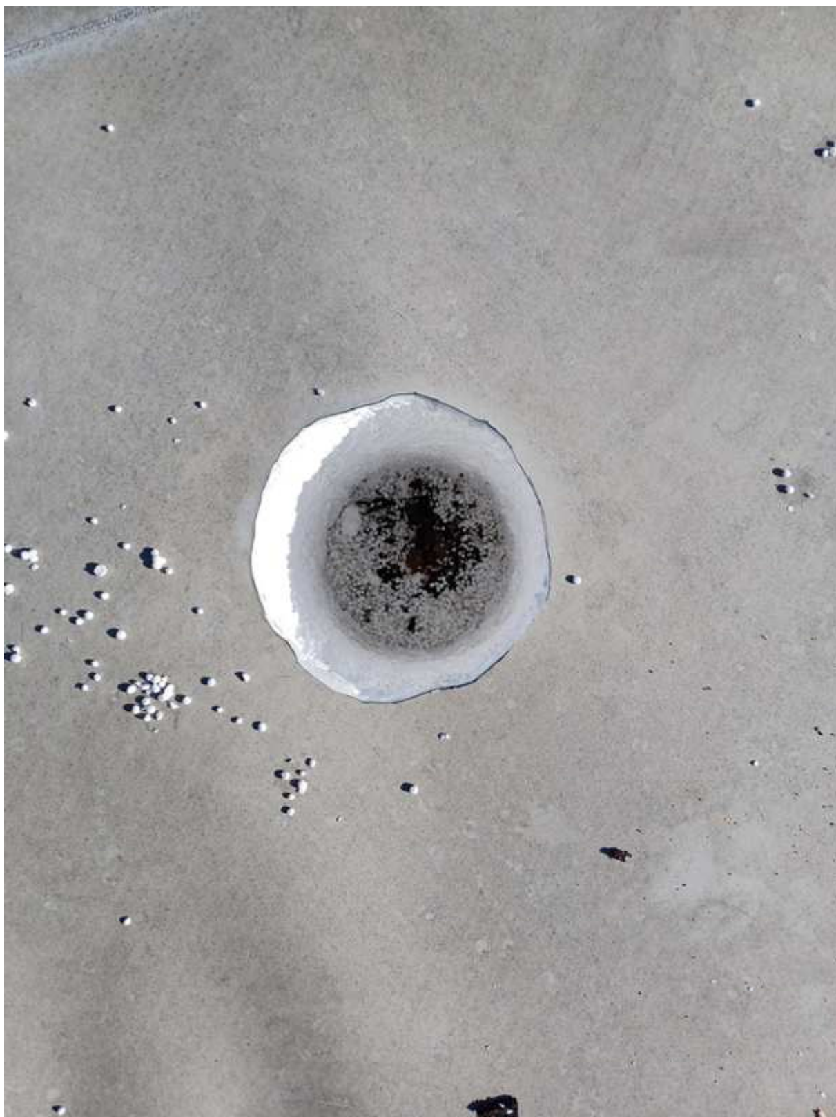
Fotografie 22 – Poskytnuto objednatelem zprávy – Pohled do sondy střechy.
