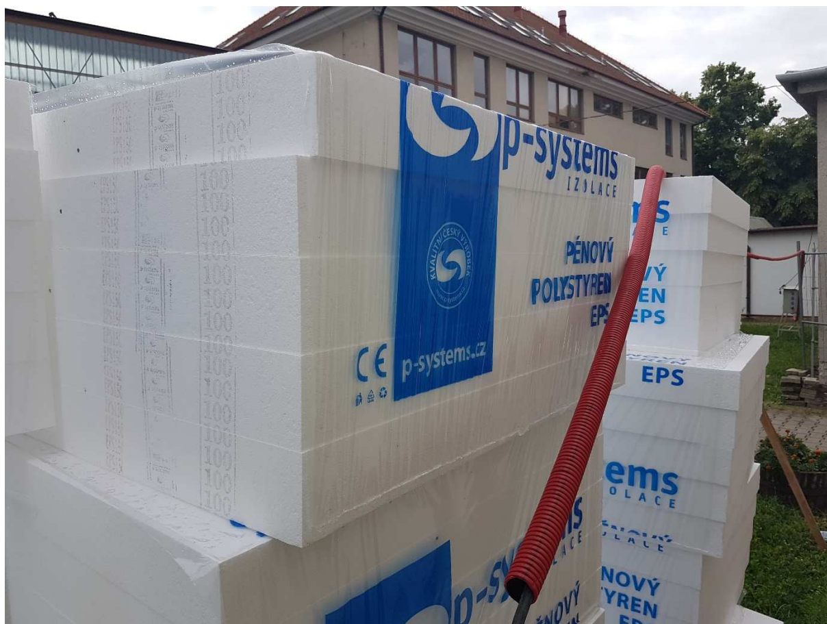
Fotografie 14 – Poskytnuto objednatelem zprávy – Pořízeno při dříve prováděné rekonstrukci. Použitý polystyren EPS 150.
