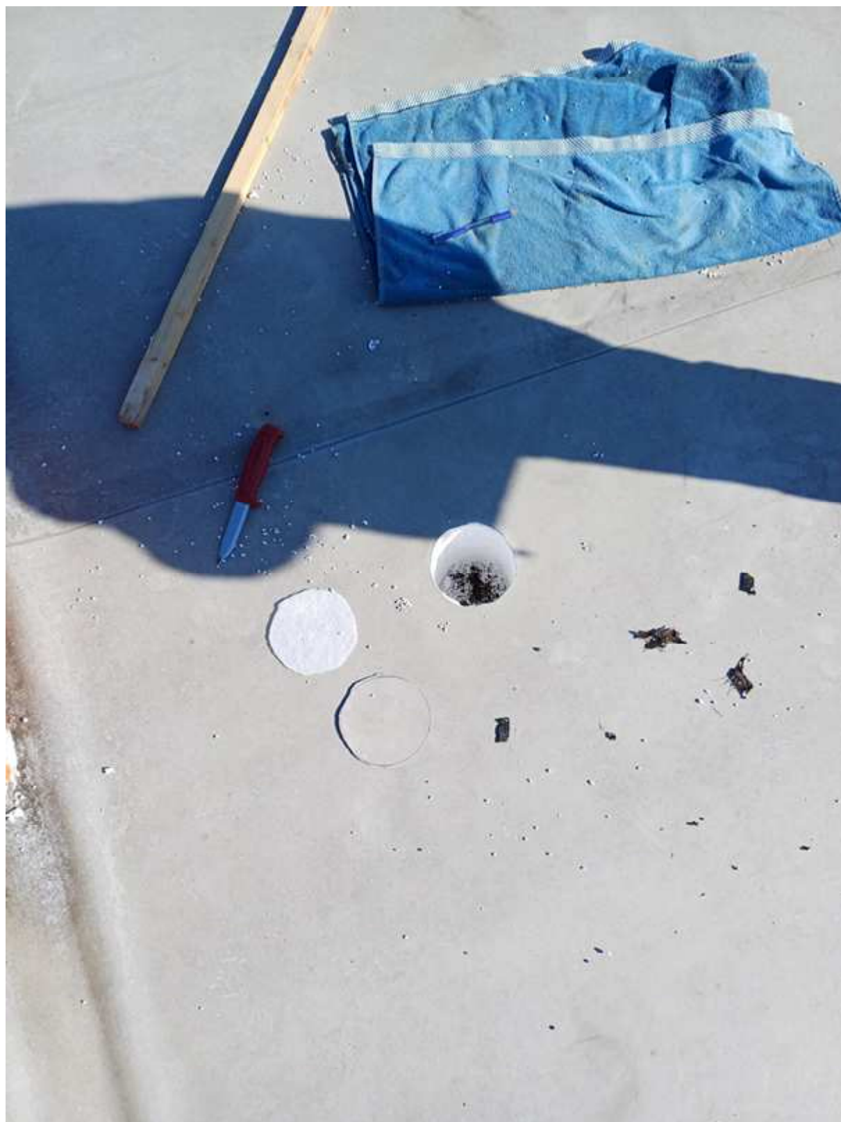
Fotografie 23 – Poskytnuto objednatelem zprávy – Pohled na sondu střechy.
