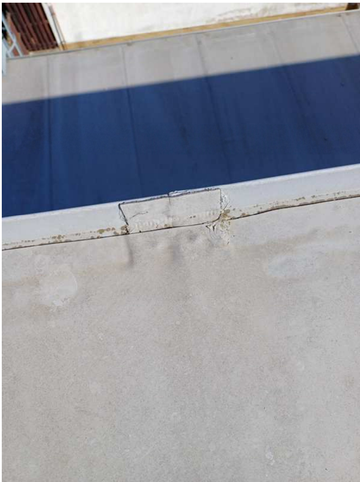
Fotografie 21 – Poskytnuto objednatelem zprávy – Nedokonalé provedení přepáskování spojů bez dilatační mezery má za následek praskání spoje.
